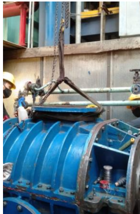
Gambar 4. 23 Pelepasan upper casing
