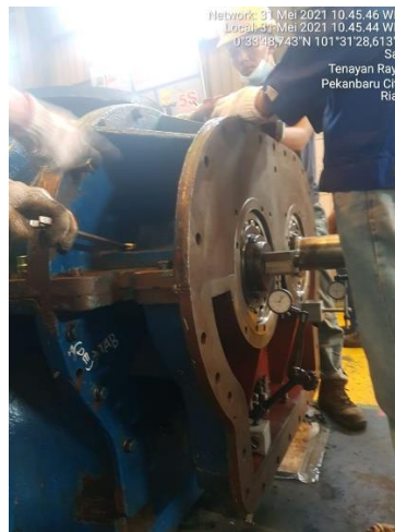
Gambar 4. 44 Install upper pedestal DE dan NDE
