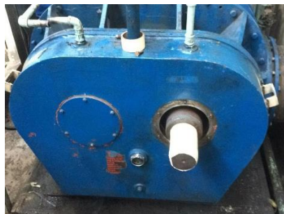
Gambar 4. 20 Pemasangan seal tape pada drat shaft
