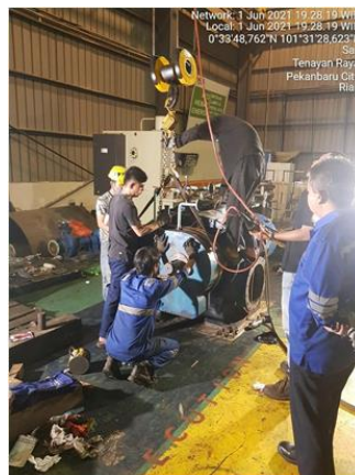
Gambar 4. 56 Pemasangan curter oil DE
