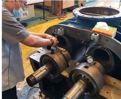
Gambar 4. 41 Pemasangan upper casing
