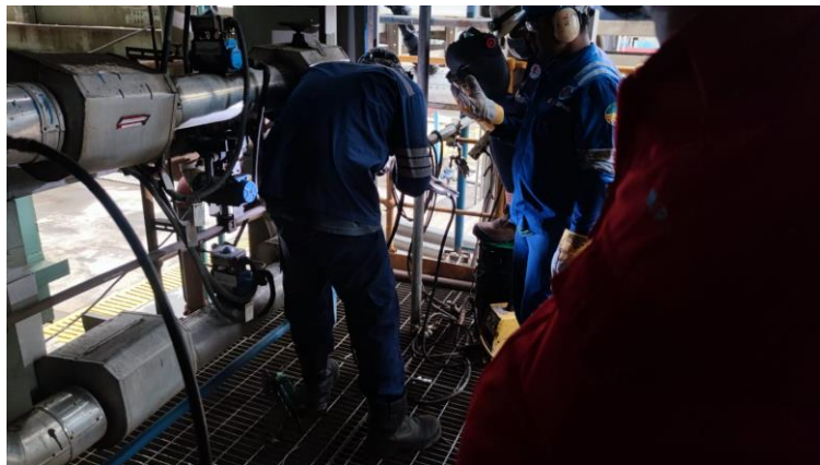
Gambar 3. 5 Pengelasan steam tube yang bocor
