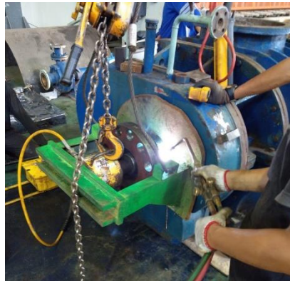
Gambar 4. 19 Pemasangan special tool
