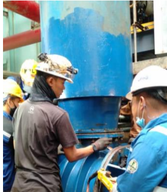
Gambar 4. 60 Pemasangan filter silincer
