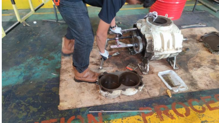
Gambar 3. 6 Perbaikan root blower
