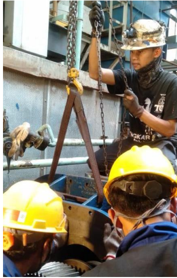
Gambar 4. 29 Pelepasan upper pedestal
