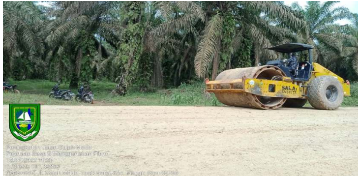
Gambar 3.19 Pematatan Sumber : Dokumentasi lapangan, 2022
