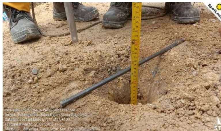
Gambar 3.22 Pengujian test pit
