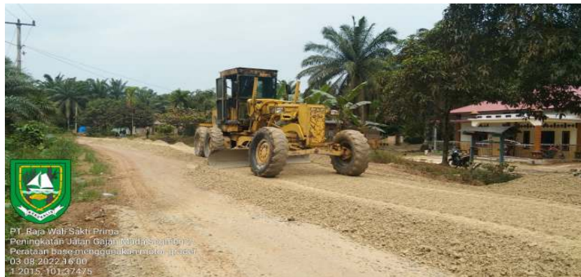
Gambar 3.17 perataan base b Sumber : Dokumentasi lapangan, 2022
