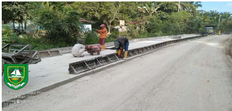
Gambar 3.31 Pemasangan mall rigid
