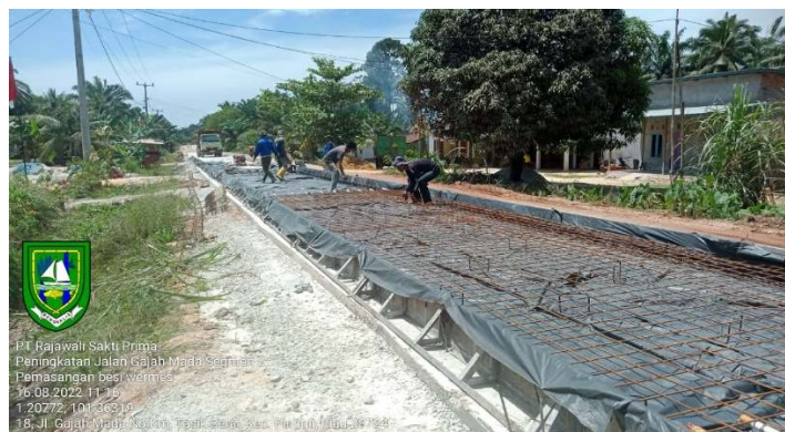
Gambar 3.34 Pemasangan besi tulangan
