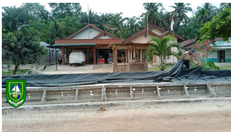
Gambar 3.32 Pemasangan plastic alas
