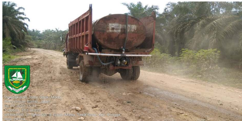
Gambar 3.18 Penyiraman Sumber : Dokumentasi lapangan, 2022
