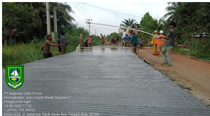
Gambar 3.40 Pembuatan alur grooving
