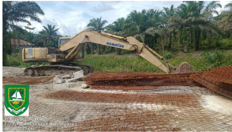
Gambar 3.3 excavator Sumber : Dokumentasi lapangan, 2022
