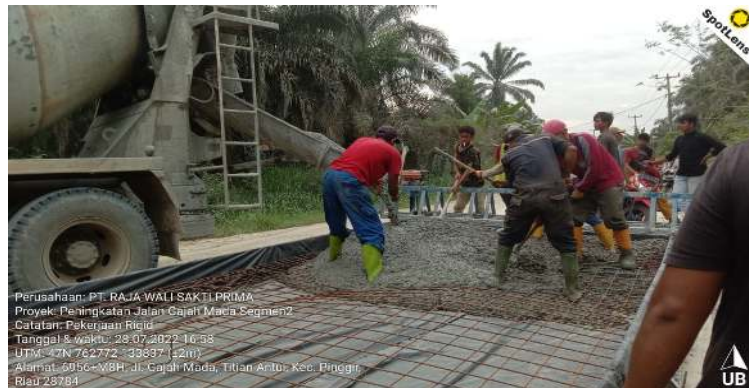
Gambar 3.38 Penghamparan beton rigid
