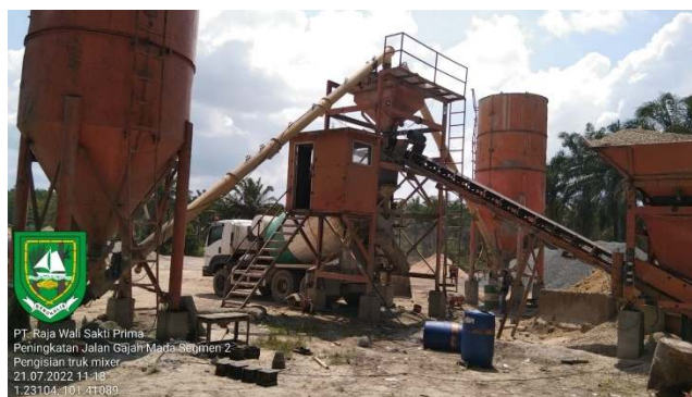
Gambar 3.25 Pembuatan beton ready mix
