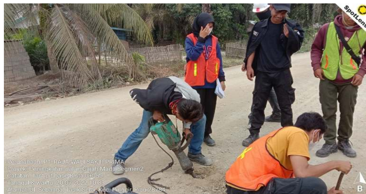
Gambar 3.21 Pengujian test pit
