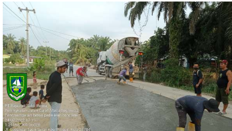
Gambar 3.10 Truck Mixer Sumber: Dokumentasi lapangan, 2022
