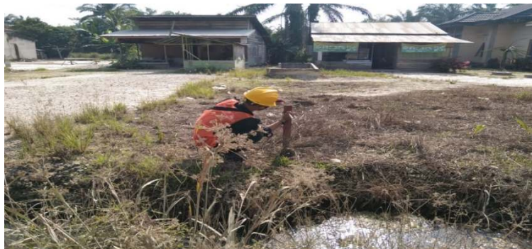
Gambar 3.13 perletakan patok per sta Sumber : Dokumentasi lapangan, 2022
