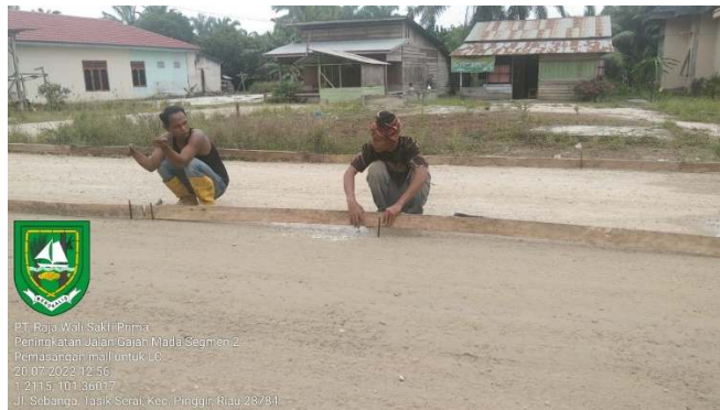
Gambar 3.24 Pemasangan mall lc
