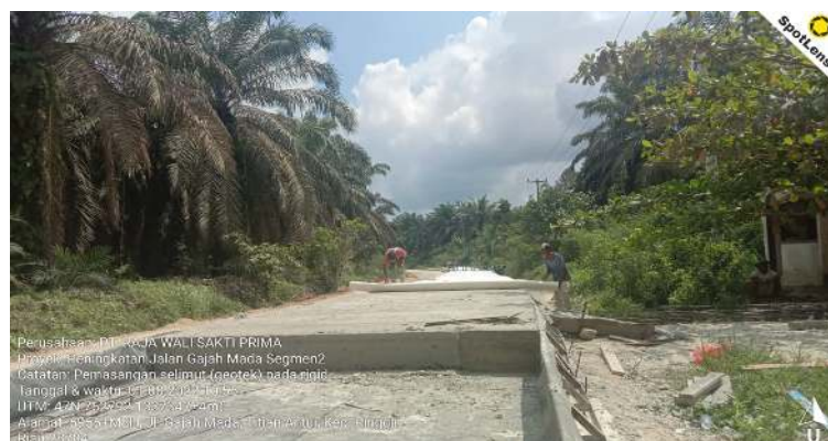
Gambar 3.42 Pemasangan geotextille non woven
