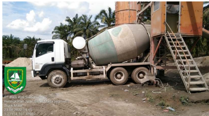
Gambar 3.35 Pembuatan beton ready mix
