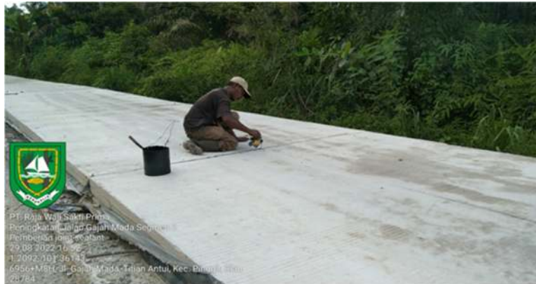
Gambar 3.44 Pemberian joint sealent Sumber: Dokumentasi lapangan, 2022
