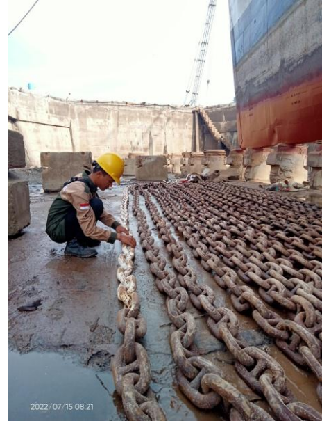
Gambar 2.12 blasting rantai jangkar
