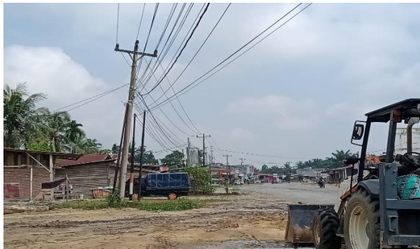
Gambar 3. 1 Orientasi lapangan proyek pelebaran dua jalur jalan raya perawang
