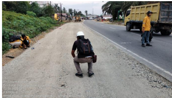
Gambar 3. 2 Pengukuran tebal base proyek pelebaran dua jalur jalan raya perawang
