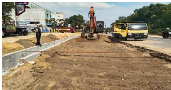
Gambar 3. 7 Penggalian bahu jalan
