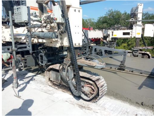
Gambar 4. 7 Pekerjaan Pematatan Beton Sumber : Dokumentasi Kerja Praktek, 2022
