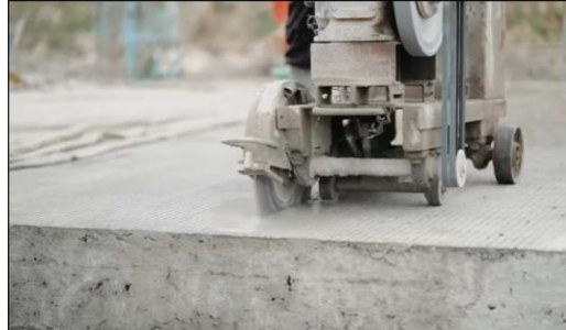
Gambar 4. 8 Pekerjaan Cutting Beton
