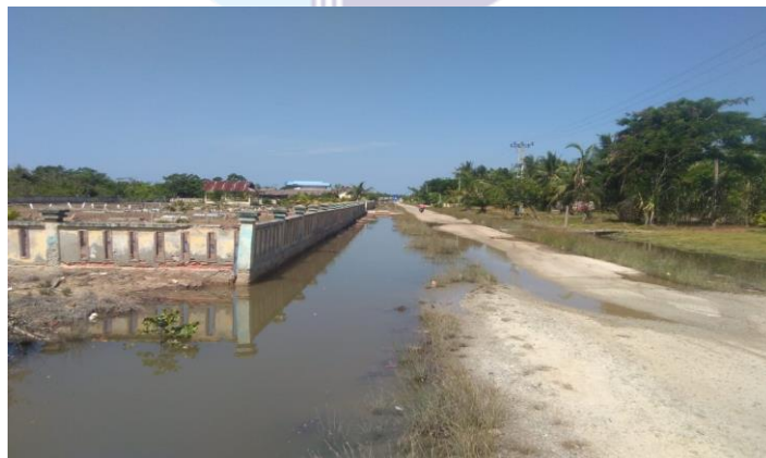
Gambar 1.1 Kondisi drainase (saluran tanah) di Jalan Pelajar Desa Kelemantan pada saat air pasang
