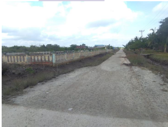
Gambar 1.2 drainase (saluran tanah) di Jalan Pelajar Desa Kelemantan pada saat tidak banjir
