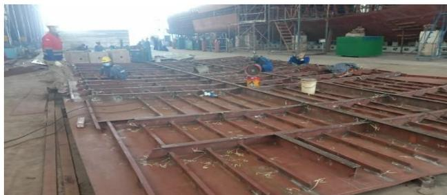
**Gambar 2.104** Cek Cacat Las Pada *Main Deck*
