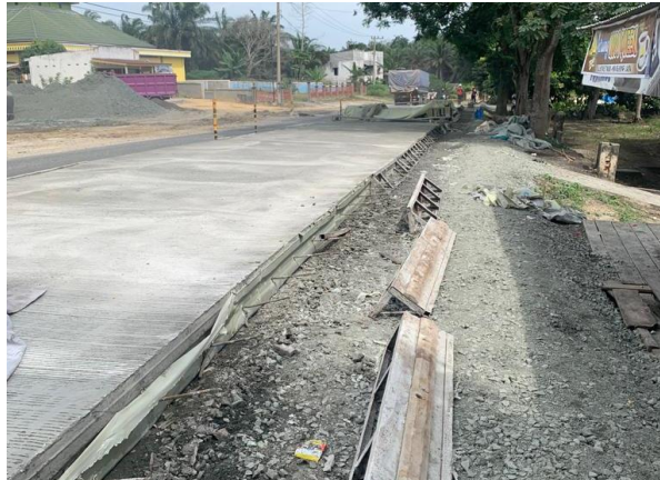
Gambar 4.17. Pembongkaran Bekisting
