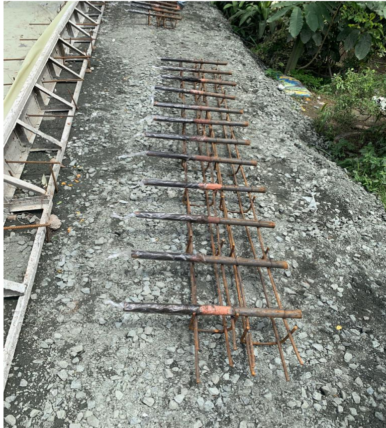
Gambar 3.20 Pekerjaan Pemasangan Tulangan Dowel
