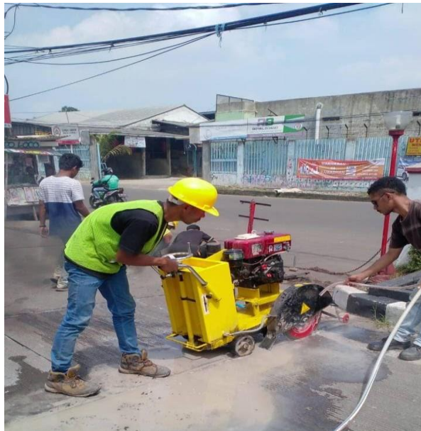
Gambar 4.16. Pekerjaan Pemotongan Beton
