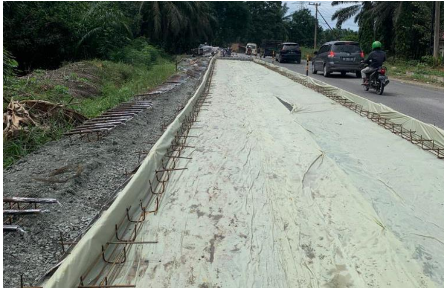
Gambar 4.9. Pemasangan Tulangan Tie Bar
