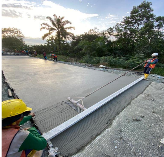
Gambar 4.15. Pekerjaan Grooving
