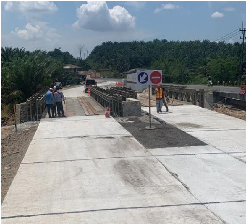
Gambar 3.23 Pekerjaan Rekonstruksi Jembatan Kerinci Kecil
