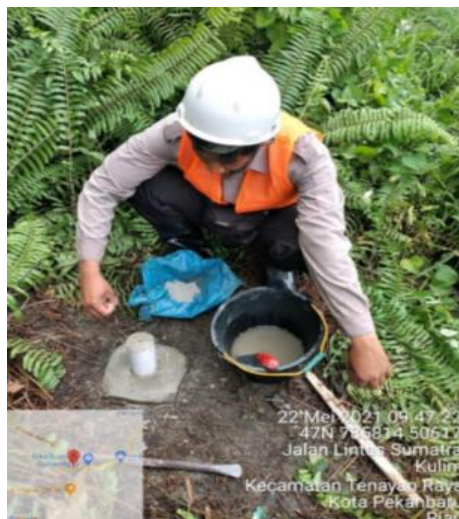
Gambar 4.1. Pembentukan Titik BM Pengukuran
