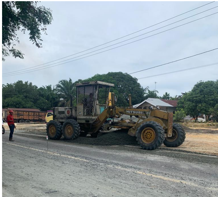
Gambar 3.15 Pekerjaan Penimbunan base
