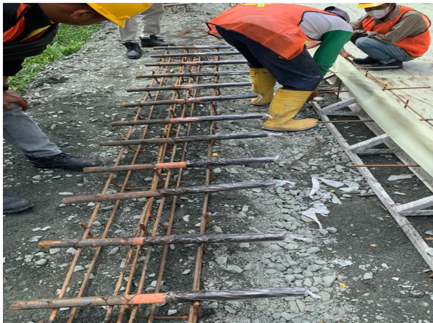
Gambar 4.8. Perakitan Tulangan Dowel
