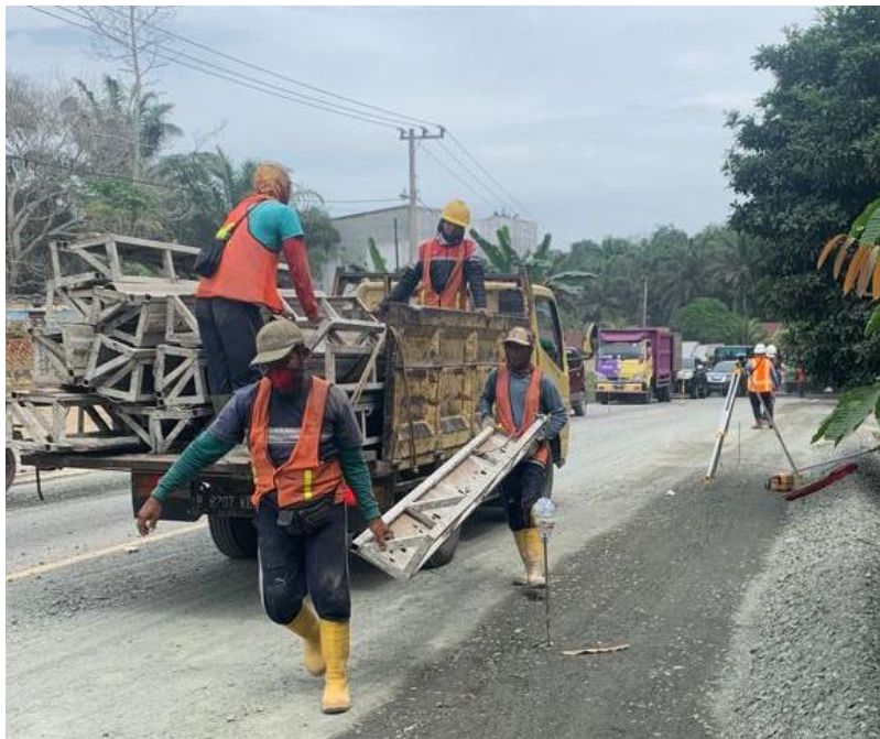
Gambar 4.5. Pemasangan Bekisting Sumber : Dokumen Kerja Praktek, 2022
