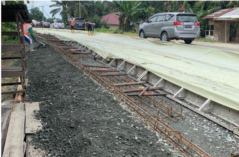
Gambar 4.7. Pemasangan Terpal Plastik
