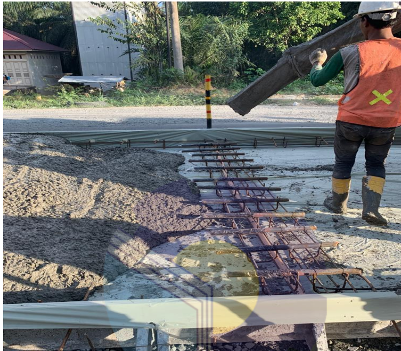
Gambar 4.10. Penghamparan Campuran Beton
