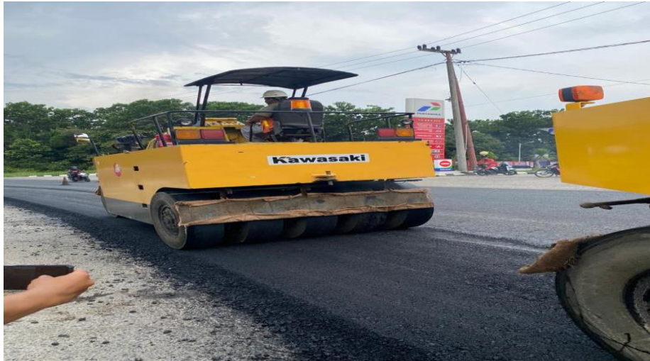
Gambar 3.11 Pemasangan Menggunakan Pneumatic Tyre Roller
