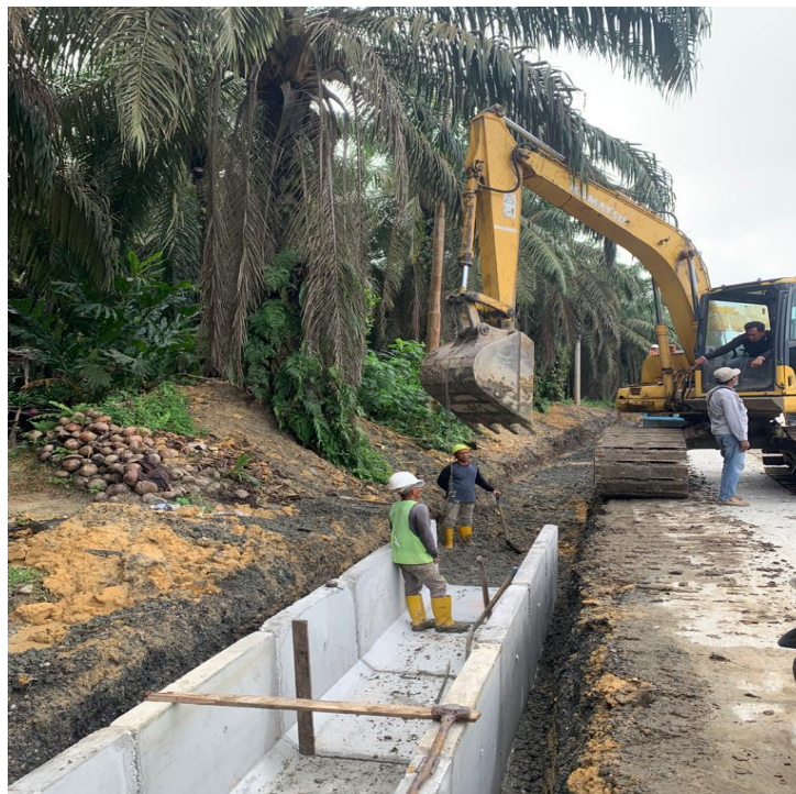
Gambar 3.22 Pekerjaan Saluran U-Ditch
