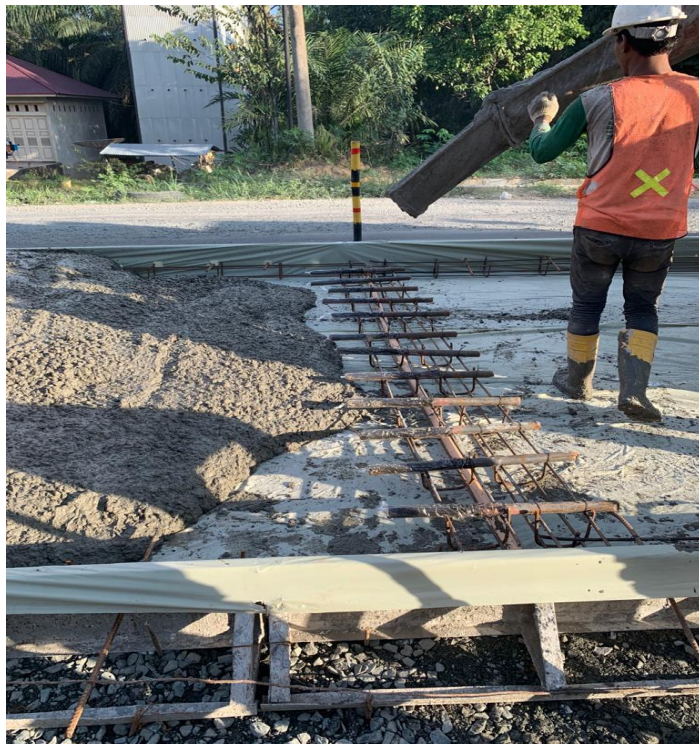
Gambar 3.21 Pekerjaan Pengecoran Beton
