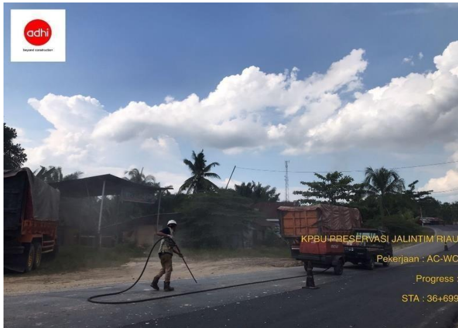
Gambar 3.5 Pembersihan lahan menggunakan Compressor Sumber : Dokumentasi Kerja Praktek, 2022
