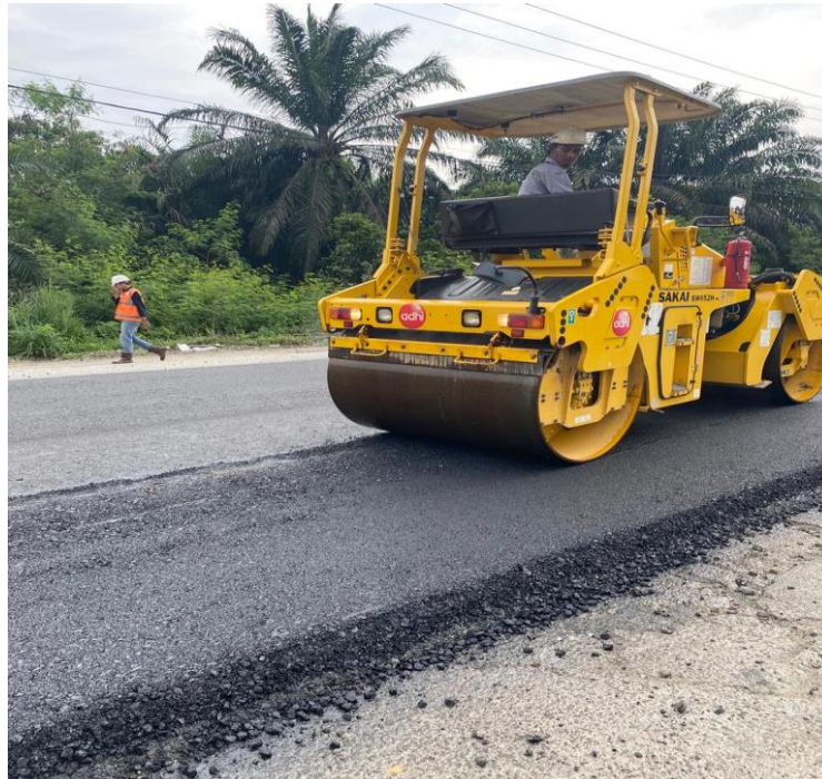
Gambar 3.10 Pematatan Menggunakan Tandem Roller
