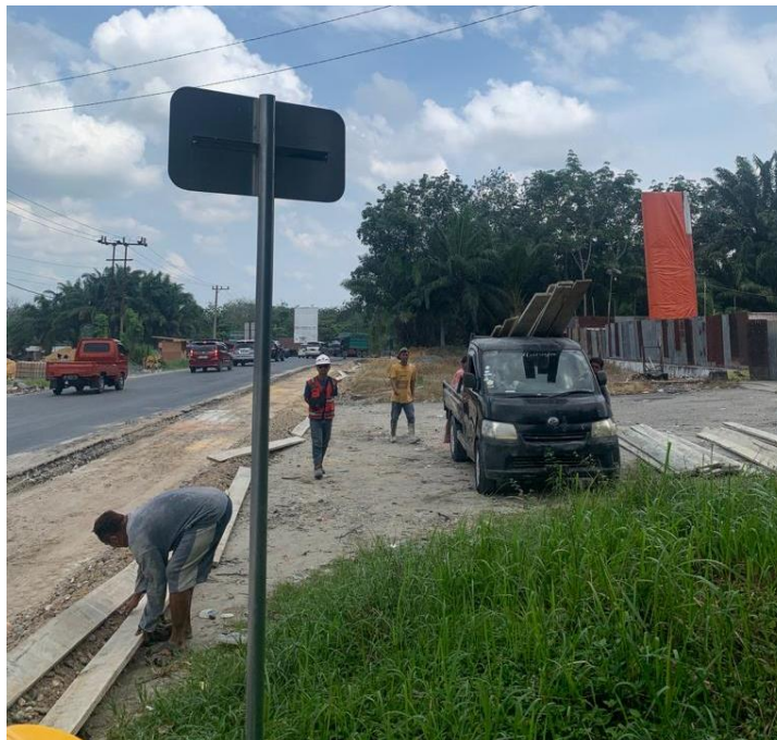
Gambar 3.18 Pekerjaan Pemasangan Bekisting Bahu Jalan
