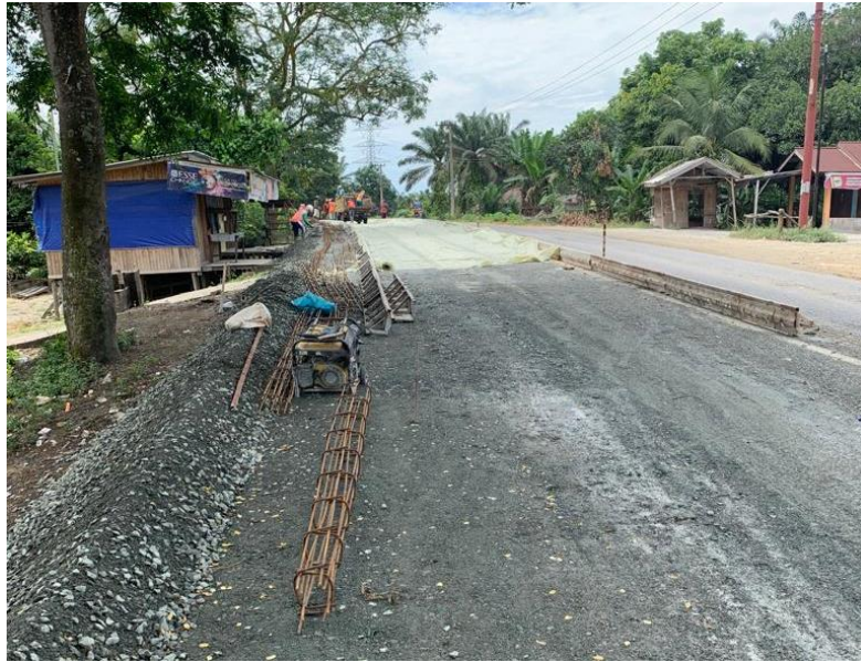
Gambar 4.6. Pemasangan Bekisting Sumber : Dokumen Kerja Praktek, 2022
