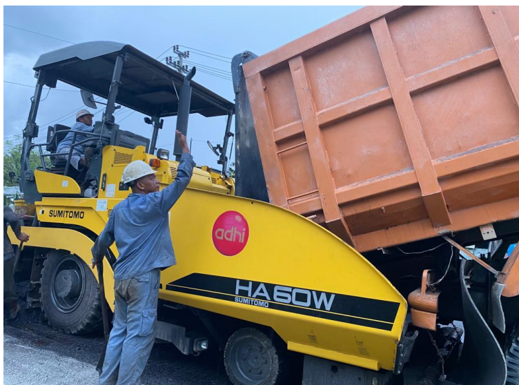
Gambar 3.9 Pemindahan Material ke Aspal Finisher
