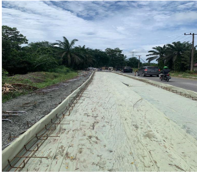
Gambar 3.19 Pekerjaan Pemasangan Terpal
