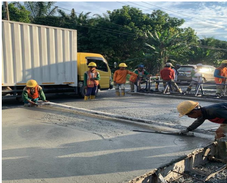
Gambar 4.14. Perataan Menggunakan Roskam Kayu
