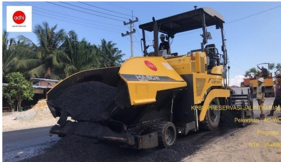
Gambar 3.7 Pekerjaan Penghamparan AC-WC
