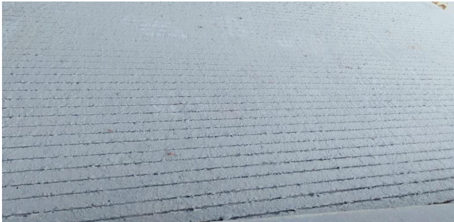
Gambar 3.17. Slab beton yang sudah di grooving (Sumber : Dokumentasi Lapangan, 2022)
