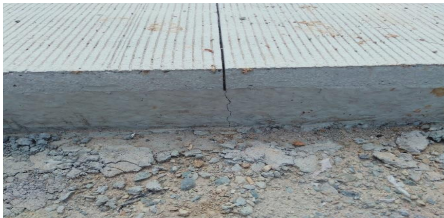
Gambar 3.19. Hasil pemotongan beton (Sumber : Dokumentasi Lapangan,2022)
