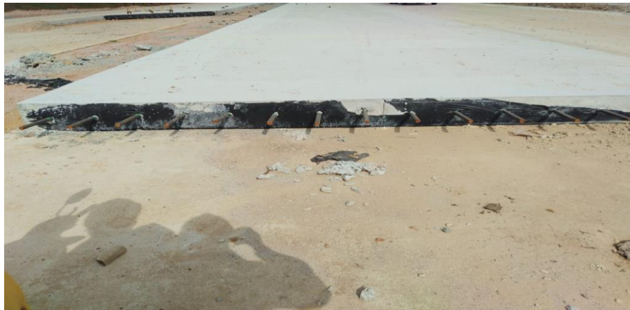
Gambar 3.13. Slab beton (Sumber : Dokumentasi Lapangan,2022)
