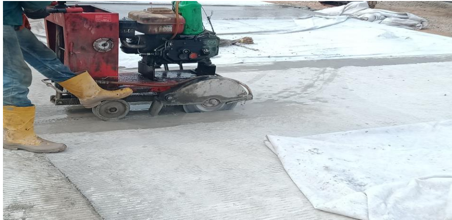
Gambar 3.18. Pemotongan segmen beton (Sumber : Dokumentasi Lapangan,2022)
