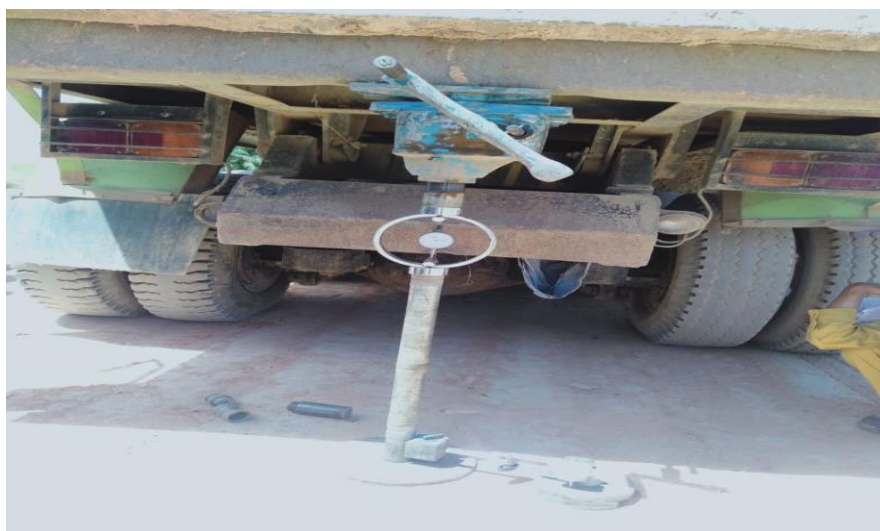
Gambar 3.7. Pengujian CBR lapangan (Sumber : Dokumentasi Lapangan, 2022)
