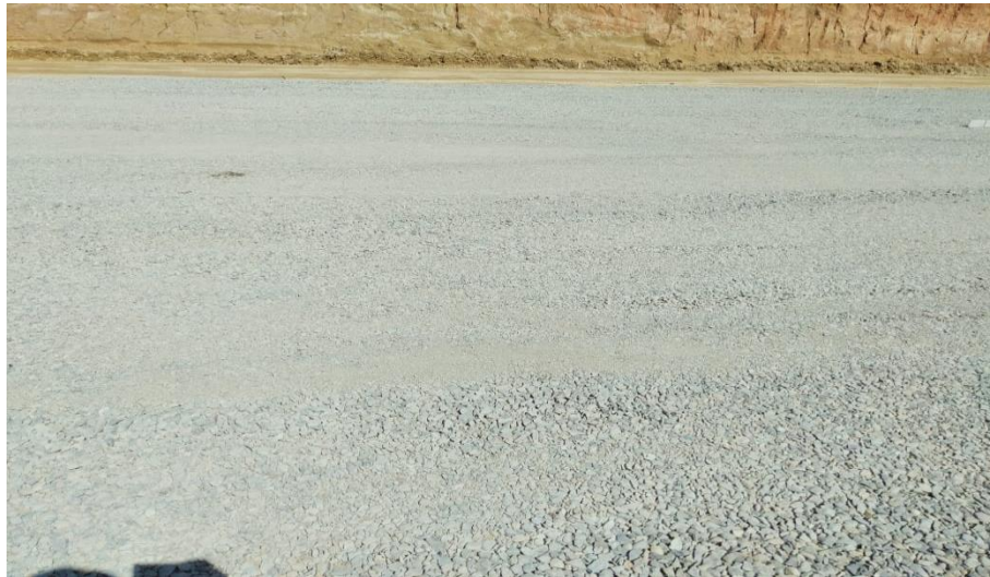
Gambar 3.9. Lapisan drainase (Sumber : Dokumentasi Lapangan,2022)
