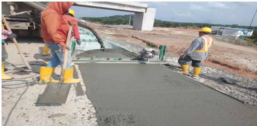
Gambar 3.20. Pelaksanaan rigid manual (Sumber : Dokumentasi Lapangan,2022)
