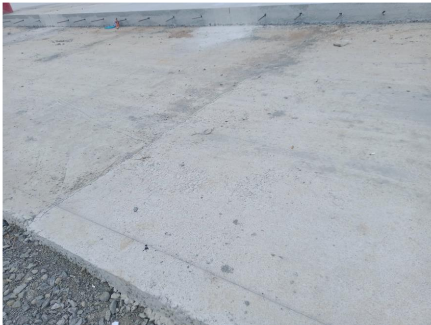
Gambar 3.10. Lean Concrete (Sumber : Dokumentasi Lapangan,2022)
