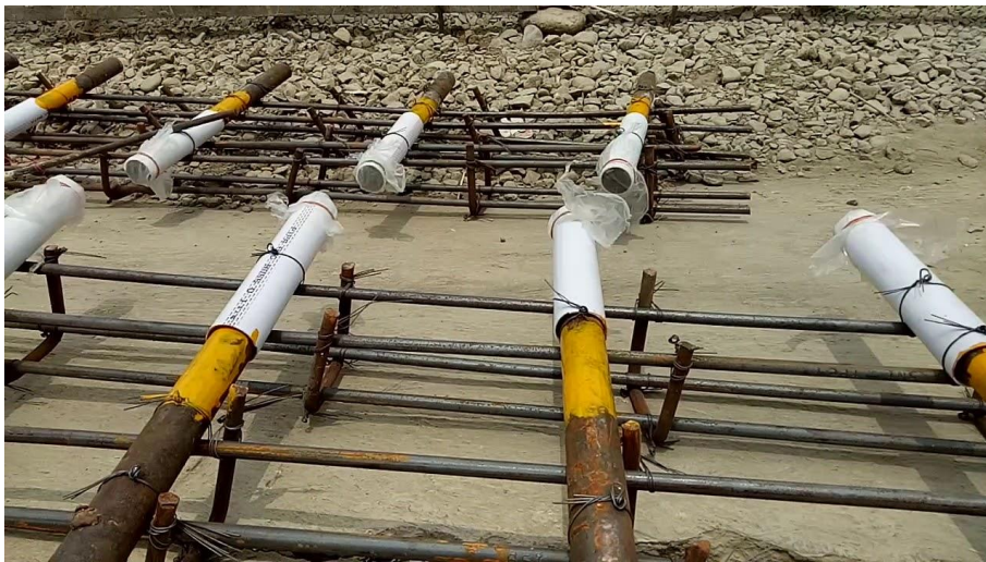
Gambar 3.21. Dowel (Sumber : Dokumentasi Lapangan, 2022)
