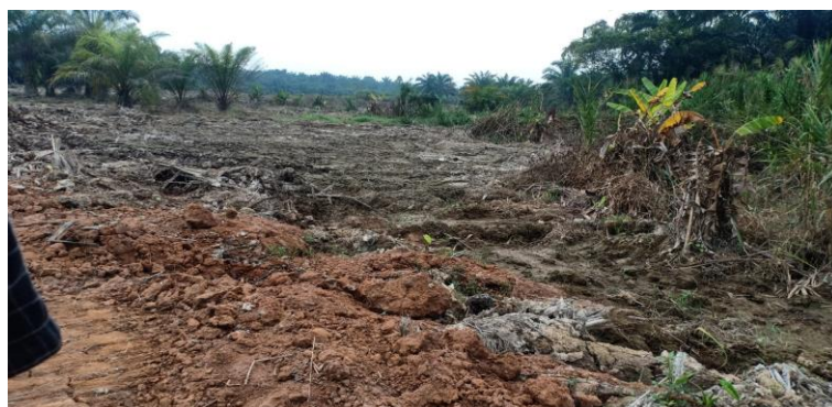
Gambar 3.3. Pembersihan lahan yang akan dibuat jalan (Sumber : Dokumentasi Pribadi, 2022)
