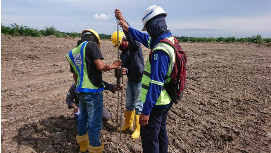
Gambar 3.4. Pengujian DCP pekerjaan clearing (Sumber : Dokumentasi Lapangan, 2022)
