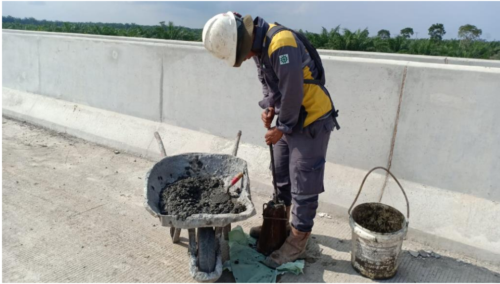
Gambar 3.11. Pembuatan benda uji slump (Sumber : Dokumentasi Lapangan,2022)
