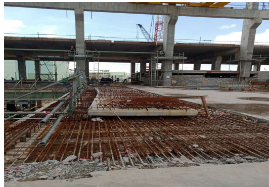
Gambar 3. 25 Slab yang sudah di pasang
