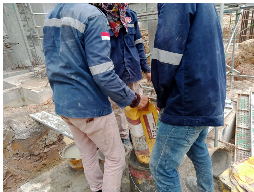
Gambar 3. 27 Pencampuran sika dan air
