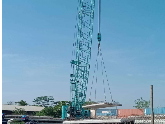
Gambar 3. 20 Pengangkatan slab
