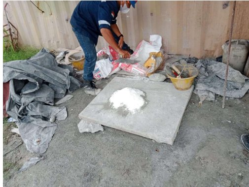
Gambar 3. 36 Pencampuran semen hitam dan putih
