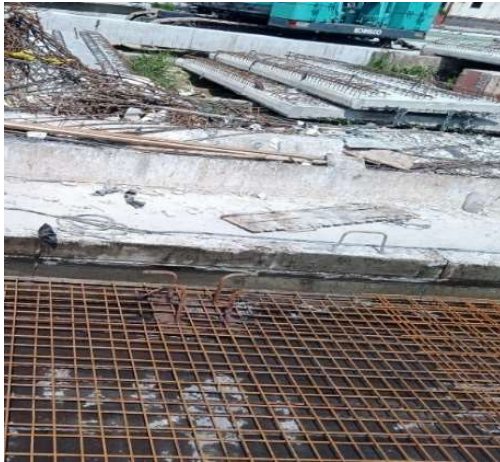
Gambar 3. 8 Pemasangan embedded plat
