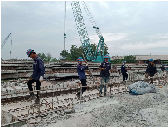
Gambar 3. 17 Pembengkokan sheere conector
