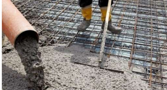
Gambar 3. 14 Pengecoran slab
