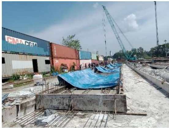
Gambar 3. 15 Perawatan beton
