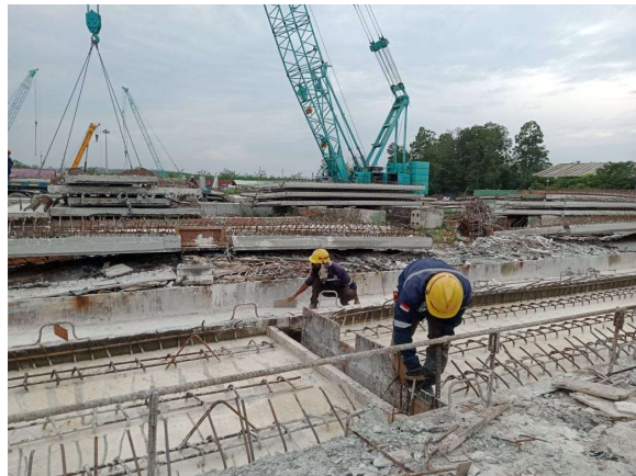
Gambar 3. 18 Pembongkaran slab
