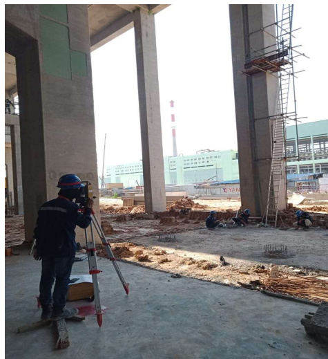
Gambar 3. 34 Pengukuran horizontal dan vertikal kolom
