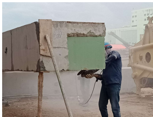
Gambar 3. 38 Proses penghalusan
