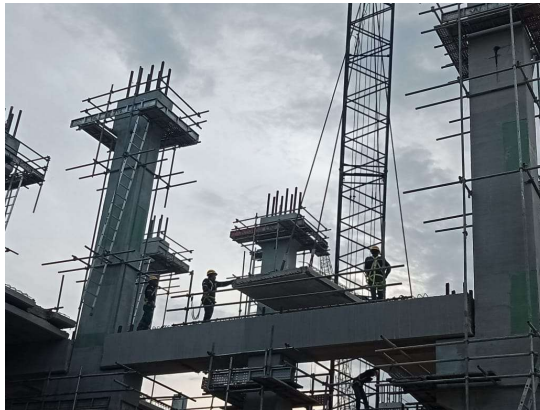
Gambar 3. 24 Pemasangan slab
