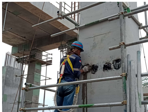
Gambar 3. 30 Proses pendempulan
