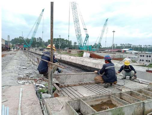
Gambar 3. 7 Penutupan pintu moulding
