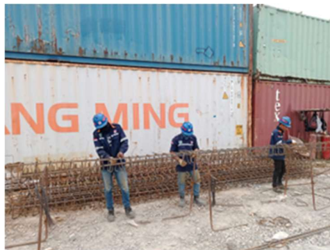
Gambar 3. 4 Proses Perakitan Tulangan
