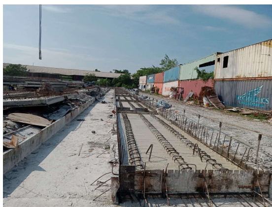
Gambar 3. 16 Slab yang sudah mengeras
