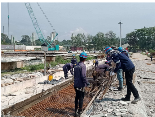
Gambar 3. 10 Pemasangan shere conector
