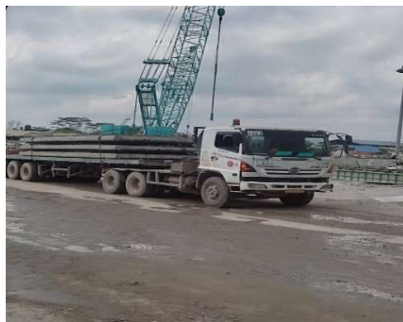
Gambar 3. 21 Pengantaran slab kelokasi erection
