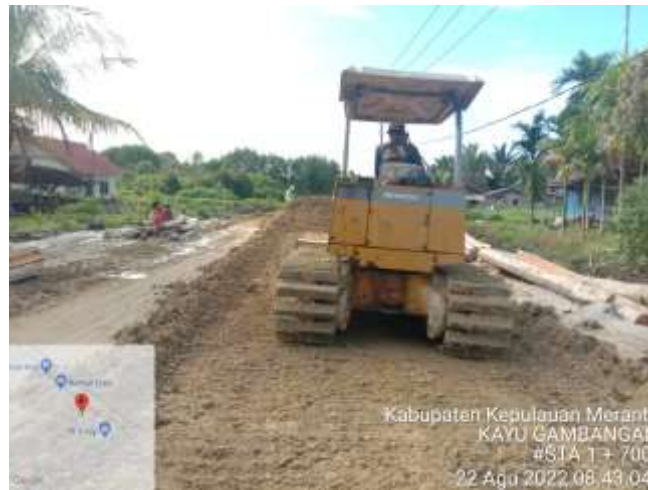
Gambar 3. 13 Pemasangan kayu gambangan Sumber: (Dokumentasi 2022)
