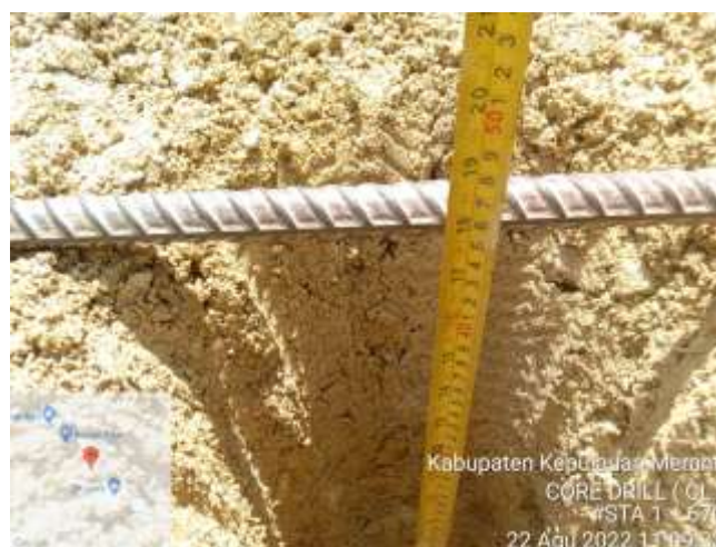
Gambar 3. 12 pengukuran Core Drill Sumber: (Dokumentasi 2022)
