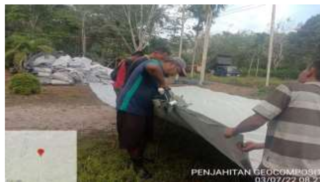
Gambar 3. 7 Penjahitan geocomposit Sumber: (Dokumentasi 2022)
