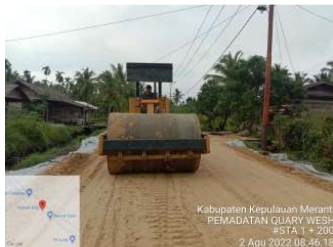
Gambar 3. 10 Pemasatan Sumber: (Dokumentasi 2022)
