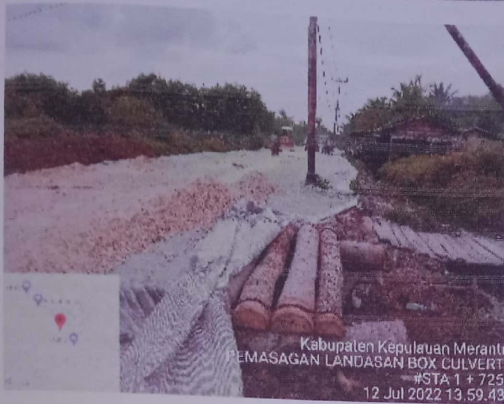
Pemasangan landasan box culvert
