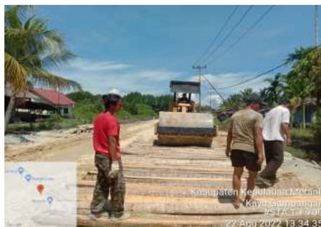
Gambar 3. 15 Kayu gambangan Sumber: (Dokumentasi 2022)
