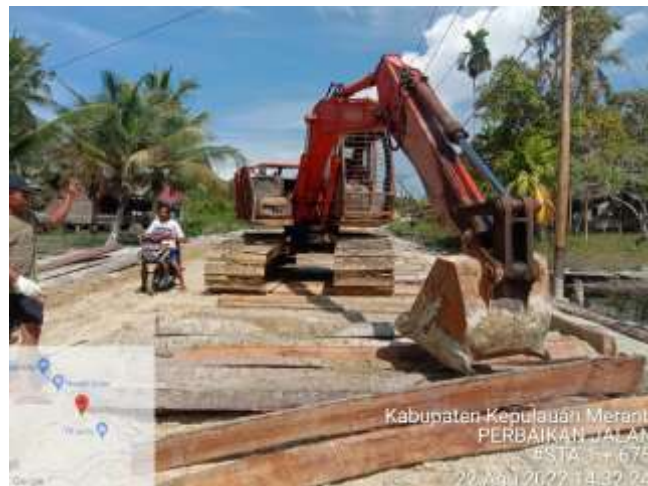
Gambar 3. 14 Kayu gambangan Sumber: (Dokumentasi 2022)
