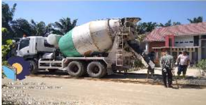
Gambar 3.5 Alat truck mixer (sumber :dokumentasi lapangan ,2022)
