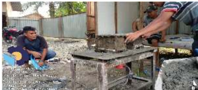
Gambar 3.14 Pekerjaan persiapan benda uji (sumber :dokumentasi lapangan ,2022)
