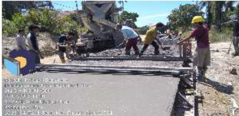
Gambar 3.15 Pekerjaan perkerasan beton dengan menggunakan alat manual (sumber :dokumentasi lapangan ,2022)
