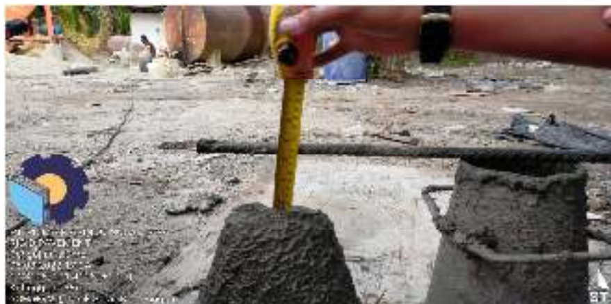
Gambar 3.18 Uji slump (Sumber : Dokumentasi Lapangan,2021)
