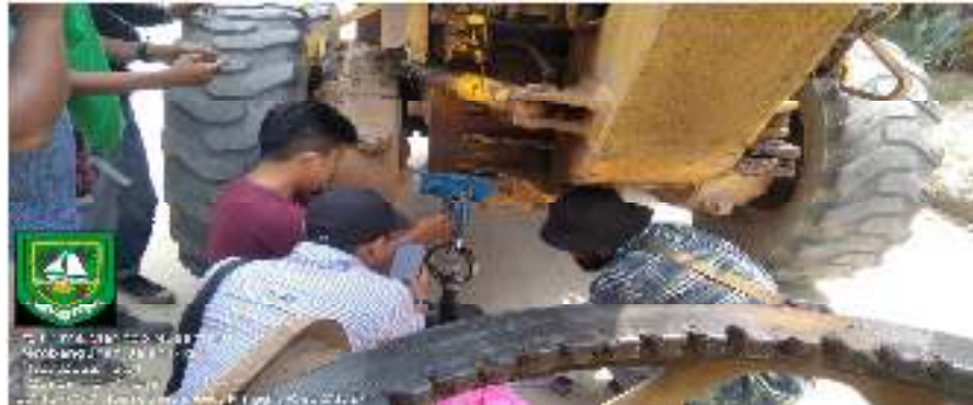
Gambar 3.11 Pengujian CBR (sumber : dokumentasi lapangan ,2022)
