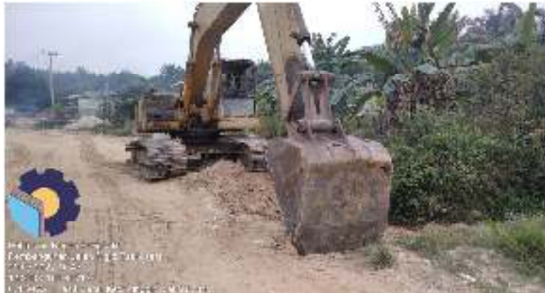
Gamabar 3.9 Alat excavator (sumber :dokumentasi lapangan ,2022)
