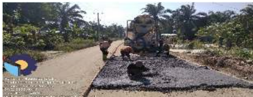
Gambar 3.12 Pekerjaan Lean Concrete (sumber : dokumentasi lapangan ,2022)
