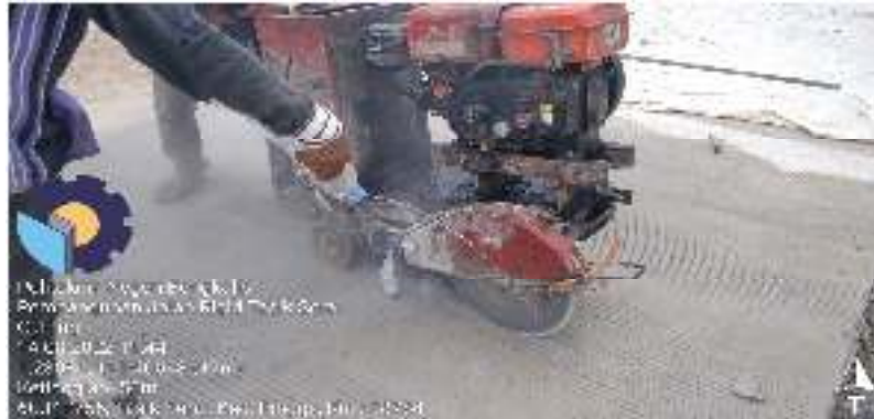
Gamabr 3.19 Pekerjaan cutting (Sumber : Dokumentasi Lapangan,2022)
