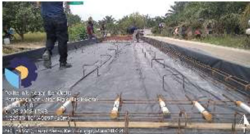
Gambar 3.17 Dowel (Sumber : Dokumentasi Lapangan,2022)
