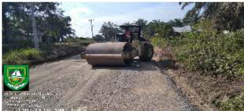
Gambar 3.6 Alat vibro roller (sumber :dokumentasi lapangan ,2022)
