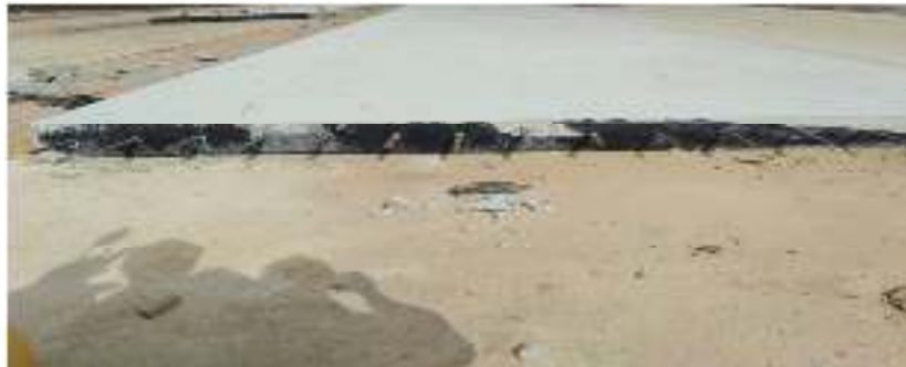
Gambar 3.16 Pekerjaan slab beton (sumber :dokumentasi lapangan ,2022)
