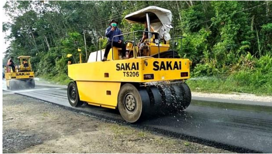
Gambar 3. 16 : Pemasangan Roda Karet Sumber : Dokumentasi Lapangan, 2022
