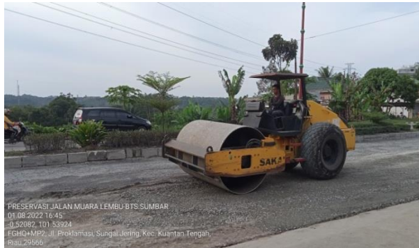
Gambar 3. 11 : Pemasangan Base A Sumber : Dokumentasi Lapangan, 2022
