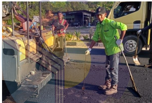
Gambar 3. 14 : Pengecekan Ketebalan Aspal Sumber : Dokumentasi Lapangan, 2022
