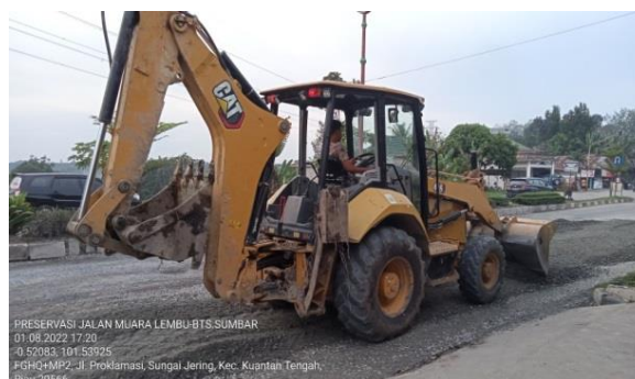
Gambar 3. 10 : Meratakan Material Base A Sumber : Dokumentasi Lapangan, 2022
