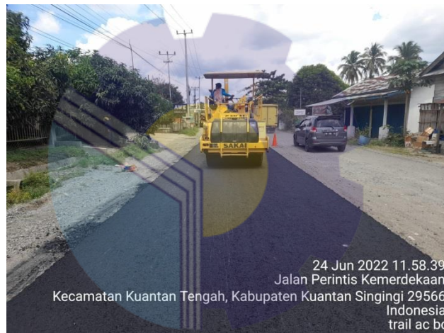
Gambar 4. 4 : Pemadatan Awal dengan Alat TR Sumber : Dokumentasi Lapangan, 2022
