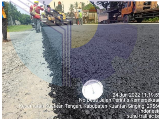
Gambar 4. 3 : Pengecekan Suhu Penghamparan AC-BC
