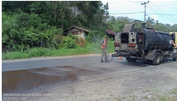
Gambar 3. 12 : Proses Penyemprotan Tack Coat Sumber : Dokumentasi Lapangan, 2022
