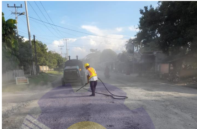
Gambar 4. 1 : Pembersihan Permukaan diatas Lapis Pondasi Atas Sumber : Dokumentasi Lapangan, 2022
