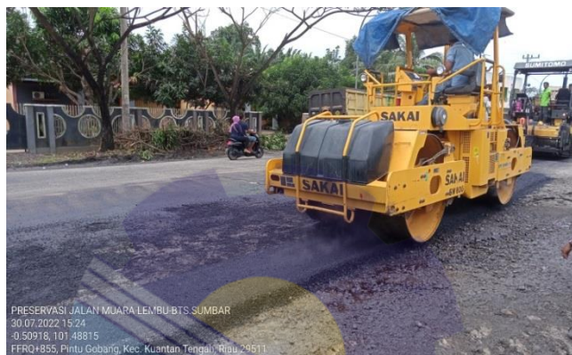
Gambar 3. 6 : Pemasakan CAP Sumber : Dokumentasi Lapangan, 2022
