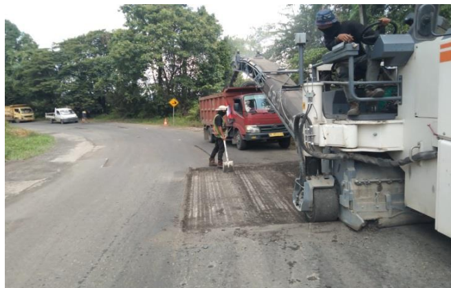
Gambar 3. 4 : Proses Penggerukan Sumber : Dokumentasi Lapangan, 2022
