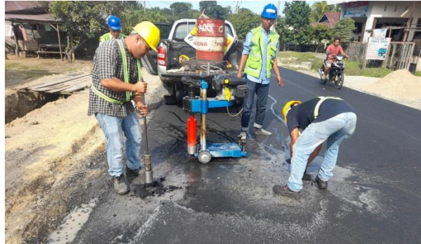
Gambar 4. 6 : Pengambilan Sampel Core Drill di Lapangan Sumber : Dokumentasi Lapangan, 2022
