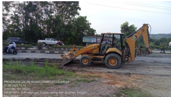
Gambar 3. 7 : Pembongkaran Lapisan Jalan Sumber : Dokumentasi Lapangan, 2022
