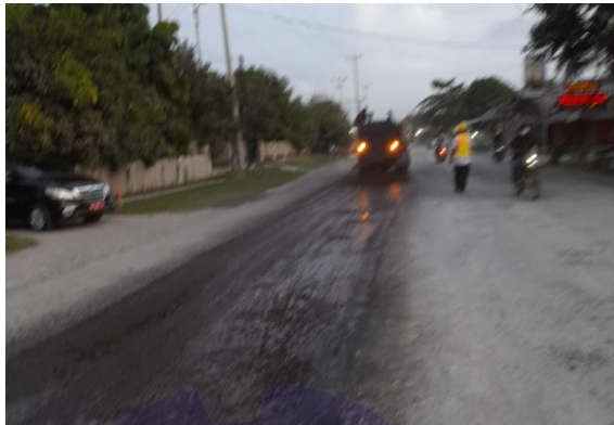
Gambar 4. 2 : Penyemprotan Prime Coat STA 00+850 Sumber : Dokumentasi Lapangan, 2022
