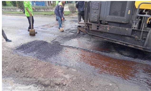
Gambar 3. 5 : Penghamparan Campuran Aspal Panas (CAP) Sumber : Dokumentasi Lapangan, 2022
