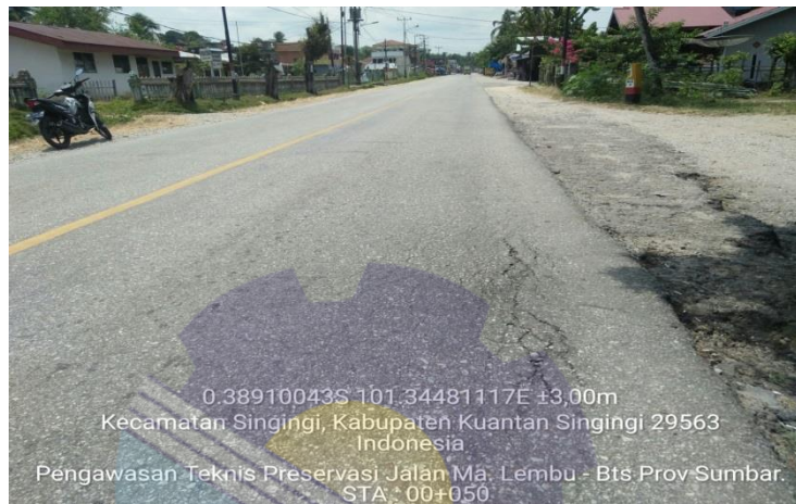
Gambar 3. 2 : Pengawasan Teknis Sumber : Dokumentasi Lapangan, 2022
