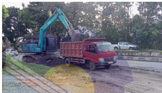
Gambar 3. 8 : Pembersihan Sisa Penggerukan Aspal Menggunakan Excavator Sumber : Dokumentasi Lapangan, 2022
