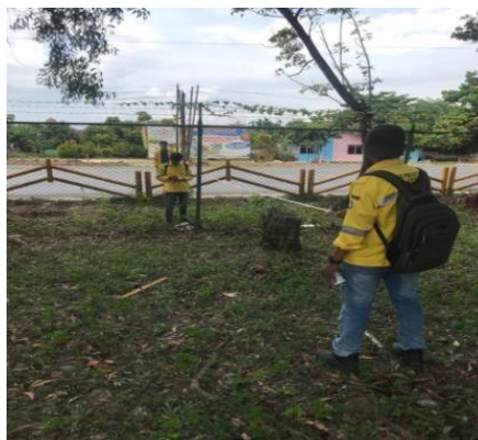
Gambar 3.1 Pengukuran badan jalan yang akan ditambah Yang mengenai pagar
