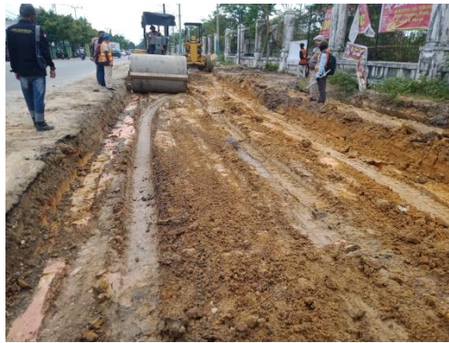
Gambar 3.7 Pematatan Tanah Timbun (Urpil) menggunakan Vibrator Roller
