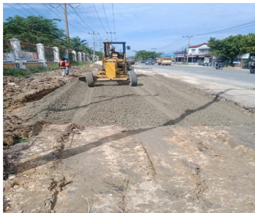
Gambar 3.9 Penghamparan Base Kelas B Menggunakan Motor Grader
