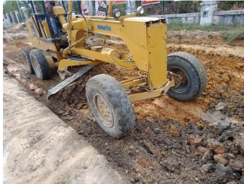
Gambar 3.6 Penghamparan Tanah Timbun (Urpil) menggunakan Motor Grader
