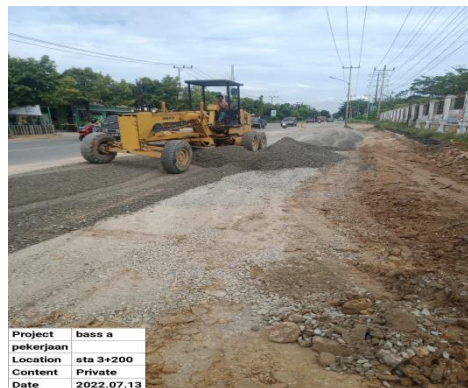
Gambar 3.10 Penghamparan Base Kelas A Menggunakan Motor Grader
