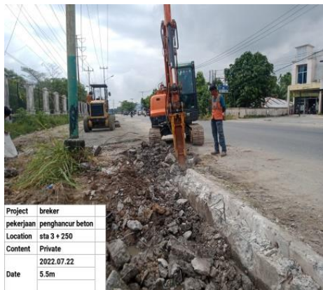
Gambar 3. 2 Pembongkaran drainase lama pada badan jalan yang direncanakan
