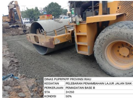
Gambar 3.11 Pemadatan Base Kelas A Menggunakan vibrator roller
