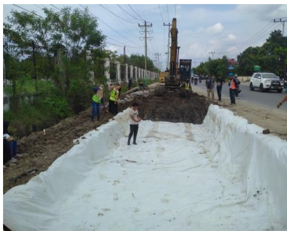
Gambar 3.4 Pemasangan Geotextile/ Woven
