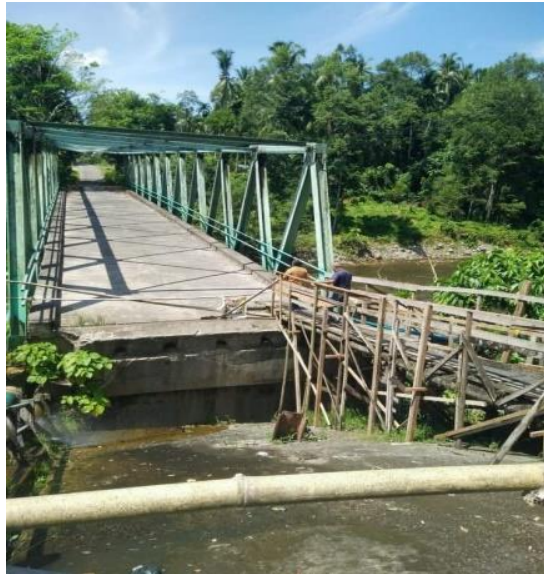
Gambar 1. 1 Jembatan Sebelum di Rehabilitasi
