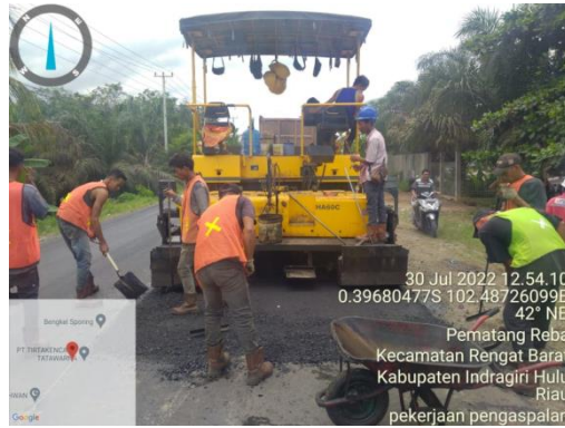
Gambar 4.19 Penghamparan Laston Lapis Aus (AC-WC) (Sumber: Dokumentasi Lapangan Kerja Praktek 2022)
