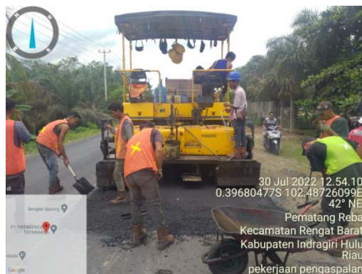
Gambar 3.7 Penghamparan Laston Lapis Aus (AC-WC) (Sumber: Dokumentasi Lapangan Kerja Praktek 2022)
