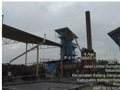
Gambar 4.11 Pengeringan Agregat di Unit Dryer (Sumber: Dokumentasi Lapangan Kerja Praktek 2022)
