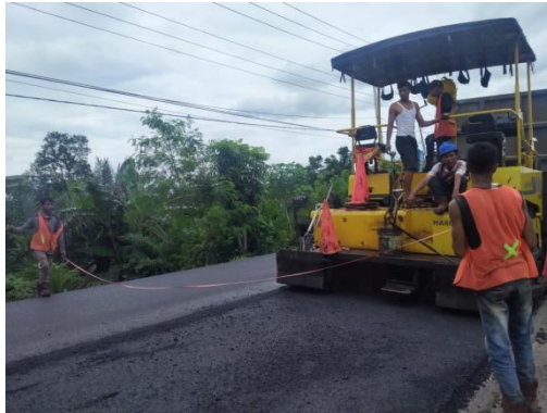
Gambar 3.8 Pengecekan Lebar Laston Lapis Aus (AC-WC) (Sumber: Dokumentasi Lapangan Kerja Praktek 2022)
