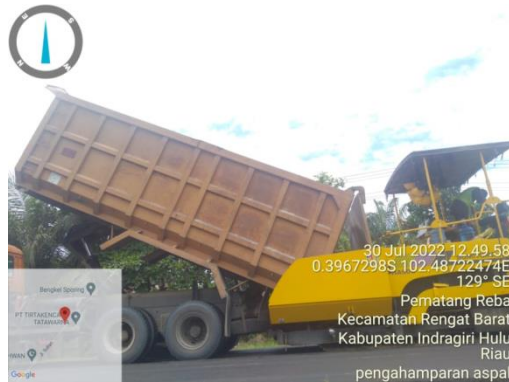
Gambar 3.5 Proses Masuk Laston Lapis Aus (AC-WC) ke dalam Asphalt Finisher (Sumber: Dokumentasi Lapangan Kerja Praktek 2022)
