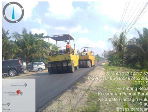
Gambar 3.10 Pematatan Menggunakan Pneumatic Tired Roller (Sumber: Dokumentasi Lapangan Kerja Praktek 2022)
