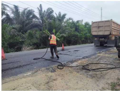
Gambar 3.1 Penyemprotan Tack Coat ( Lapis Perekat ) (Sumber: Dokumentasi Lapangan Kerja Praktek 2022)
