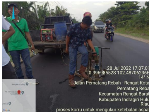
Gambar 4.8 Mesin Core Drill (Sumber: Dokumentasi Lapangan Kerja Praktek 2022)
