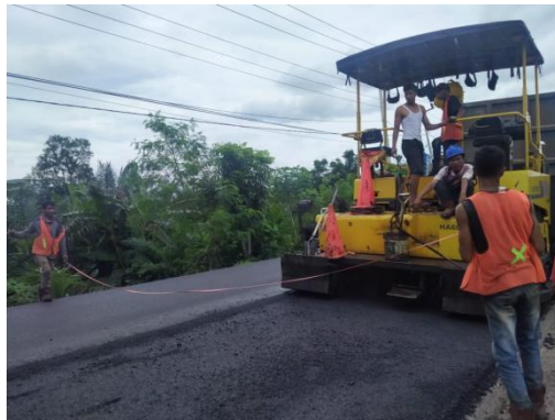
Gambar 4.20 Pengecekan Lebar Laston Lapis Aus (AC-WC) (Sumber: Dokumentasi Lapangan Kerja Praktek 2022)
