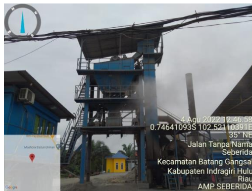
Gambar 3.3 Proses Produksi Hot Mix (Sumber: Dokumentasi Lapangan Kerja Praktek 2022)
