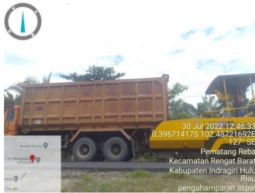
Gambar 3.4 Mobilisasi Laston Lapis Aus (AC-WC) (Sumber: Dokumentasi Lapangan Kerja Praktek 2022)
