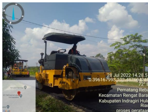
Gambar 3.9 Pemadatan Menggunakan Tandem Roller (Sumber: Dokumentasi Lapangan Kerja Praktek 2022)
