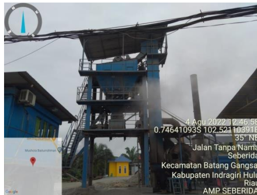
Gambar 4.13 Proses Akhir Pencampuran ( mixer/pugmill ) (Sumber: Dokumentasi Lapangan Kerja Praktek 2022)
