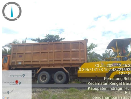
Gambar 4.16 Mobilisasi Laston Lapis Aus (AC-WC) (Sumber: Dokumentasi Lapangan Kerja Praktek 2022)
