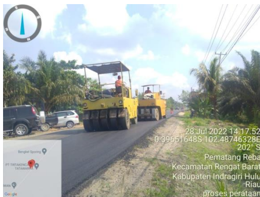
Gambar 4.22 Pematatan Menggunakan Pneumatic Tired Roller (Sumber: Dokumentasi Lapangan Kerja Praktek 2022)
