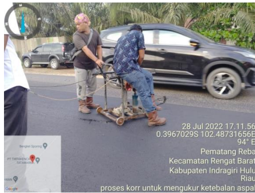
Gambar 4.23 Core Drill Test Laston Lapis Aus (AC-WC) (Sumber: Dokumentasi Lapangan Kerja Praktek 2022)
