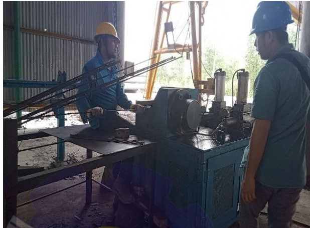
Gambar 3. 16 Pemotongan tulangan pokok
