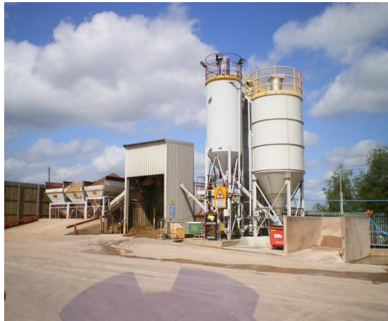
Gambar 3. 27 : Batching Plant Sumber: Dokumentasi lapangan, tahun 2022
