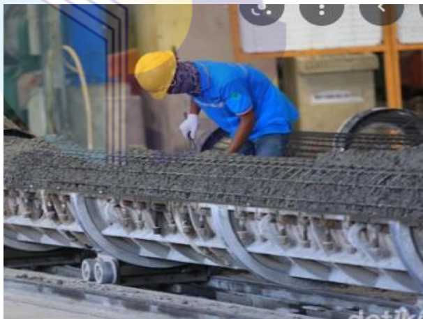
Gambar 3. 20 Pengecoran Sumber : Dokumen lapangan, 2022
