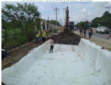
Gambar 3. 7 Pemasangan Geotextile/ Woven Sumber: dokumentasi 2022
