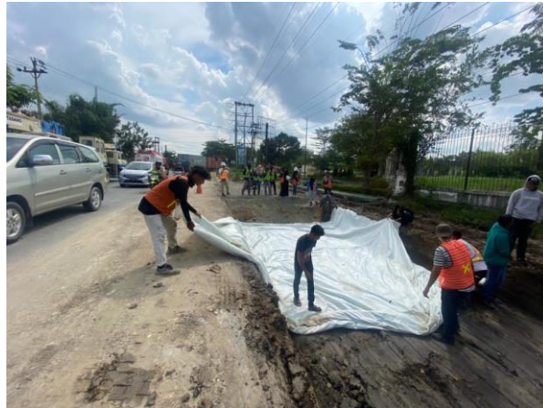
Gambar 3. 5 Pemasangan Geotextile/ Woven Sumber: dokumentasi 2022
