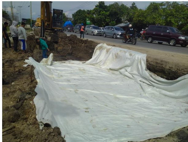
Gambar 3. 6 Pemasangan Geotextile/ Woven Sumber: dokumentasi 2022
