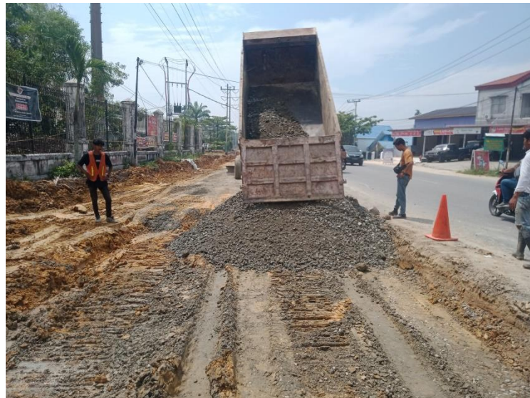
Gambar 3. 12 Penghamparan Base Kelas B Sumber: dokumentasi 2022
