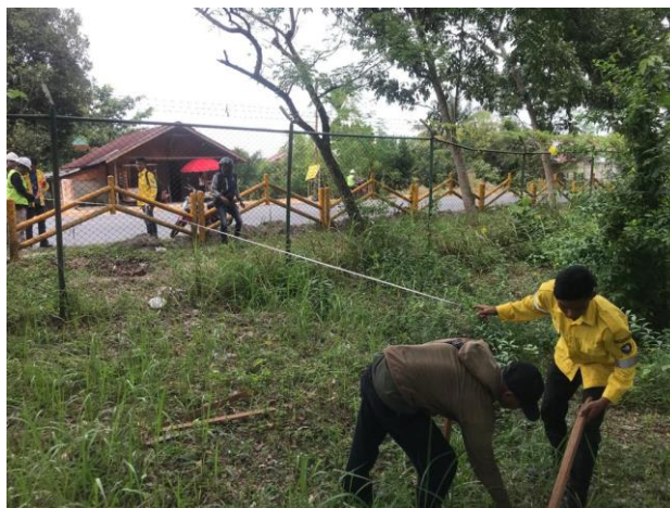
Gambar 3. 1 pengukuran badan jalan yang akan ditambah Sumber: dokumentasi 2022
