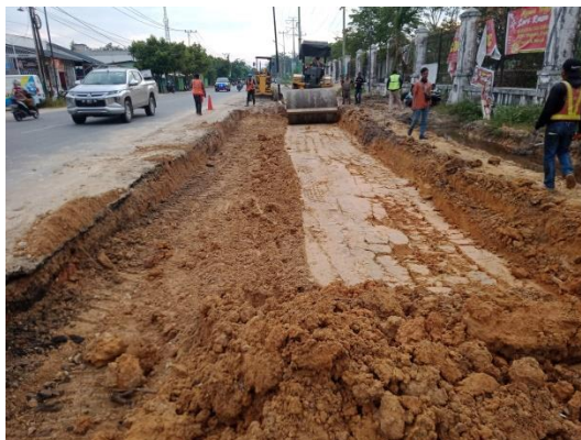
Gambar 3. 10 Pematatan Tanah Timbun(Urpil)menggunakan VibratorRoller Sumber: dokumentasi 2022
