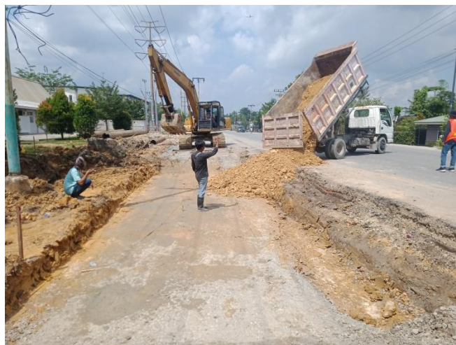
Gambar 3. 11 penghamparan Tanah Timbun(Urpil) Sumber: dokumentasi 2022
