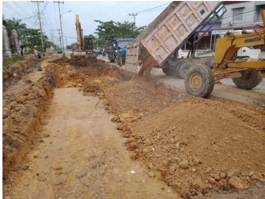
Gambar 3. 9 Penghamparan Tanah Timbun(Urpil) Sumber: dokumentasi 2022
