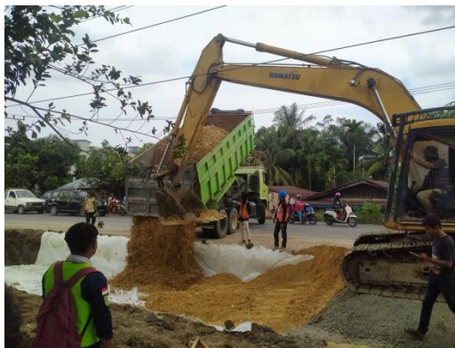
Gambar 3. 8 Penghamparan Tanah Timbun(Urpil) Sumber: dokumentasi 2022
