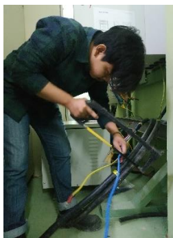
Gambar 2. 25 Proses pemasangan kabel input dan output
