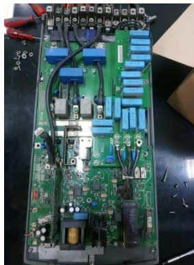
Gambar 2. 19 Melakukan proses bongkar dan perbaikan Variable Speed Drive ACS-800.
