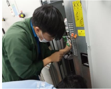
Gambar 2. 28 Pemasangan drive untuk pompa 28,38,48 di fiberline 2 (Sumber: Dokumentasi PT. Riau Andalan Pulp and Paper Pangkalan Kerinci, 2022)
