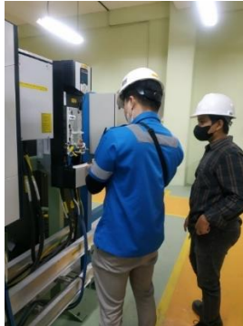
Gambar 2. 23Pengecekan VSD ACS-880
