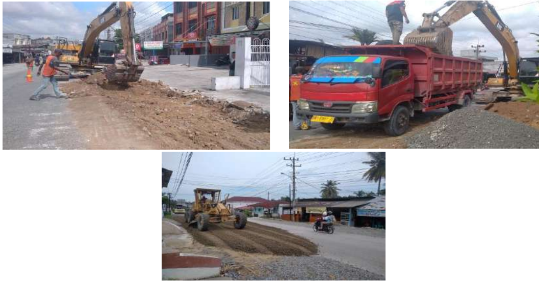
Gambar 2. 3 Penggalian Bahu Jalan dan Penghamparan Base A
