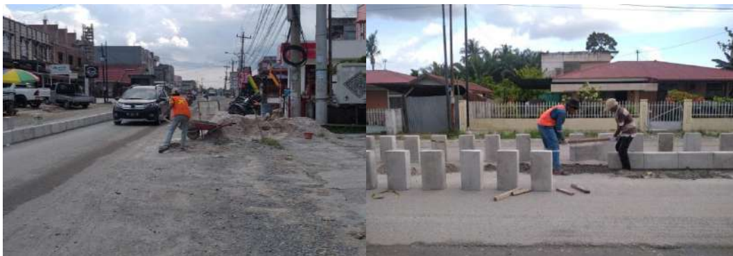
Gambar 3. 7 Pemasangan Kerb
