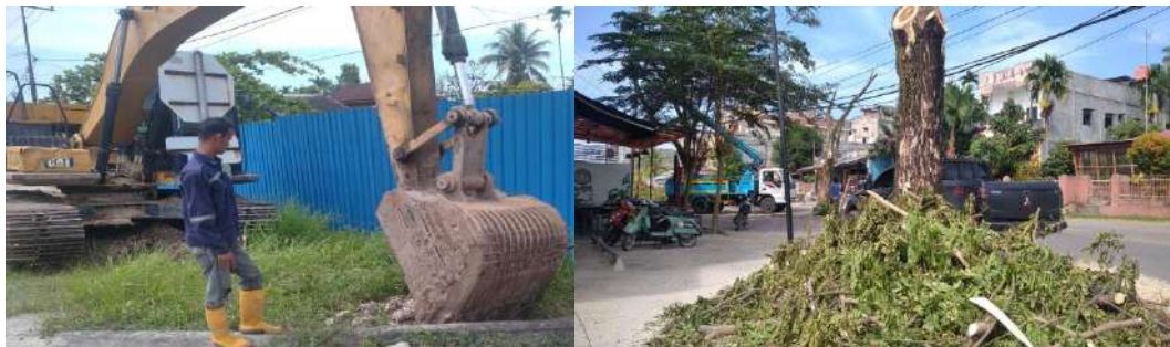
Gambar 3. 1 Pekerjaan Pembersihan Lahan
