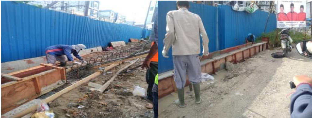
Gambar 3. 6 Pemasangan Bekisting dan Pengecoran Bagian atas DPT
