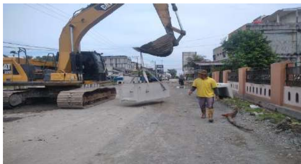
Gambar 3. 3 Pemasangan U-Ditch
