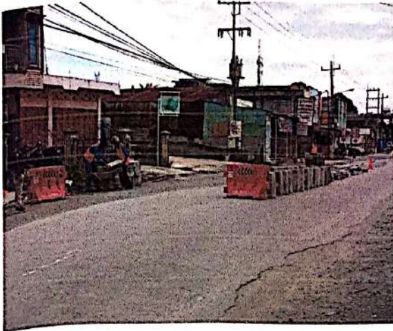
Pekerjaan persiapan pemasangan median jalan.
