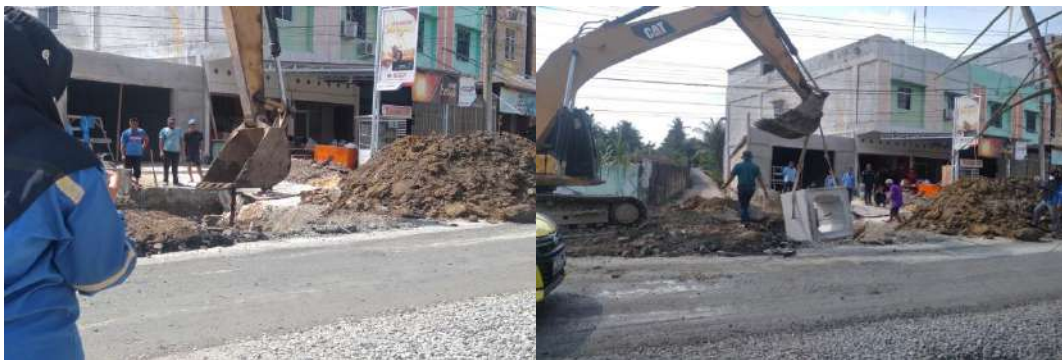
Gambar 3. 4 Pemasangan Box Culvert
