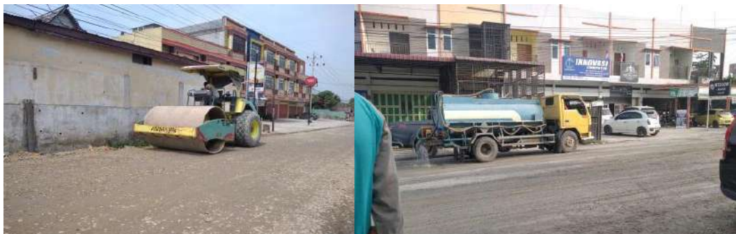
Gambar 2. 4 Pematatan dan Penyiraman Base A
