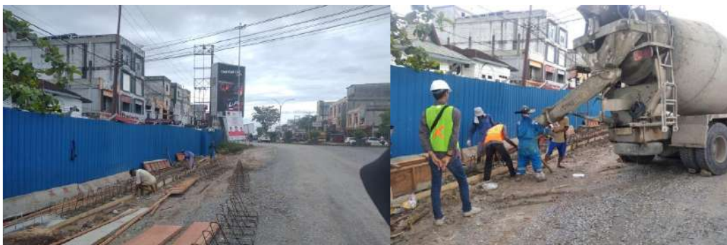
Gambar 3. 5 Pemasangan Bekisting dan Pengecoran Bagian Bawah DPT
