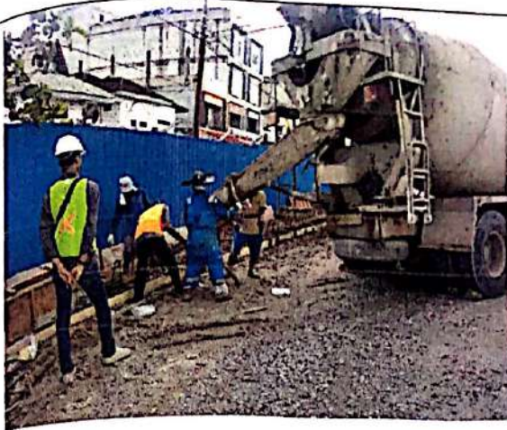
Pekerjaan pengecoran dinding penahan tanah dengan mutu beton K-250.
