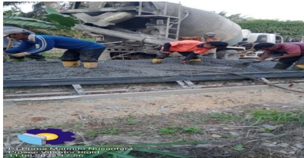
Gambar 3.19 Pekerjaan Concrete Vibro Pada Rigid
