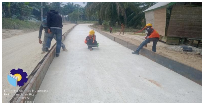
Gambar 3.13 Pekerjaan Proses Pengukuran
