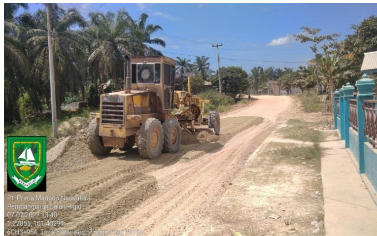
Gambar 4.3. Perataan Base B Menggunakan Alat Berat Motor Grader
