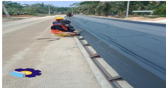
Gambar 3.14 Pekerjaan Pemasangan Plastik Alas
