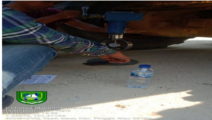
Gambar 4.9 Proses Pengujian CBR Lapangan
