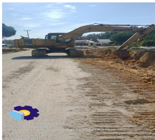
Gambar 3.3 Penggalian dan Penimbunan Bahu Jalan Menggunakan Alat Berat Excavator
