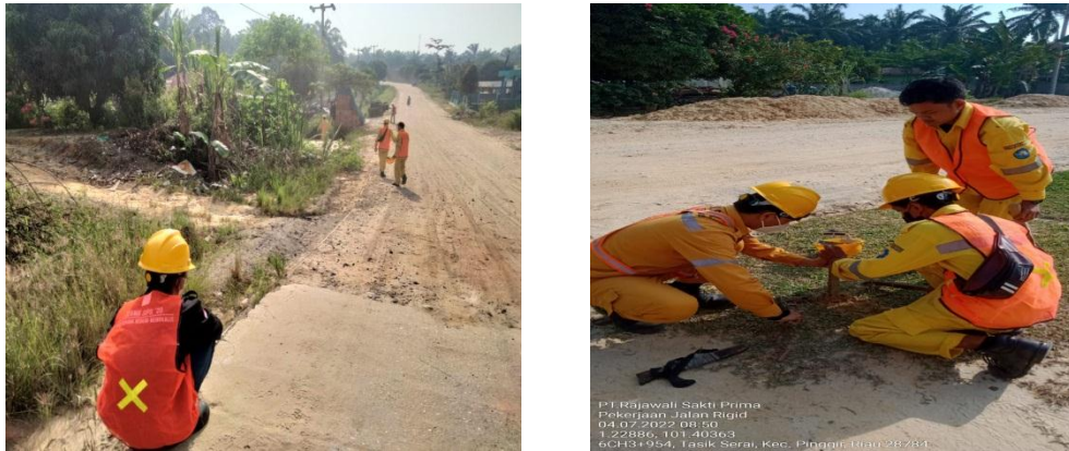
Gambar 3.1 Pengukuran dan pematokan pada bahu jalan
