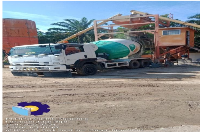
Gambar 3.16 Proses Produksi Rigid Di Batching Plant
