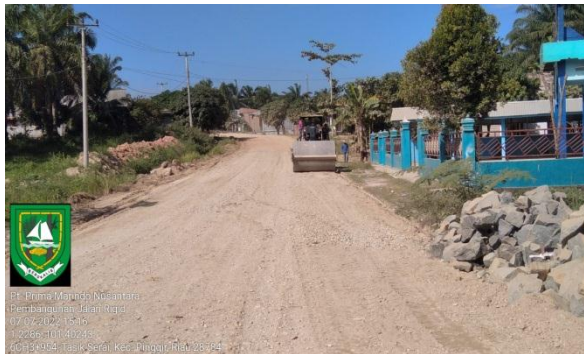
Gambar 3.6 Pemasangan Base Kelas B Menggunakan Vibrator Roller
