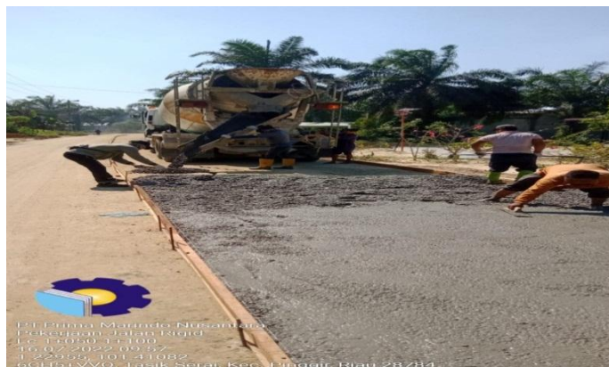
Gambar 3.12 Pelaksanaan Pengecoran Lc
