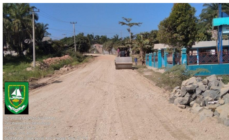
Gambar 4.8 Pematatan Base B
