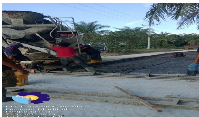
Gambar 3.17 Mobilisasi Rigid Ke Lokasi Pekerjaan
