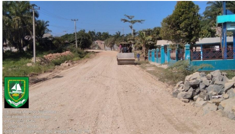
Gambar 4.4 Pemasangan Base B Menggunakan Alat Berat Vibrator Roller
