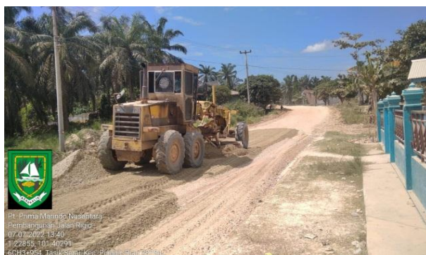
Gambar 3.5 Penghamparan Base Kelas B Menggunakan Motor Grader
