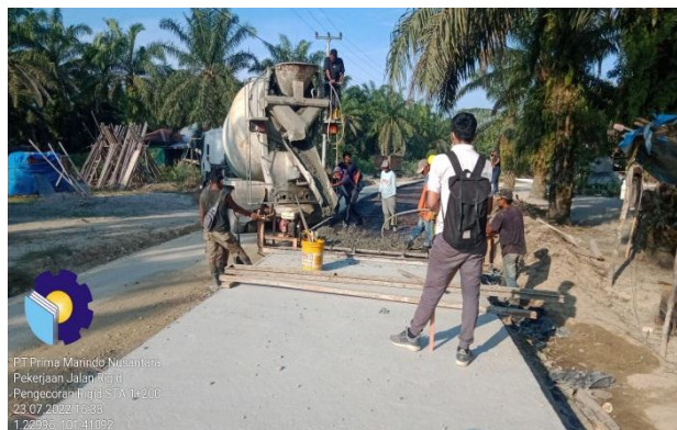
Gambar 3.18 Pekerjaan Rigid Di Lapangan
