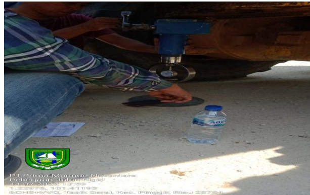
Gambar 3.7 Pengujian CBR lapangan
