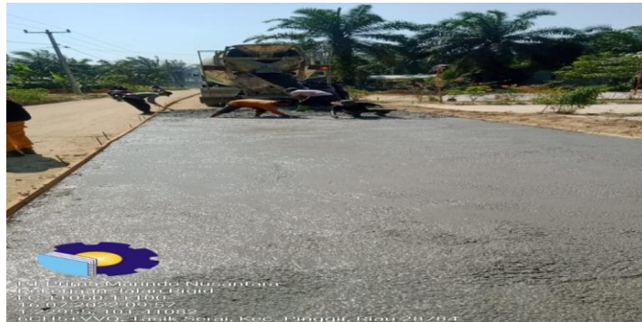
Gambar 3.11 Mobilisasi Lc Ke lokasi Pekerjaan
