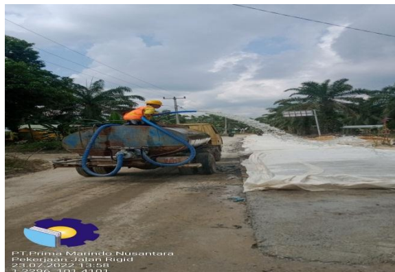
Gambar 3.21 Proses Curing Pada Rigid
