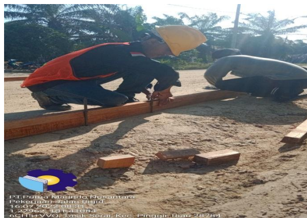
Gambar 3.9 Pekerjaan Persiapan Mall Lc
