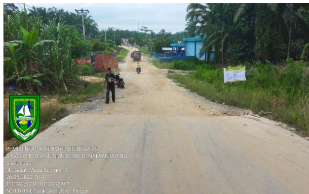
Gambar 1.1 Jalan Tasik Serai Sebelum Peningkatan
