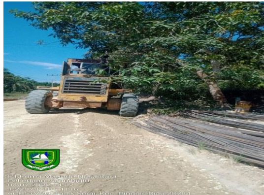
Gambar 3.2 Pelebaran Bahu Jalan Menggunakan Alat Motor Grader
