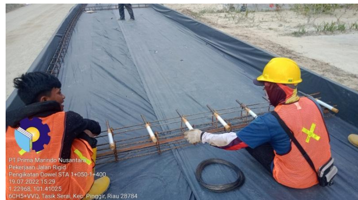
Gambar 3.15 Pekerjaan Pembesian/Tulangan Rigid
