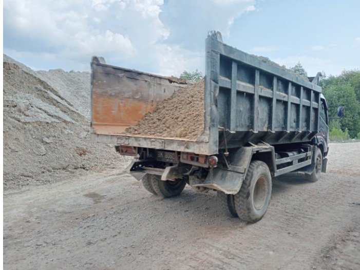
Gambar 3.10 Pengangkutan Timbunan Sumber : (Dokumentasi Lapangan, 2022)
