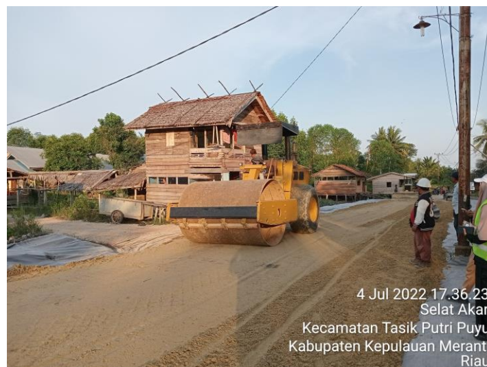
Gambar 3.12 Pemadatan Timbunan Menggunakan Vibro Roller Sumber : (Dokumentasi Lapangan, 2022)
