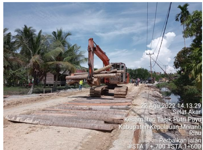
Gambar 3.5 Batang Kelapa Sebagai Gandingan Sumber : (Dokumentasi Lapangan, 2022)
