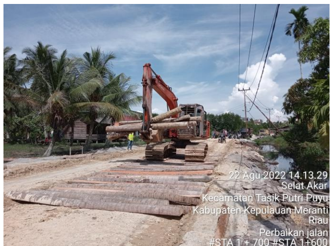
Gambar 3.15 Penambahan Gambangan Kelapa Sumber : (Dokumentasi Lapangan, 2022)
