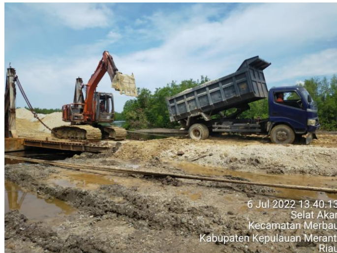
Gambar 3.4 pemindahan material dari ponton Sumber : (Dokumentasi Lapangan, 2022)
