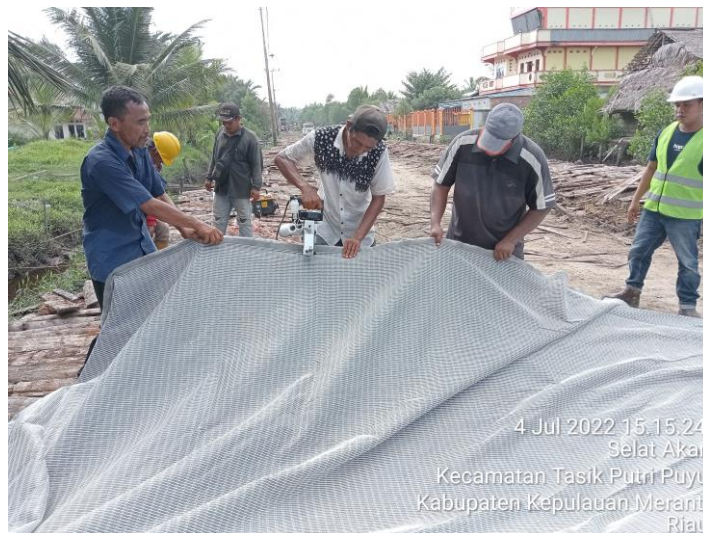
Gambar 3.9 Penjahitan Geotekstil di lapangan Sumber : (Dokumentasi Lapangan, 2022)
