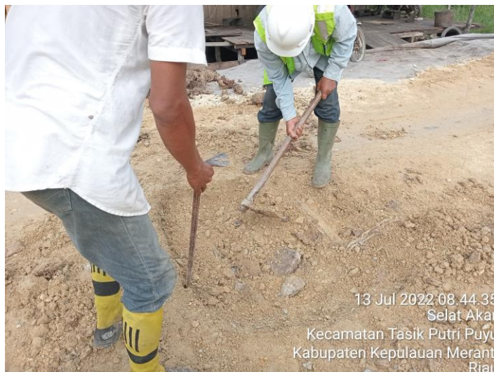
Gambar 3.13 Perbaiki Badan Jalan Sumber : (Dokumentasi Lapangan, 2022)
