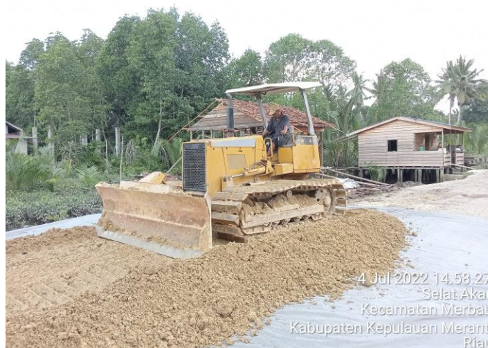
Gambar 3.11 Penghamparan Menggunakan Bulldozer Sumber : (Dokumentasi Lapangan, 2022)
