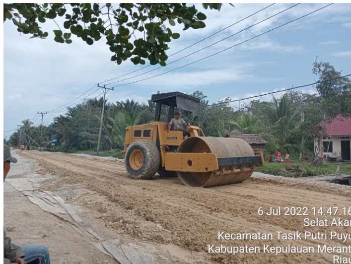
Gambar 3.7 Vibro Roller Sumber : (Dokumentasi Lapangan, 2022)
