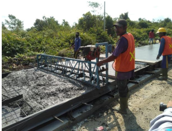
Gambar 4.11 Proses Pemerataan Permukaan Beton Rigid (Sumber: Dokumentasi dilapangan)
