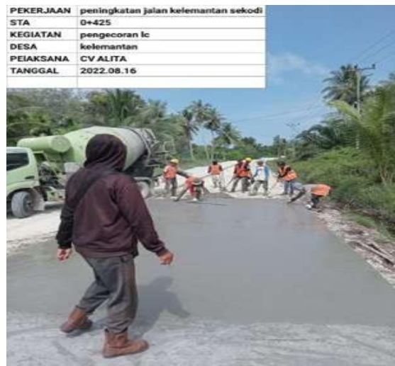
Gambar 4.13 Hasil Pengecoran Beton Rigid (Sumber: Dokumentasi dilapangan)
