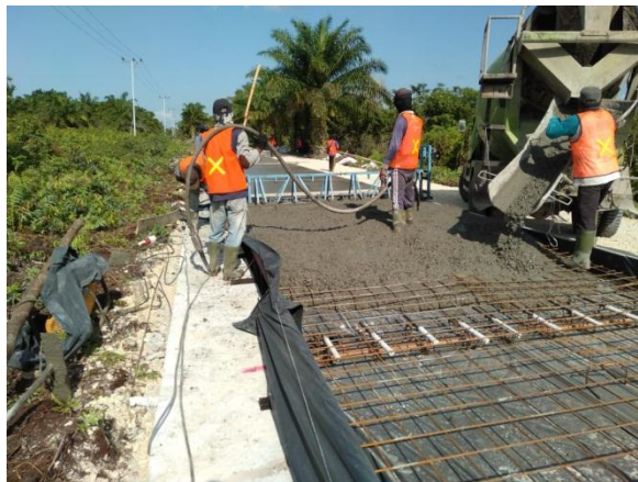
Gambar 4.10 Proses Pemadatan Beton (Sumber: Dokumentasi dilapangan)
