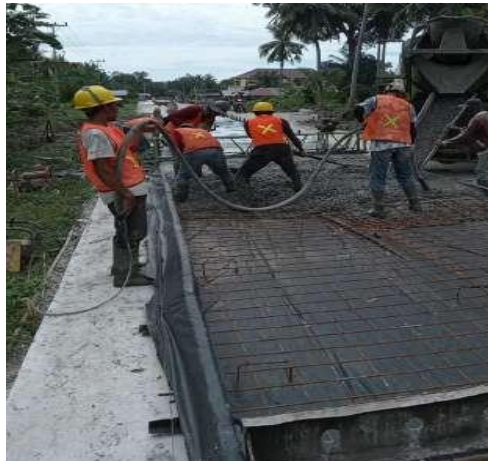
Gambar 4.5 Pengecoran Beton Rigid (Sumber: Dokumentasi dilapangan)
