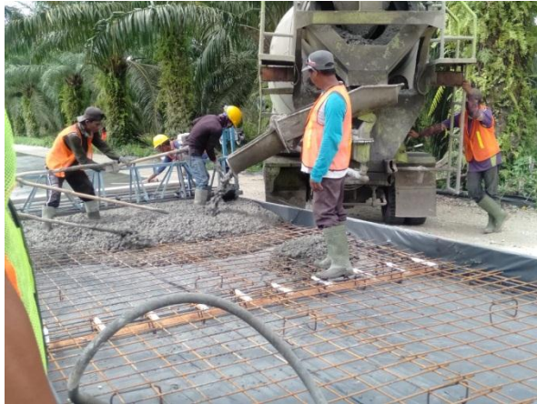
Gambar 4.9 Penuangan campuran beton (Sumber: Dokumentasi dilapangan)
