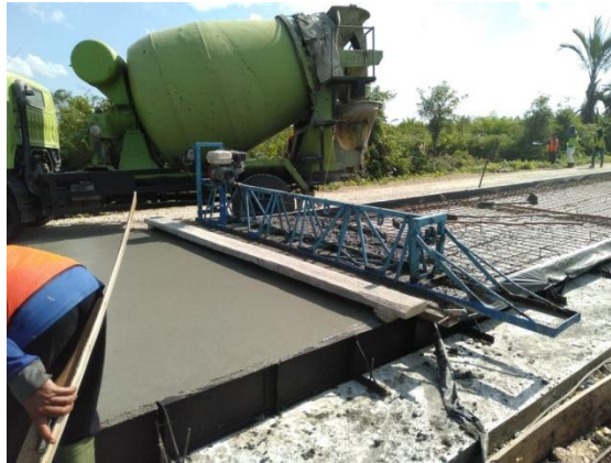
Gambar 4.6 Truck Mixer (Sumber: Dokumentasi lapangan)
