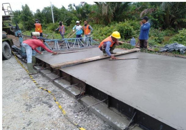
Gambar 4.12 Proses Finishing (Sumber: Dokumentasi dilapangan)
