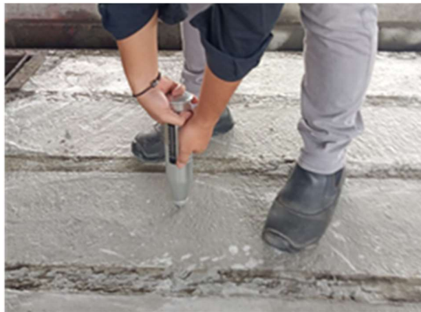
Gambar 3. 17 Pengujian Hammer Test Square Pile Sumber: Dokumentasi KP, 2022
