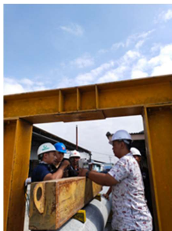
Gambar 3. 21 Pemasangan Bagian Tengah Bentang di LVDT Sumber: Dokumentasi KP, 2022
