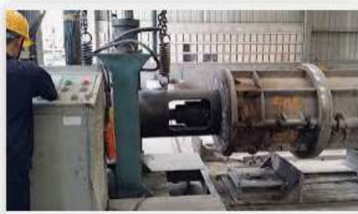
Gambar 3. 26 Mesin Stressing Sumber: Dokumentasi internet, tahun 2022
