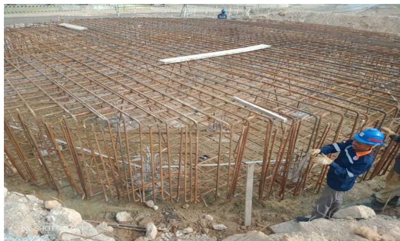
Gambar 3. 11 Pekerjaan Rebar (Pembesian)
