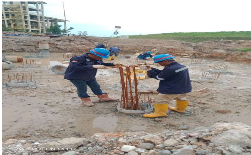
Gambar 3. 6 Pekerjaan Pemasangan Pht
