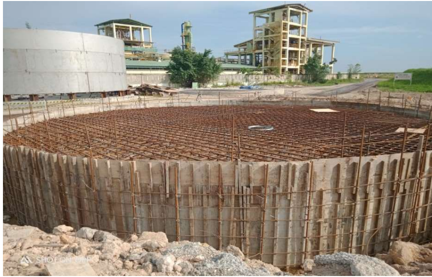
Gambar 3. 12 Pekerjaan Bekisting/Farm Box
