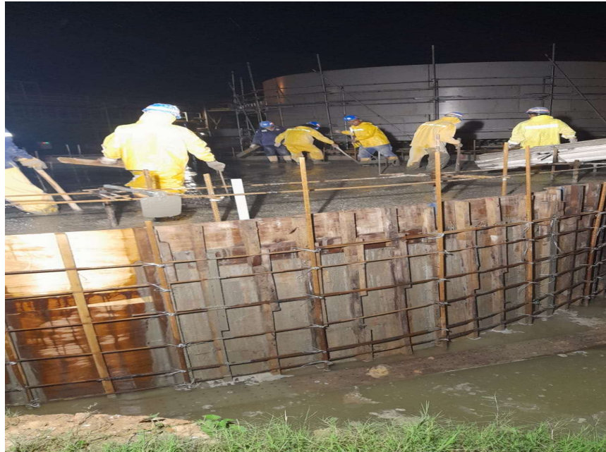
Gambar 3. 16 Pekerjaan Powring Concretec
