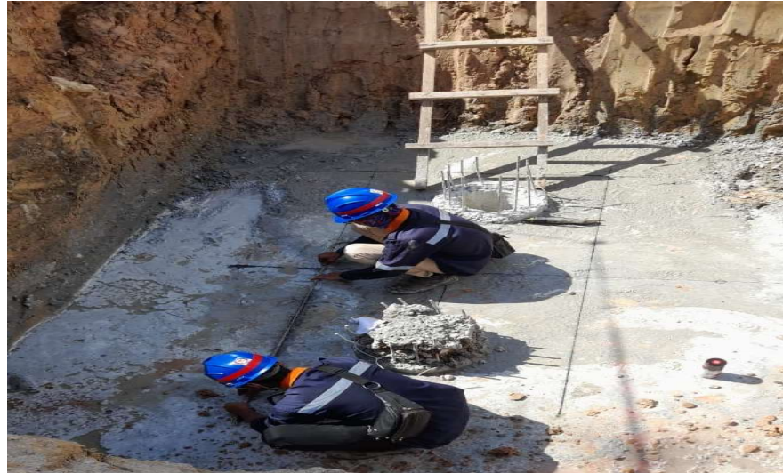
Gambar 3. 5 Pekerjaan Marking
