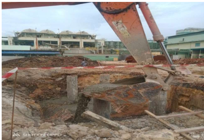
Gambar 3. 3 Proses perkerjaan Lean Concrete (K100)
