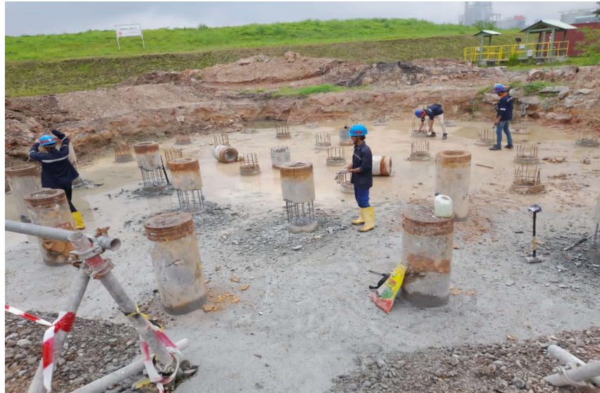
Gambar 3. 4 Pekerjaan Pembobok Pile
