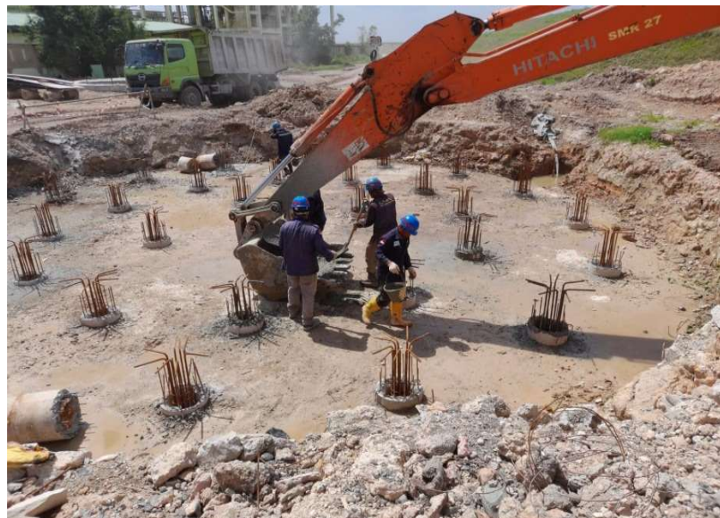
Gambar 3. 7 Pekerjaan Cor Pht
