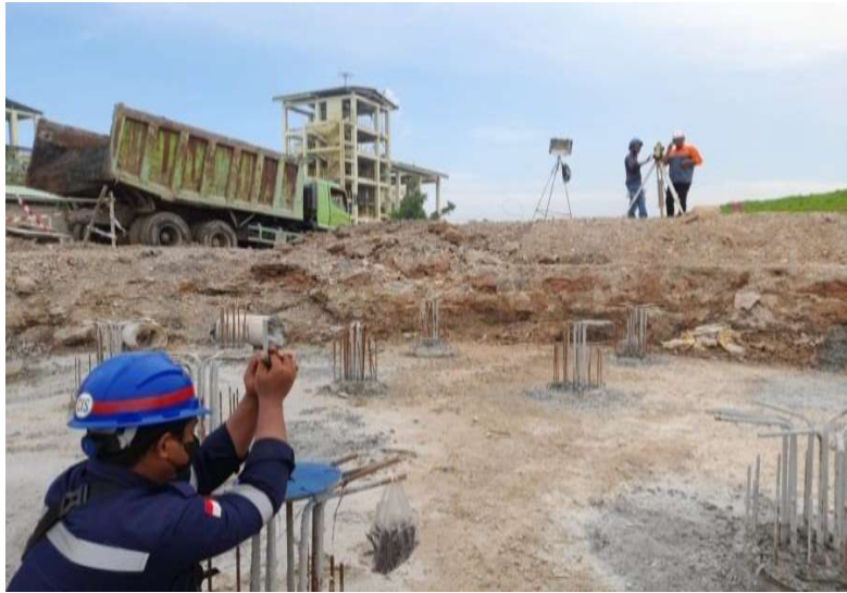
Gambar 3. 8 Pekerjaan Pengambilan Center Line
