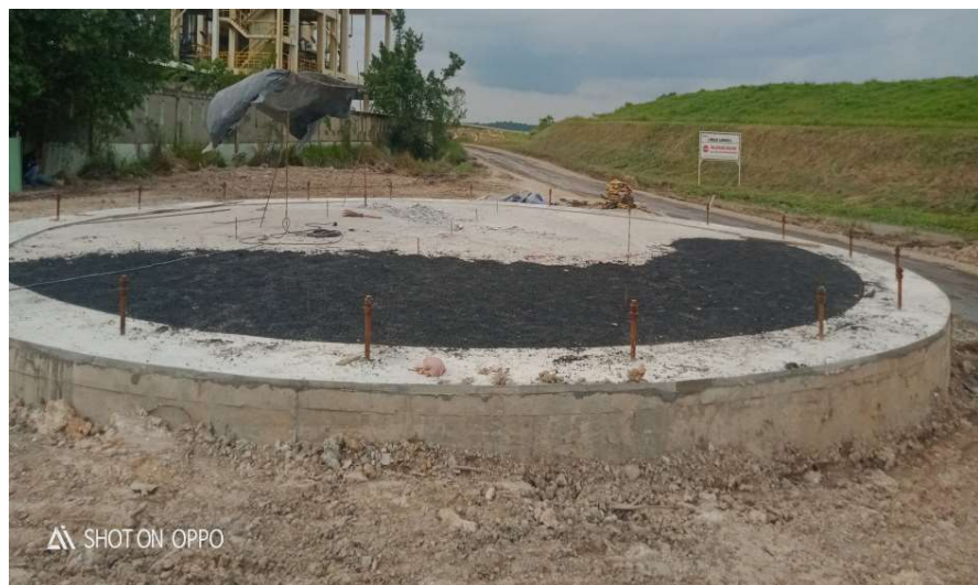
Gambar 3. 18 Pekerjaan Aspal/Grouting
