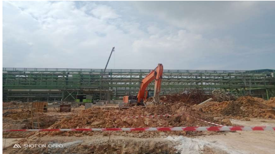
Gambar 3. 17 Pekerjaan Pengurugan Tanah
