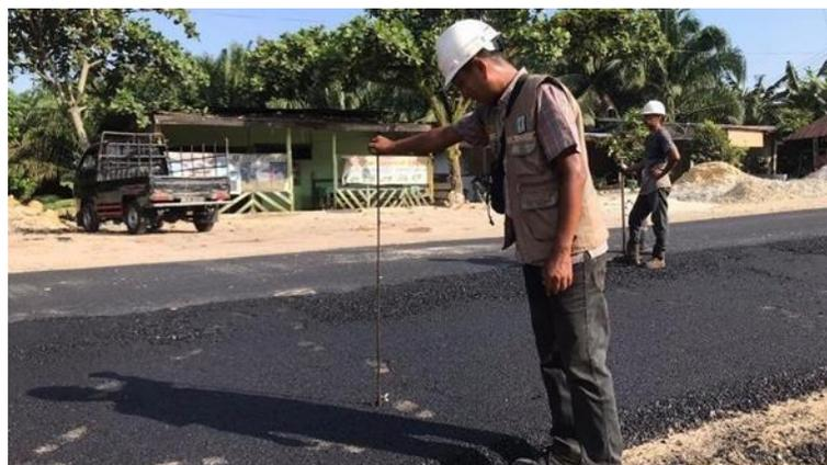
**Gambar 4. 22 Pengukuran Ketebalan AC-WC**
