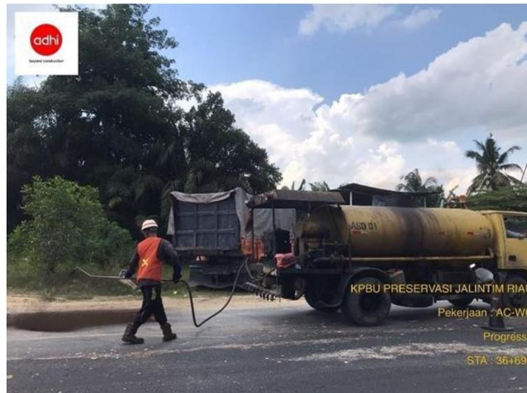
**Gambar 4. 4 Pekerjaan Penyemprotan Lapisan Perekat (Tackout)**
