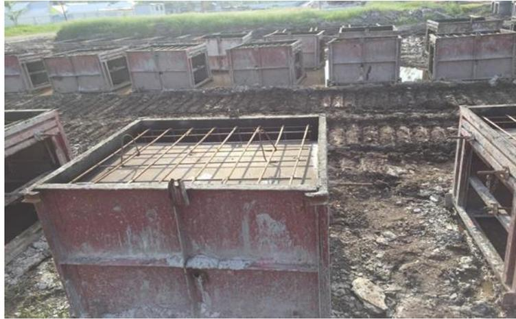
**Gambar 3. 13 Pekerjaann Pengecoran U-ditch**
