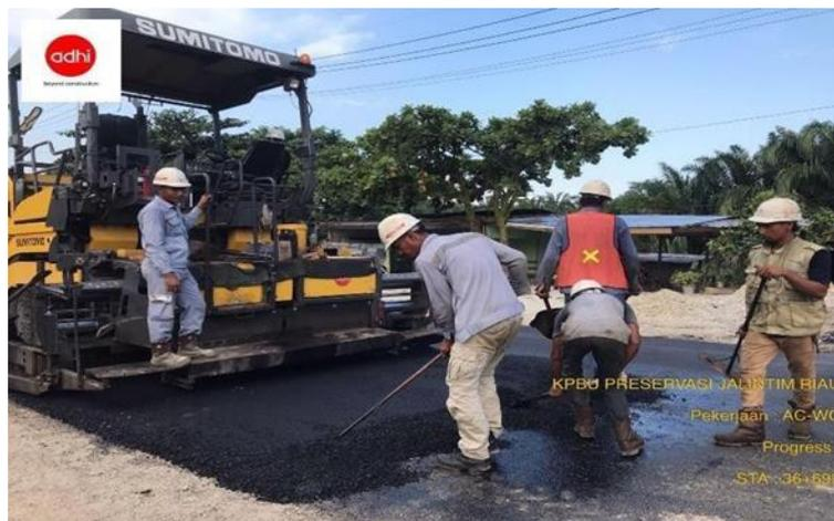
**Gambar 4. 20 Pekerjaan Overlay**
