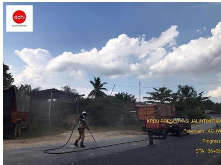
**Gambar 4. 3 Pembersihan Permukaan Jalan Menggunakan Compressor**
