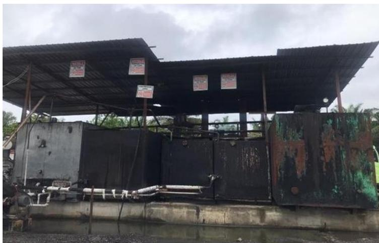
**Gambar 4. 7 Pemanasan Aspal Minyak Untuk Campuran Hotmix**
