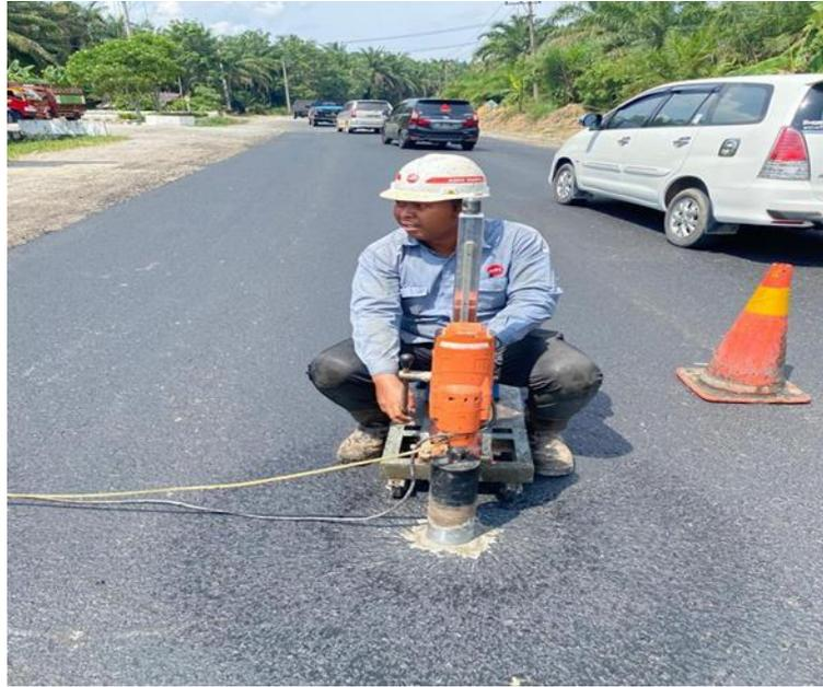
**Gambar 3. 17 Pengujian Coredrill**
