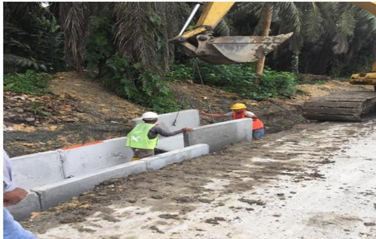
**Gambar 3. 14 Pekerjaan Pemasangan U-ditch**
