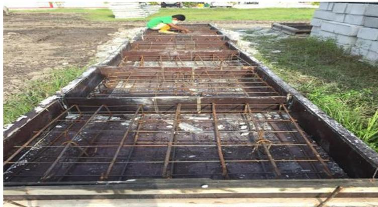
**Gambar 3. 12 Pekerjaan Pembesian U-ditch**
