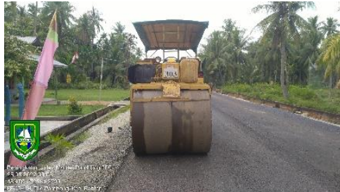
Gambar 1. 9 Tandem Roller (Sumber): Dokumentasi lapangan, 2022
