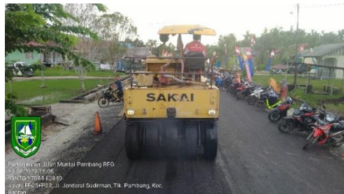
Gambar 1. 32 Pekerjaan Pemadatan Akhir Aspal AC-BC (Sumber) : Dokumentasi lapangan, 2022
