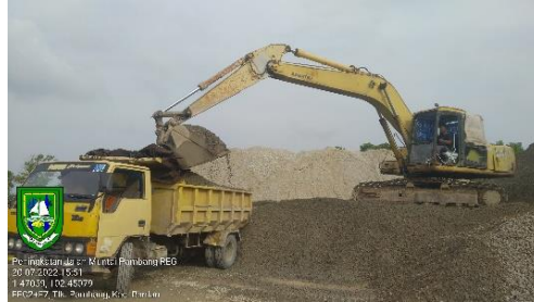
Gambar 1. 21 Lapis Pondasi Agregat Kelas A (Sumber): Dokumentasi lapangan, 2022
