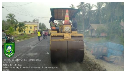
Gambar 1. 31 Pekerjaan Pemadatan Awal Aspal AC-BC (Sumber) : Dokumentasi lapangan, 2022
