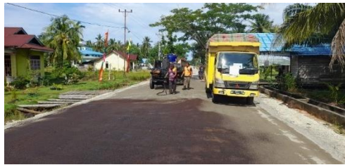
Gambar 1. 33 Pekerjaan Pemadatan Akhir Aspal AC-BC (Sumber) : Dokumentasi lapangan, 2022
