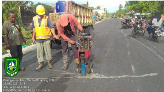
Gambar 1. 37 Pekerjaan Core Drill Aspal AC-WC (Sumber): Dokumentasi lapangan,2022
