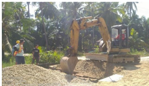
Gambar 1. 25. Pekerjaan Duiker (Sumber) : Dokumentasi lapangan, 2022
