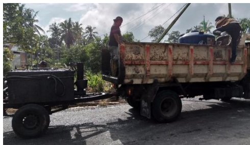
Gambar 1. 29 Pekerjaan Prime Coat (Sumber) : Dokumentasi lapangan, 2022
