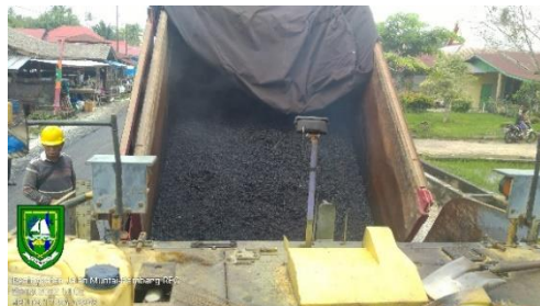
Gambar 1. 23 Asphalt (Sumber): Dokumentasi lapangan, 2022
