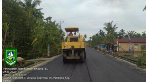
Gambar 1. 36 Pekerjaan Pemasangan Akhir Aspal AC-WC PTR (Sumber): Dokumentasi lapangan, 2022
