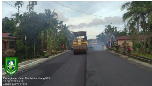
Gambar 1. 35 Pekerjaan Pemadatan Awal AC-WC Tandem Roller (Sumber) : Dokumentasi lapangan,2022
