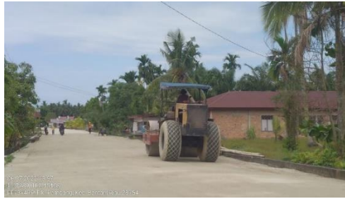
Gambar 1. 24 Pekerjaan Agregat Kelas B (Sumber) : Dokumentasi lapangan, 2022
