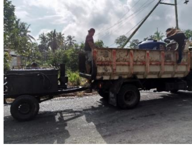
Gambar 1. 22 Prime Coat (Sumber): Dokumentasi lapangan, 2022
