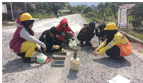
Gambar 1. 28 Pengujian Sand Cone Base A(Density) (Sumber) : Dokumentasi lapangan, 2022
