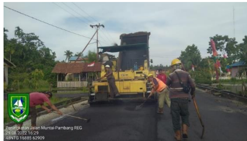
Gambar 1. 34 Pekerjaan Penghamparan Aspal AC-BC (Sumber) : Dokumentasi lapangan, 2022
