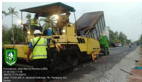
Gambar 1. 30 Pekerjaan Penghamparan Aspal AC-BC (Sumber) : Dokumentasi lapangan, 2022
