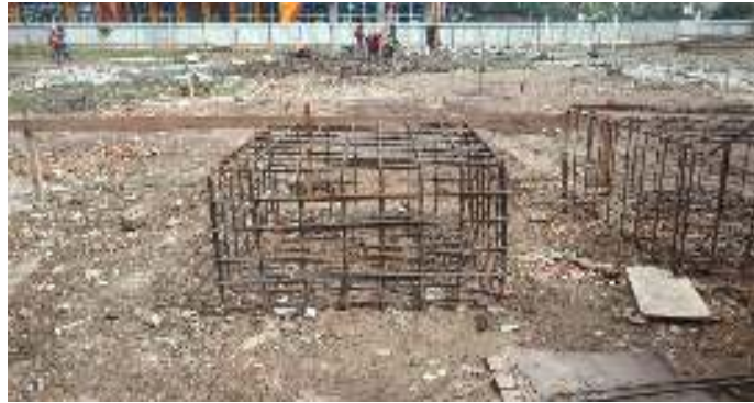
Gambar 3.5 Tulangan pile cap dilapangan (Sumber : Dokumentasi Proyek, 2020)
