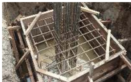
b) . Bekisting PileCap
