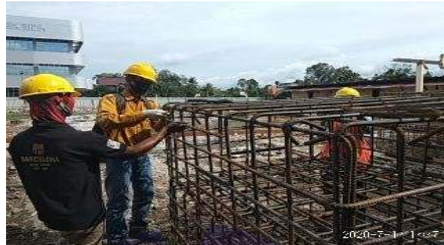
Gambar 3.7 Tulangan pile cap dilapangan (Sumber : Dokumentasi Proyek, 2020)
