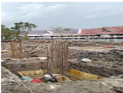
a) . Bekisting PileCap
