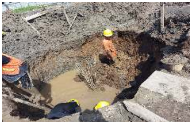
Gambar 3.6 Tulangan pile cap dilapangan (Sumber : Dokumentasi Proyek, 2020)
