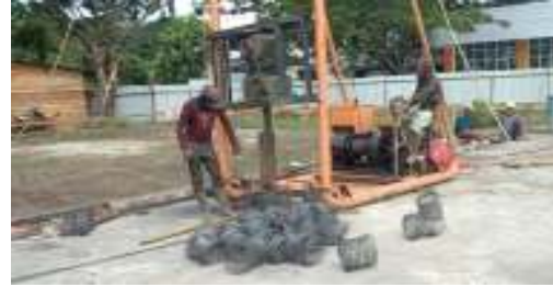
b ). Perakitan tulangan spiral
