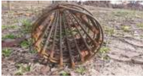
a). Perakitan tulangan Bore Pile
