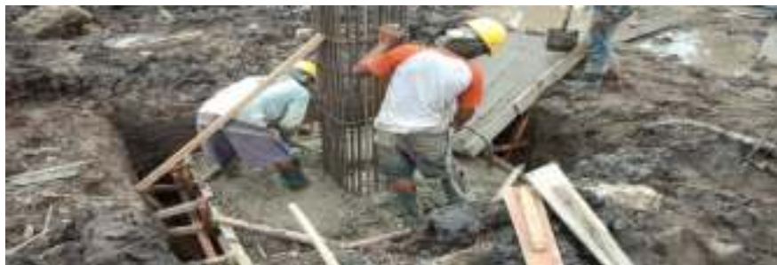
b) Pengecoran Pile cap
