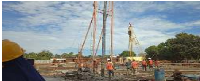
c). Perakitan tulangan Bore Pile
