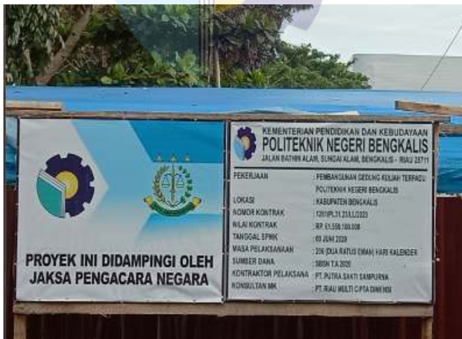
Gambar 2.2 Papan nama proyek pembangunan gedung kuliah terpadu polbeng (sumber : lapangan proyek)
