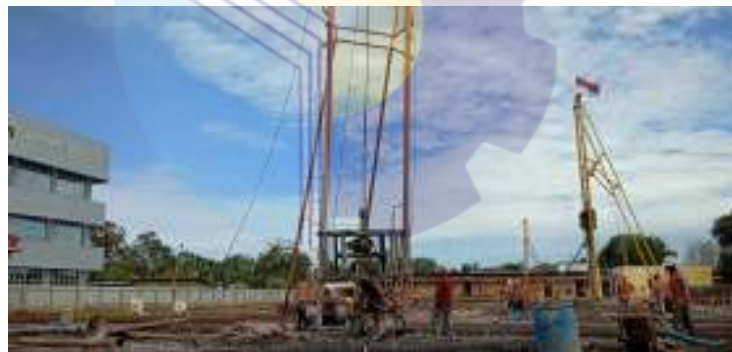
Gambar 3.2 Pengeboran Pondasi Bore Pile (Sumber : Dokumentasi Proyek, 2020)
