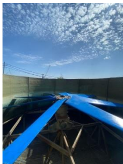
Gambar 4. 9 Pemasangan fan baru
