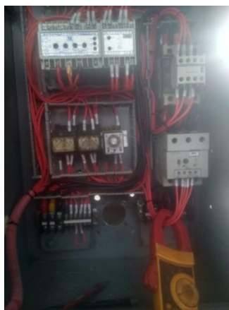
Gambar 1.6 Proses Pengetesan Panel (Sumber: Dokumentasi PT. Bukaka Teknik Utama Duri, 2022)
