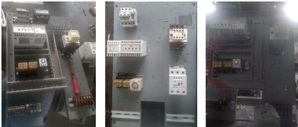
Gambar 1.4 Proses Repair Panel (Sumber: Dokumentasi PT. Bukaka Teknik Utama Duri, 2022)
