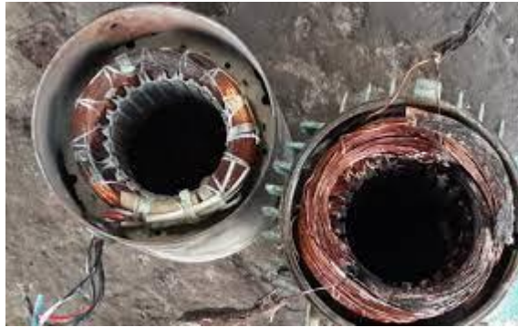
Gambar 1.16 Kerusakan Bearing Akibat Overload (Sumber: Dokumentasi PT. Bukaka Teknik Utama Duri, 2022)
