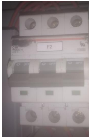
Gambar 1.7 MCB 3 fasa (Sumber: Dokumentasi PT. Bukaka Teknik Utama Duri, 2022)
