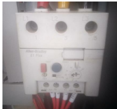
Gambar 1.19 komponen Thermal Overload Relay (Sumber: dokumentasi PT. Bukaka Teknik Utama Duri, 2022)
