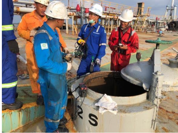
Gambar 2.36 Pengecekan tanki bersama pekerja PT. MOS
