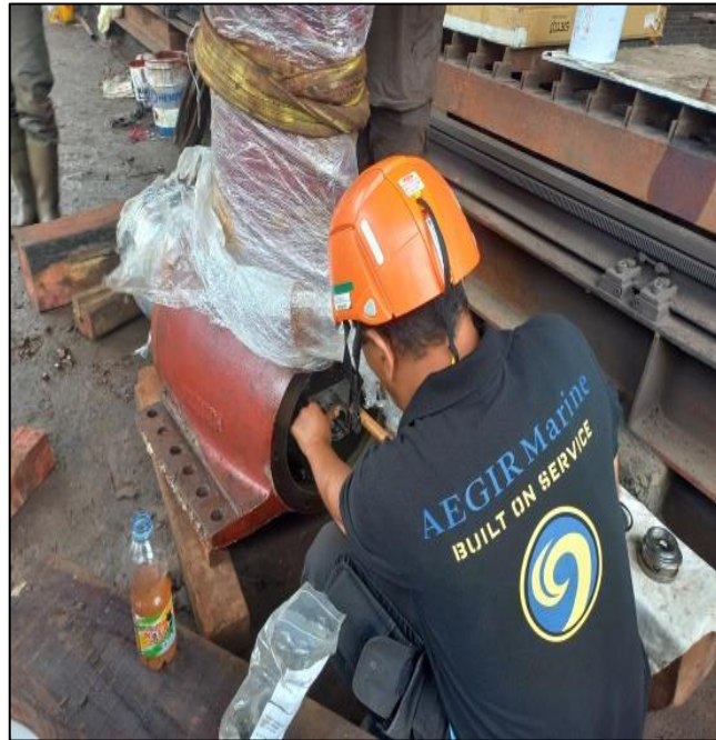
Gambar 2.131 Proses Pemasangan Oil distributor Sumber : Dokumentasi penulis
