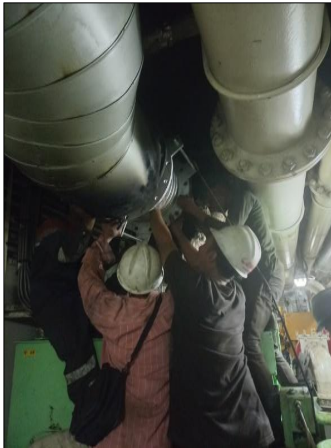
Gambar 2.137 Proses pemasangan Spiral cerobong asap Sumber : Dokumentasi penulis
