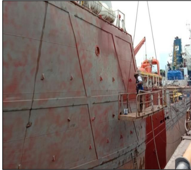
Gambar 2.20 Proses pengecatan AC pada lambung kapal Peteka 5402 Sumber : Dokumentasi penulis
