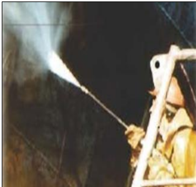
Gambar 3.2 Proses water jet Sumber : Dokumentasi penulis
