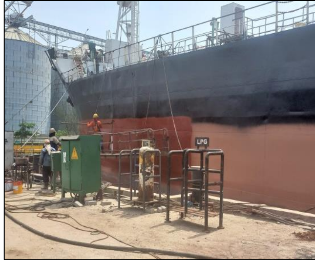
Gambar 2.55 Proses pengecatan Anti Fouling Sumber : Dokumentasi penulis
