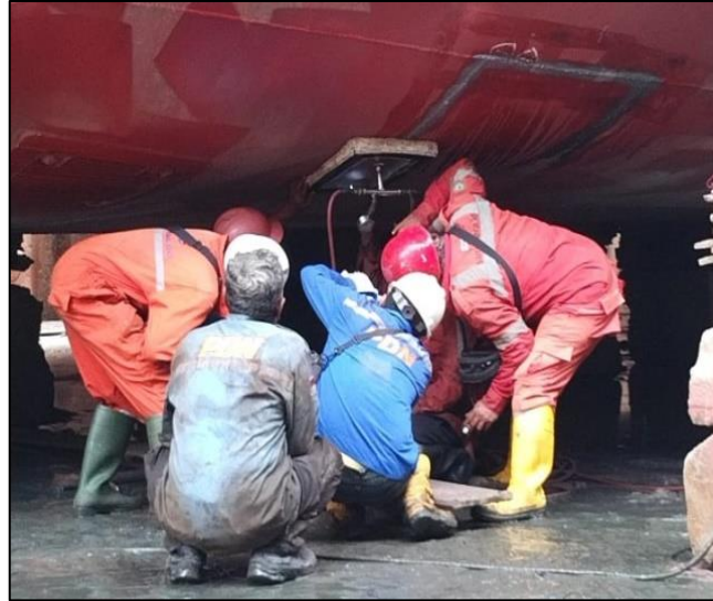
Gambar 2.44 Proses pengujian Vacum Test Sumber : Dokumentasi penulis
