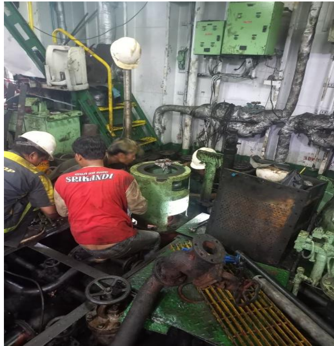
Gambar 2.99 Perbaikan pompa air Ballast Sumber : Dokumentasi penulis
