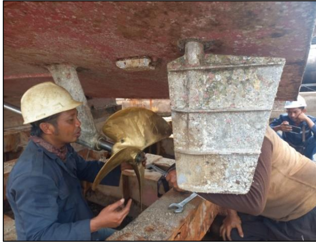
Gambar 2.71 Proses pemasangan shaft dan propeller
