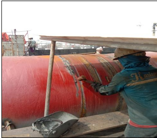
Gambar 2.28 Proses repair Stern Roller kapal Peteka 5402 Sumber : Dokumentasi penulis
