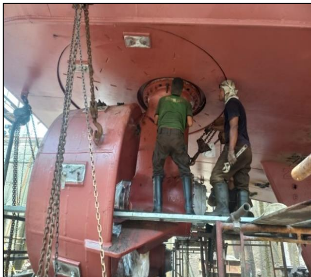
Gambar 2.113 Proses pemasangan Z- Peller Sumber : Dokumentasi penulis
