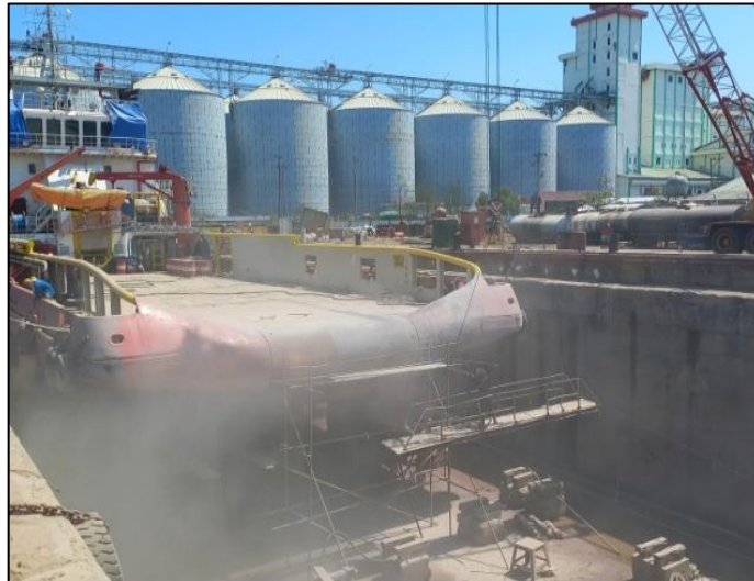
Gambar 3.13 Proses sandblasting Sumber : Dokumentasi penulis
