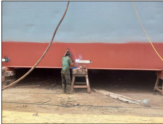
Gambar 2.89 Proses pemasangan Zinc anode Sumber : Dokumentasi penulis
