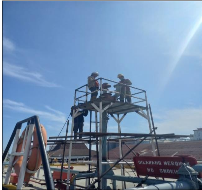
Gambar 2.94 Proses pemasangan valve Sumber : Dokumentasi penulis
