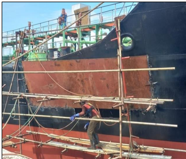
Gambar 2.74 Proses replating kapal MT.Kurau Sumber : Dokumentasi penulis
