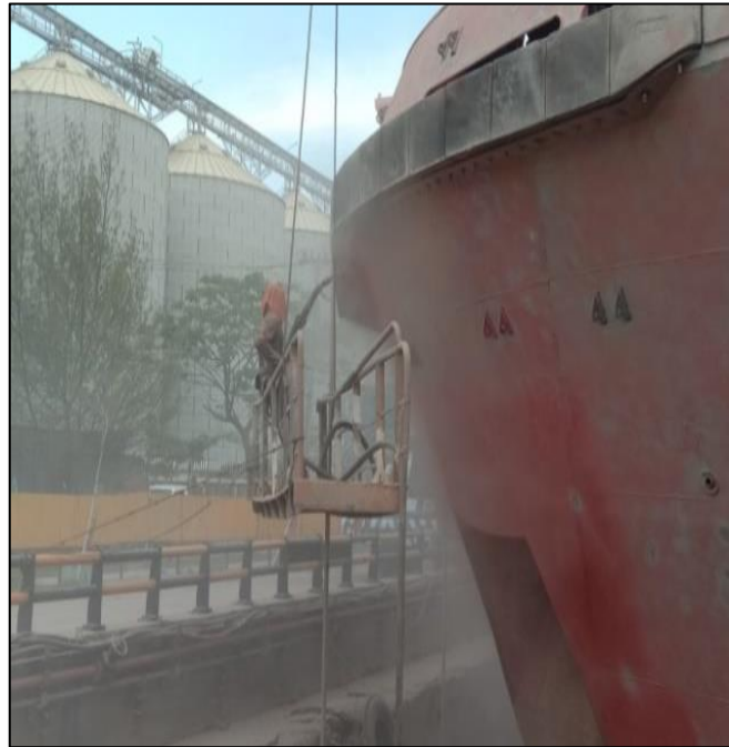
Gambar 2.13 Proses Sand Blasting pada lambung kapal Peteka 5402 Sumber : Dokumentasi penulis
