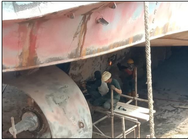
Gambar 2.16 Proses pelepasan Zinc Anode Sumber : Dokumentasi penulis
