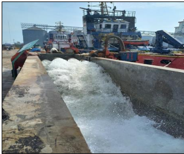
Gambar 2.10 Proses pembuangan /pengeringan air dari Graving Dock Sumber : Dokumentasi penulis
