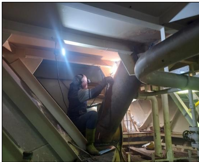
Gambar 2.90 Proses pengelasan pipa Urlup ( Hawse pipe) Sumber : Dokumentasi penulis
