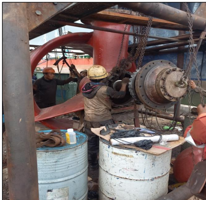
Gambar 2.38 Proses pemasangan shaft propeller Sumber : Dokumentasi penulis
