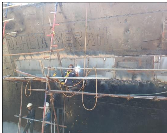
Gambar 2.146 Proses Replating Sumber : Dokumentasi penulis
