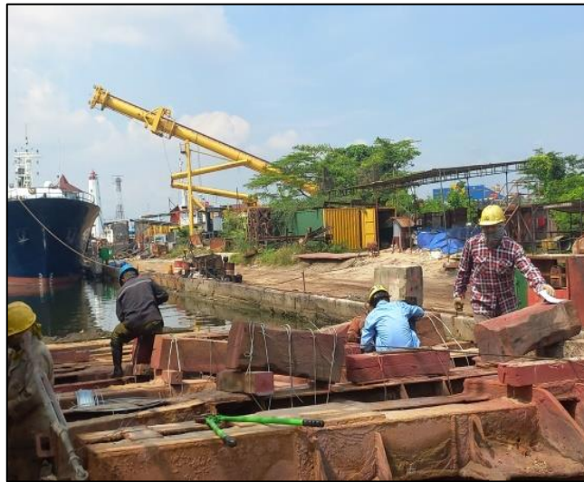
Gambar 2.64 Proses penyusunan keel block Sumber : Dokumentasi penulis
