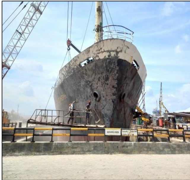
Gambar 2.142 Proses sanblasting Sumber : Dokumentasi penulis
