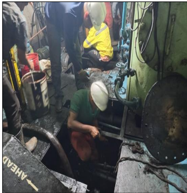
Gambar 2.141 Proses cleaning tangki pelumas Sumber : Dokumentasi penulis
