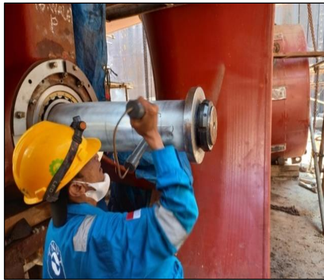
Gambar 2.109 Proses pengujian NDT Sumber : Dokumentasi penulis
