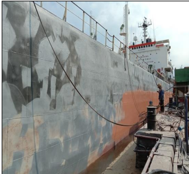
Gambar 2.53 Proses pengecatan Intermediate (Sealer) Sumber : Dokumentasi penulis
