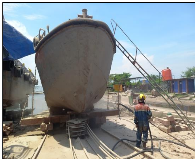
Gambar 2.67 Proses sand blasting lambung kapal Sumber : Dokumentasi penulis
