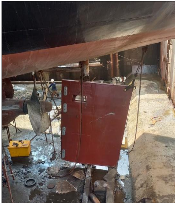
Gambar 2.66 Proses pemasangan daun kemudi. Sumber : Dokumentasi penulis
