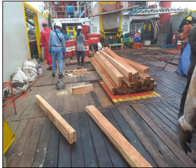
Gambar 2.139 Proses Pemasangan papan deck kapal Sumber : Dokumentasi penulis
