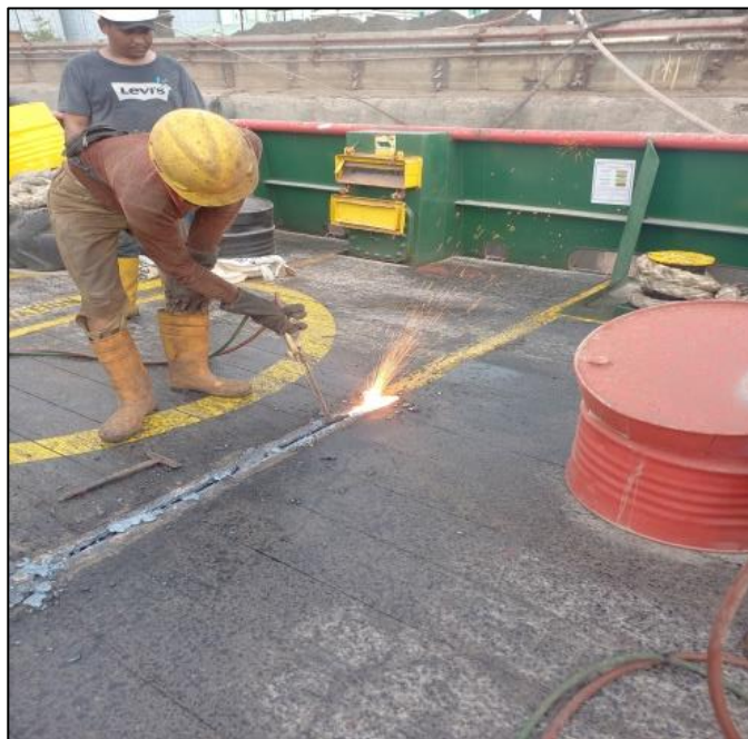
Gambar 2.101 Proses pemotongan Angle bar Sumber : Dokumentasi penulis
