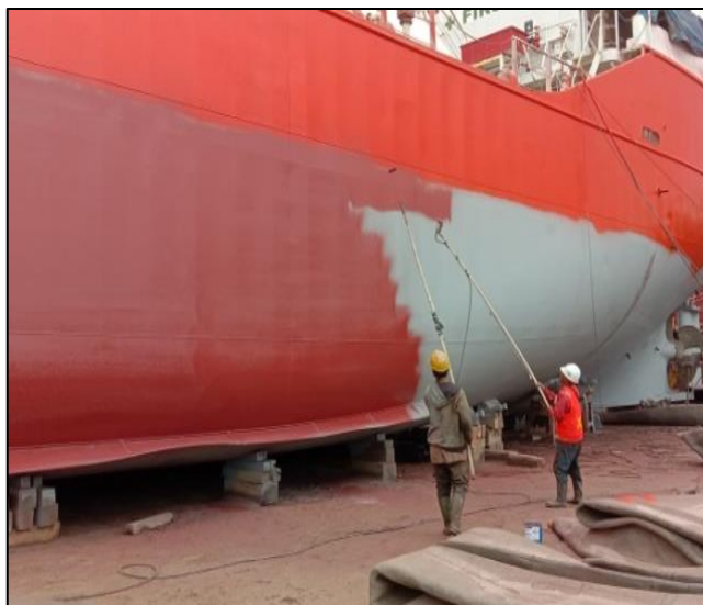
Gambar 2.59 Proses pengecatan Anti Fouling Sumber : Dokumentasi penulis
