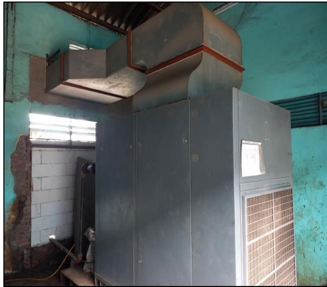
Gambar 3.3 Kompresor sentral Sumber : Dokumentasi penulis
