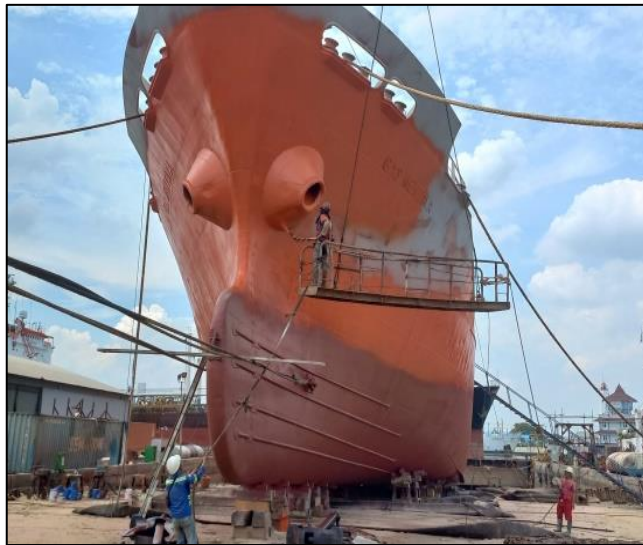
Gambar 2.60 Proses pengecatan finishing pada bagian top side Sumber : Dokumentasi penulis
