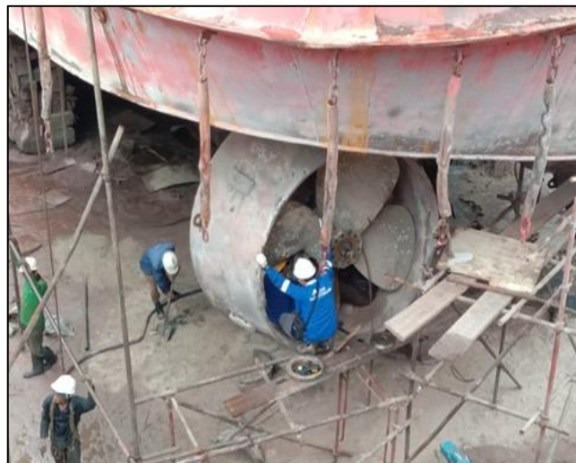
Gambar 2.15 Proses penurunan atau pelepasan propeller kapal Sumber : Dokumentasi penulis
