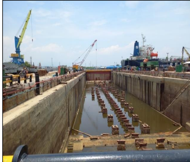
Gambar 2.8 Proses penyusunan keel block
