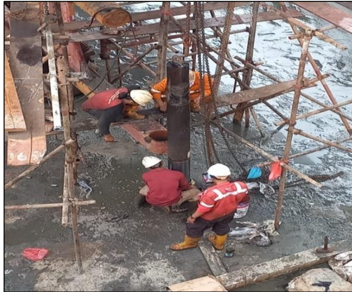
Gambar 2.42 Proses persiapan pemasangan rudder stock Sumber : Dokumentasi penulis
