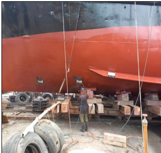
Gambar 2.133 Proses Pemasangan Zink Anode Sumber : Dokumentasi penulis
