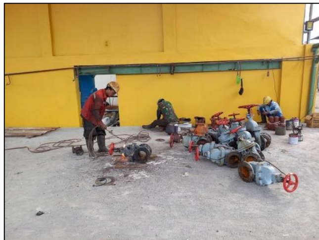
Gambar 2.87 Proses perbaikan valve Sumber : Dokumentasi penulis
