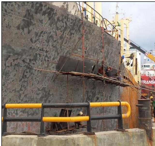
Gambar 2.143 Proses fit up plat Sumber : Dokumentasi penulis
