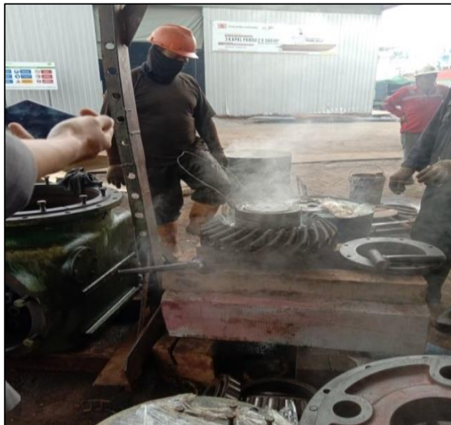
Gambar 2.31 Proses pemasangan bearing upgear Sumber : Dokumentasi penulis
