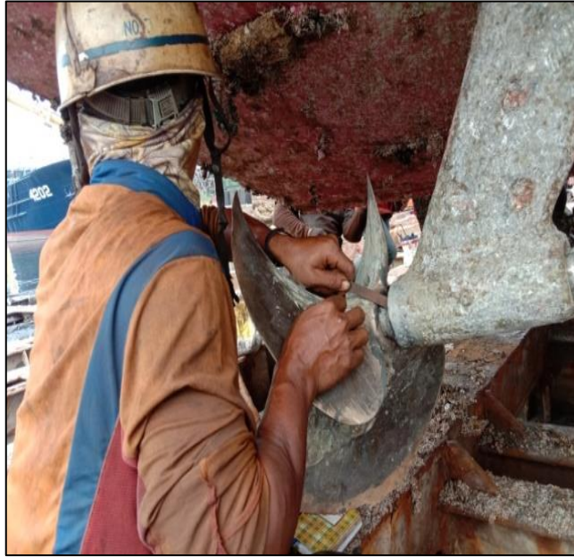
Gambar 2.52 Proses pengukuran clearance pada bearing shaft propeller Sumber : Dokumentasi penulis
