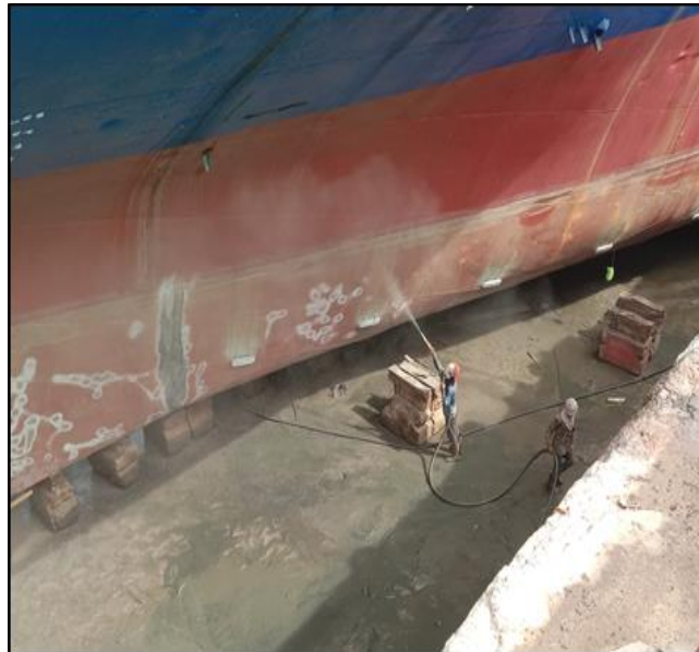
Gambar 2.43 Proses Sand Blasting parsial Sumber : Dokumentasi penulis
