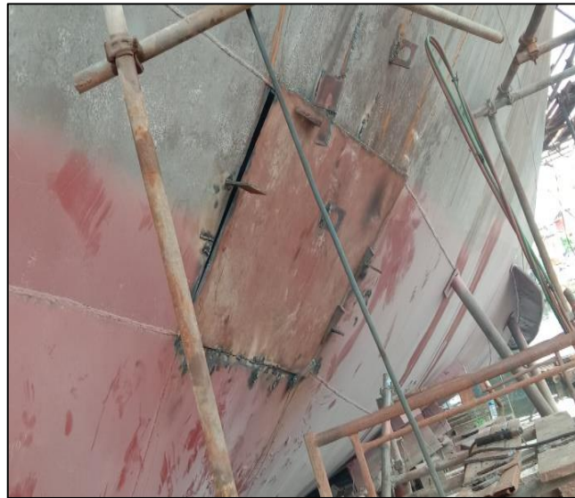
Gambar 2.34 Proses replating pada kapal TB. Balongan 1 Sumber : Dokumentasi penulis
