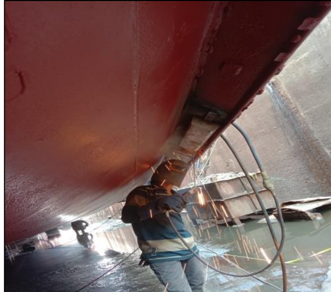
Gambar 2.26 Proses pemasangan Zinc Anode Sumber : Dokumentasi penulis
