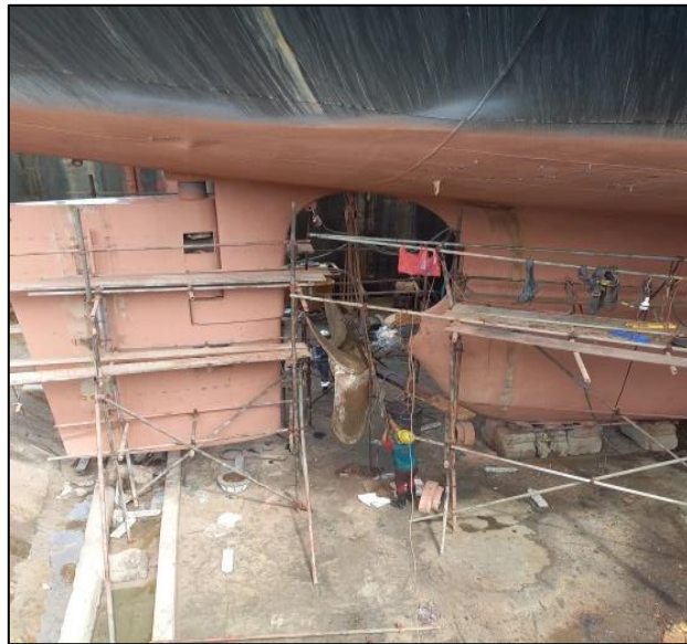
Gambar 2.75 Proses pemasangan propeller
