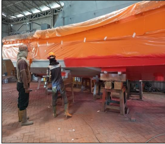
Gambar 2.135 Proses pengecatan lambung kapal Sumber : Dokumentasi penulis
