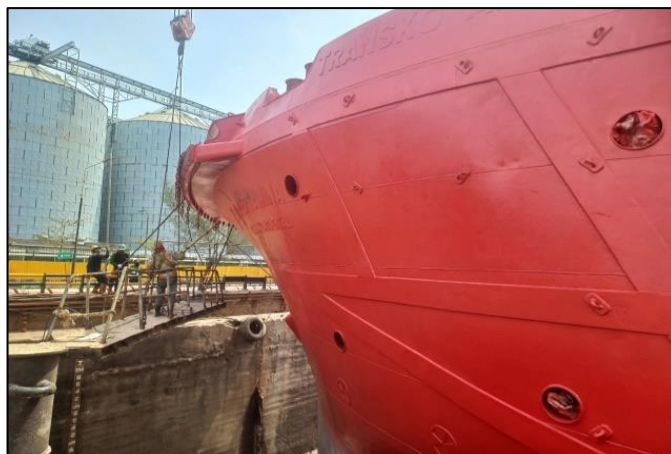
Gambar 3.22 Proses pengecatan Anti Fouling Sumber : Dokumentasi penulis
