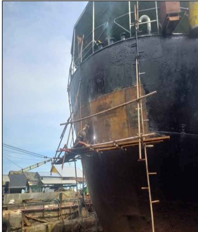
Gambar 2.147 Proses Replating Sumber : Dokumentasi penulis
