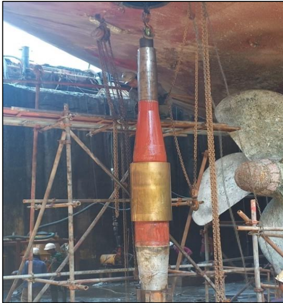
Gambar 2.65 Proses pemasangan poros kemudi(rudder stock). Sumber : Dokumentasi penulis
