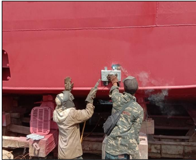
Gambar 2.58 Proses pemasangan Zinc Anode Sumber : Dokumentasi penulis
