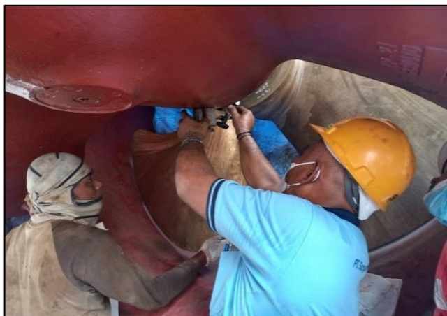
Gambar 2.116 Proses pengecekan Sentring Leaner Sumber : Dokumentasi penulis
