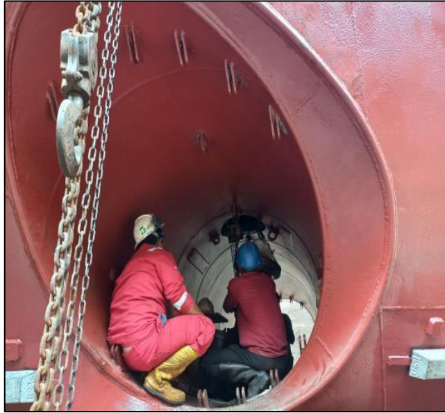
Gambar 2.132 Proses Pemasangan Bow Thruster Sumber : Dokumentasi penulis
