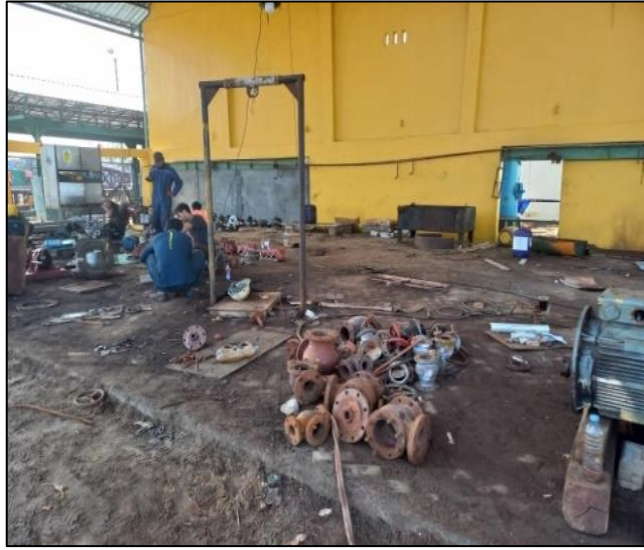
Gambar 2.118 Proses perbaikan valve Sumber : Dokumentasi penulis
