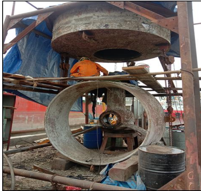
Gambar 2.24 Proses proses pembersihan Azimuth (rumah propeller) Sumber : Dokumentasi penulis
