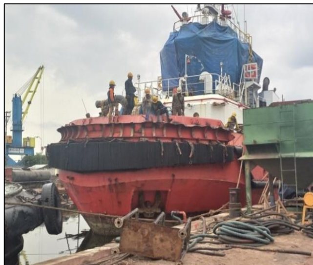
Gambar 2.95 Proses pelepasan Rubber feeder Sumber : Dokumentasi penulis
