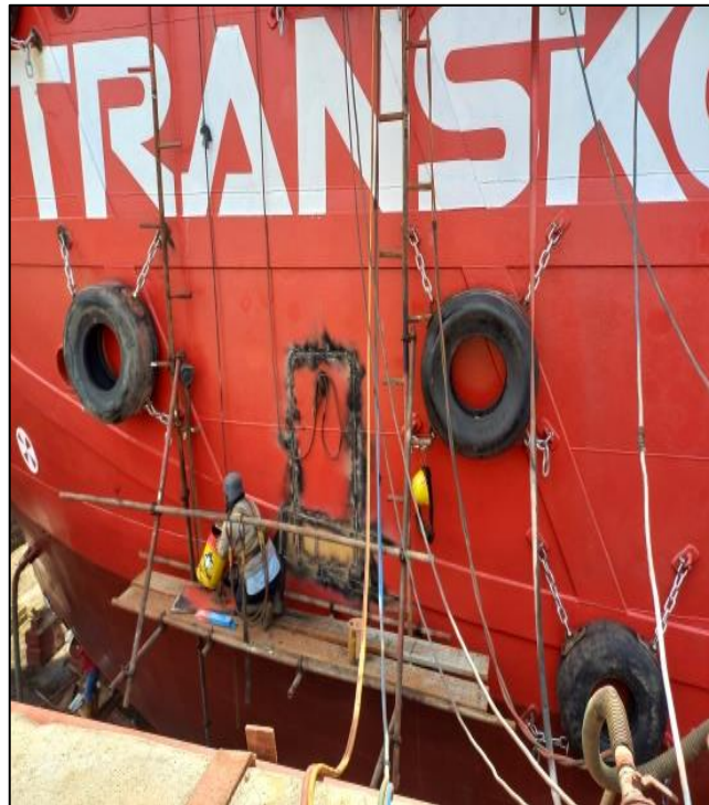
Gambar 2.134 Proses Replating Sumber : Dokumentasi penulis
