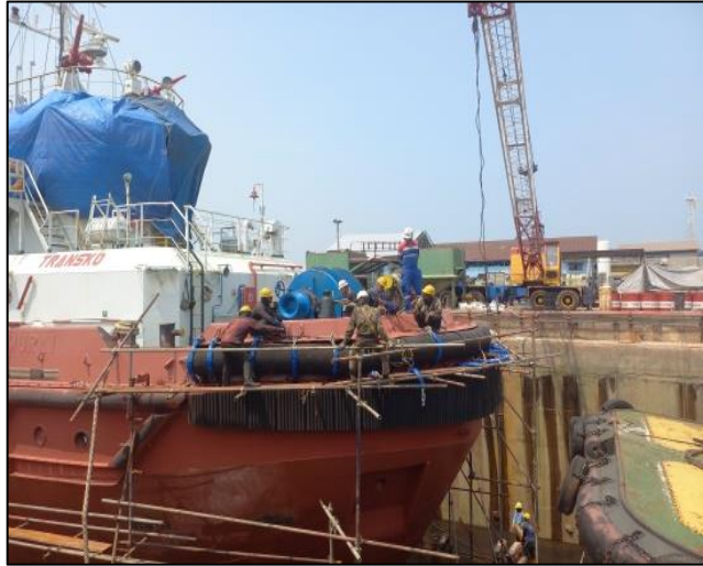
Gambar 2.115 Proses pemasangan Rubber feeder Sumber : Dokumentasi penulis
