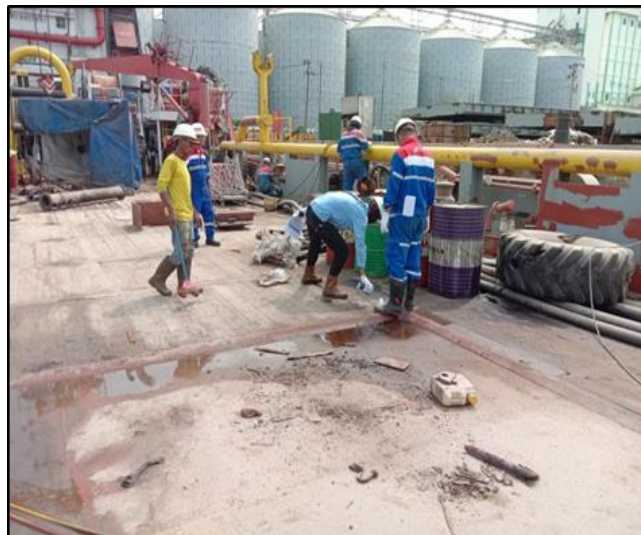
Gambar 2.17 Proses penandaan papan pada deck kapal Sumber : Dokumentasi penulis
