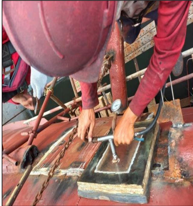
Gambar 2.130 Proses Vakum test Sumber : Dokumentasi penulis
