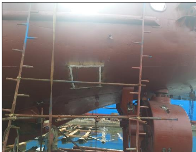
Gambar 2.126 Proses pengujian plat dengan Metode kapur solar Sumber : Dokumentasi penulis
