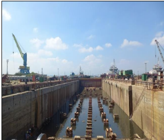
Gambar 2.119 Proses penyusunan kell block Sumber : Dokumentasi penulis
