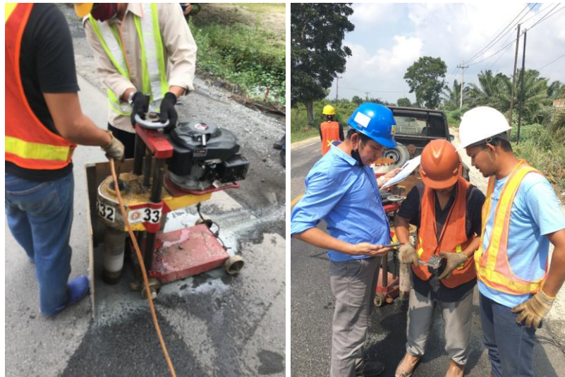
Gambar 3.22 Pengujian core drill
