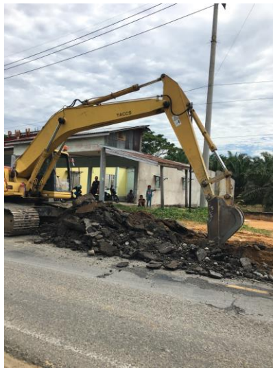
Gambar 4.9 Pengupasan Permukaan Aspal
