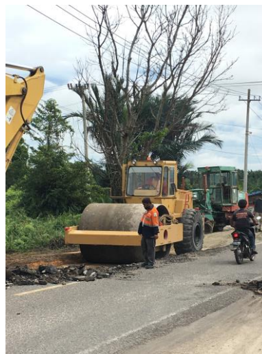
Gambar 3.17 Pemasatan Base A
