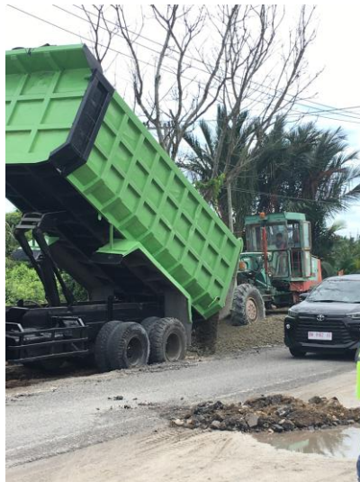
Gambar 3.15 Penuangan Base A
