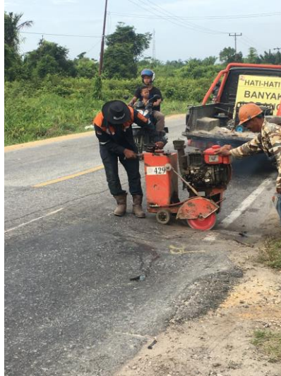
Gambar 3.13 Pemotngan permukaan aspal
