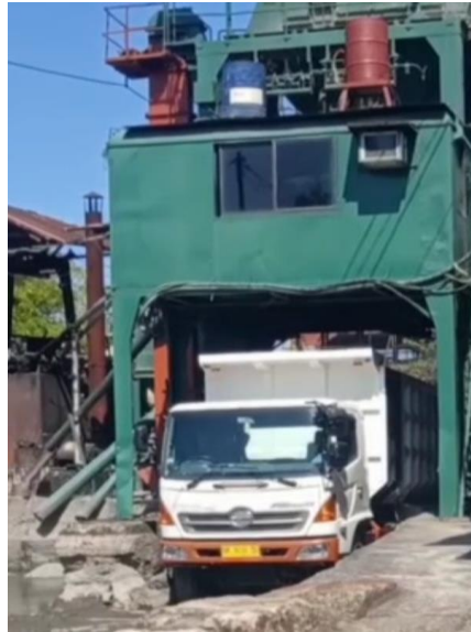
Gambar 4.10 Pencampuran material sebelum dibawa ke lokasi
