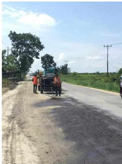
Gambar 3.18 Penyemprotan Prime coat
