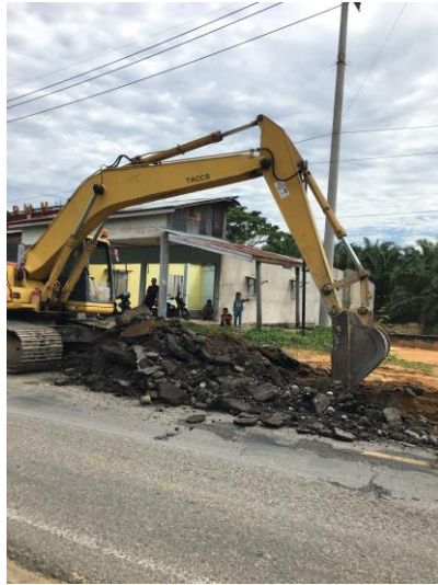
Gambar 3.14 Pengupasan Permukaan Aspal
