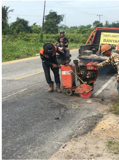
Gambar 4.8 Pemotongan Permukaan Aspal
