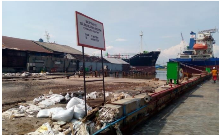
Gambar 1.7 Slipway E PT. Yasa Wahana Tirta Samudera. Sumber : Dokumentasi penulis
