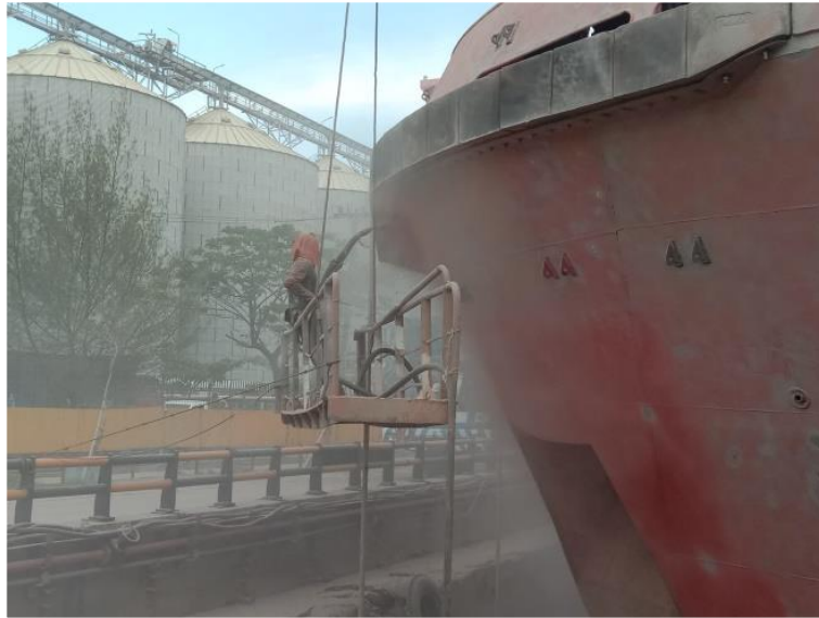
Gambar 2.16 Proses Sand Blasting pada lambung kapal Peteka 5402 Sumber : Dokumentasi penulis
