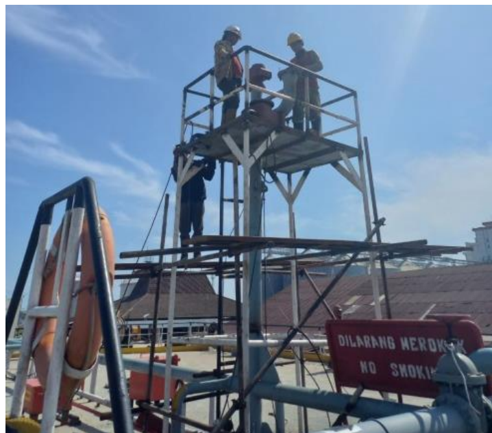
Gambar 2.87 Proses pemasangan tutup Valve Tongkang Taisir Sumber : Dokumentasi penulis
