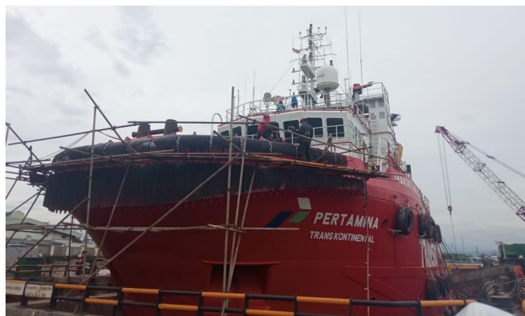
Gambar 2.116 Proses pemasangan rabber feeder kapal Transko Andalas Sumber : Dokumentasi penulis
