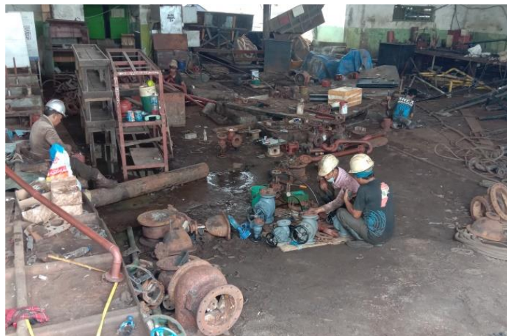
Gambar 2.32 Proses perbaikan Valve Sumber : Dokumentasi penulis
