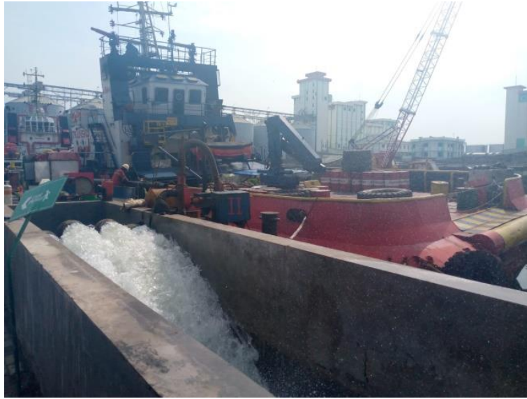
Gambar 2.13 Proses pembuangan /pengeringan air dari Graving Dock Sumber : Dokumentasi penulis
