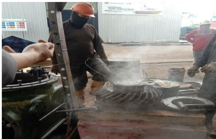
Gambar 2.34 Proses pemasangan bearing upgear kapal Balongan 1 Sumber : Dokumentasi penulis
