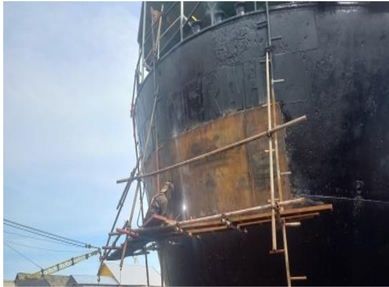
Gambar 2.128 Proses Repleting Buritan kapal MV. Dahlia Merah Sumber : Dokumentasi penulis
