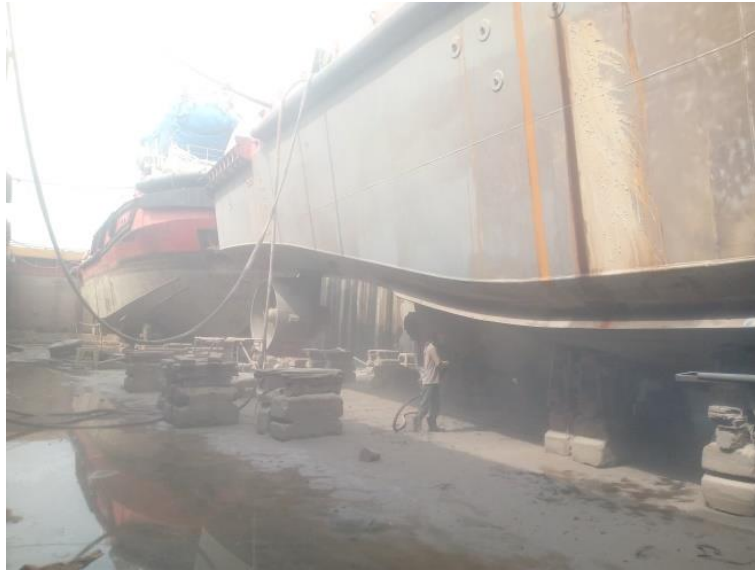
Gambar 2.93 Proses Sandblasting kapal Transko Murai Sumber : Dokumentasi penulis
