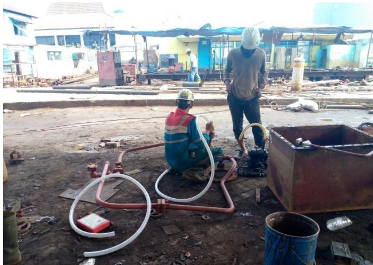
Gambar 2.101 Proses Cleaning Pipa Sumber : Dokumentasi penulis
