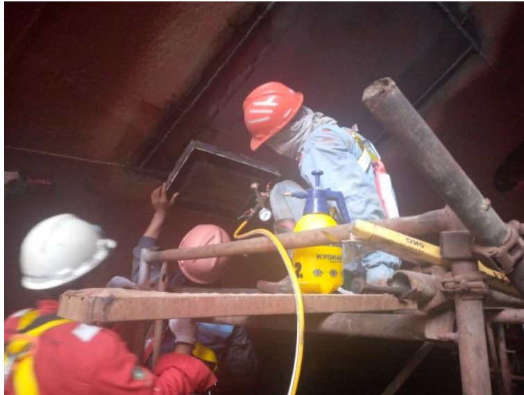
Gambar 2.76 Proses Vakum Test kapal kurau Sumber : Dokumentasi penulis
