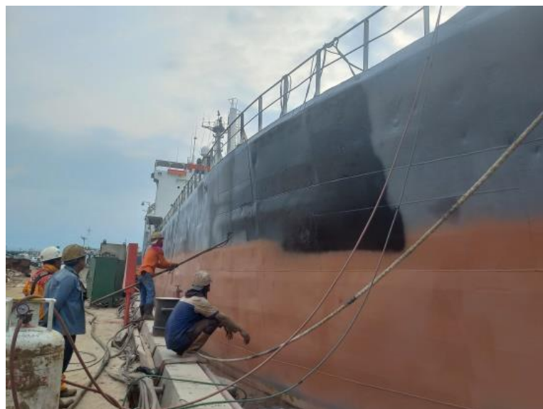
Gambar 2.53 Proses pengecatan finishing lambung bagian bontop kapal Kurau Sumber : Dokumentasi penulis
