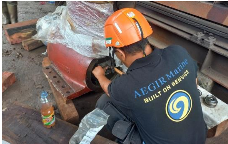
Gambar 2.115 Proses pemasangan Oil Distributor kapal Transko Andalas Sumber : Dokumentasi penulis
