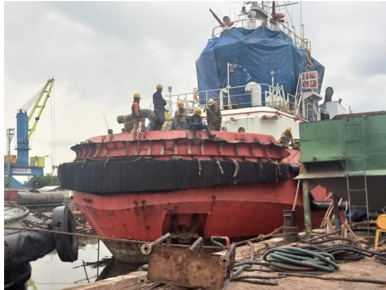
Gambar 2.88 Proses pelepasan Rabber Fidder Kapal Transko Murai
