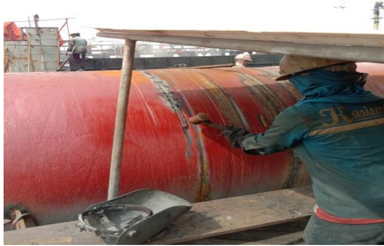
Gambar 2.31 Proses repair Stern Roller kapal Peteka 5402 Sumber : Dokumentasi penulis
