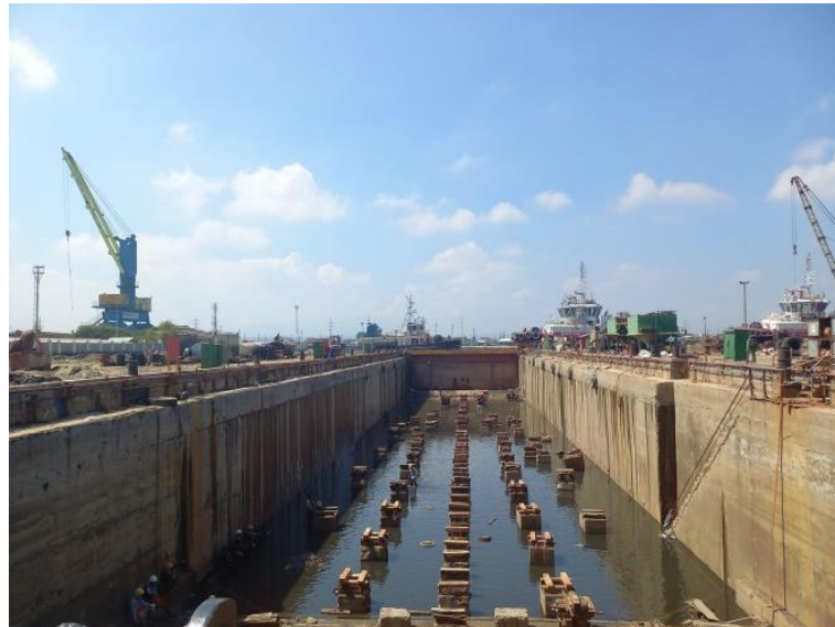
Gambar 2.107 Proses penyusunan kell blok Graving Dock Sumber : Dokumentasi penulis
