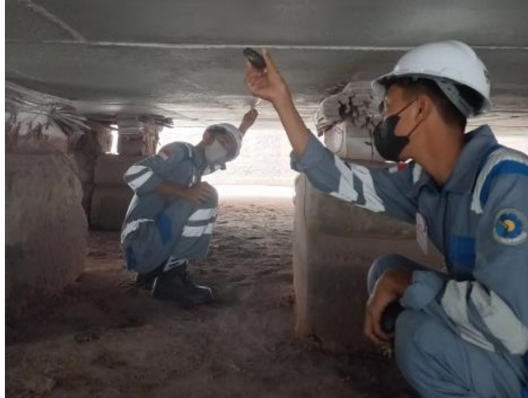
Gambar 2.4 Proses pengukuran jarak frame kapal MV. Lintas Mahakam Sumber : Dokumentasi penulis
