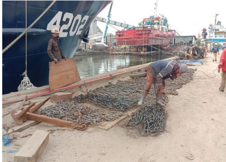
Gambar 2.42 Proses pengecatan rantai jangkar kapal TB. Balongan 1 Sumber : Dokumentasi penulis
