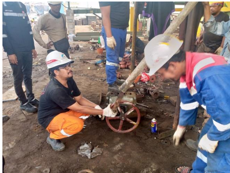
Gambar 2.95 Melihat proses Repair Valve Sea Chest kapal Transko Murai Sumber : Dokumentasi penulis
