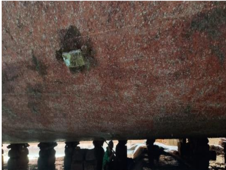
Gambar 2.131 Proses pembersihan Lambung kapal Transko Celebes Sumber : Dokumentasi penulis
