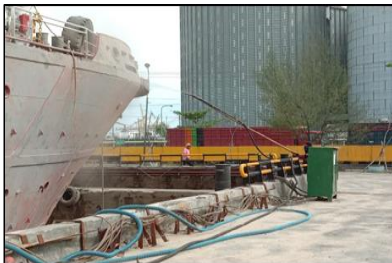
Gambar 2.22 Proses Sand Blasting pada lambung kapal Peteka 5402
