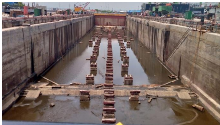
Gambar 1.8 Graving Dock PT. Yasa Wahana Tirta Samudera. Sumber : Dokumentasi penulis
