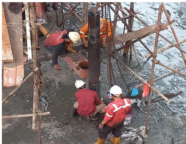
Gambar 2.43 Proses pemasangan rudder stock kapal MV. Lintas Mahakam Sumber : Dokumentasi penulis
