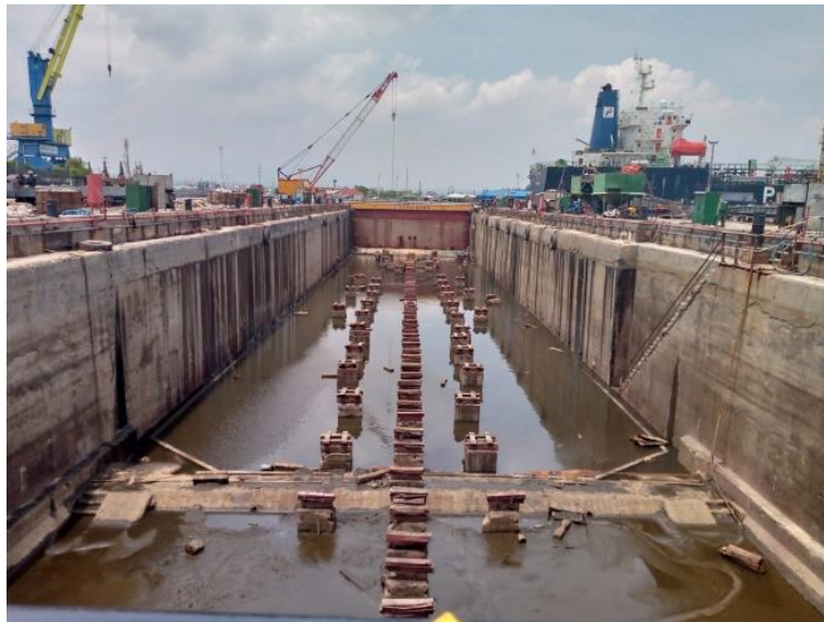
Gambar 2.11 Proses penyusunan keel block Graving Dock Sumber : Dokumentasi penulis
