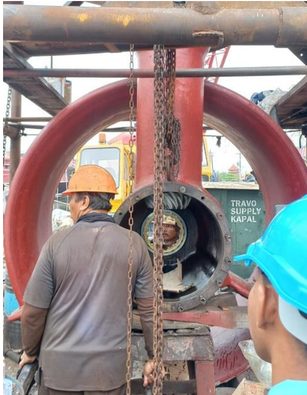
Gambar 2.38 Proses pemasangan bearing shaft propeller kapal TB. Balongan 1 Sumber : Dokumentasi penulis
