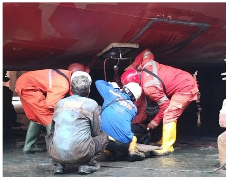
Gambar 2.45 Proses pengujian Vacum Test kapal MV. Lintas Mahakam Sumber : Dokumentasi penulis
