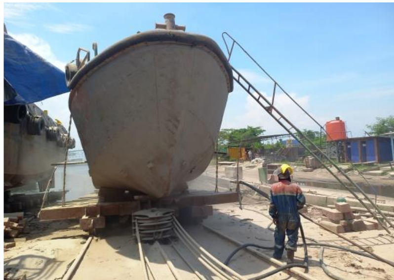
Gambar 2.67 Proses sand blasting lambung kapal Transko patin 03 Sumber : Dokumentasi penulis
