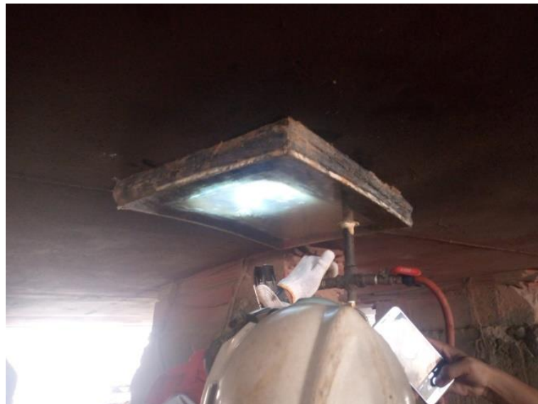
Gambar 2.84 Proses Vakum Test kapal sinar praya Sumber : Dokumentasi penulis
