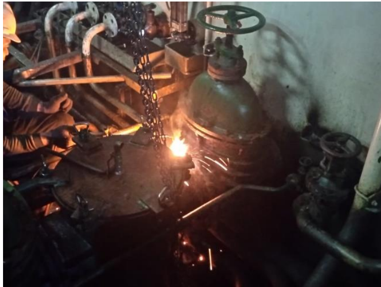
Gambar 2.111 Proses pelepasan Valve Sea Chast kapal Transko Andalas Sumber : Dokumentasi penulis
