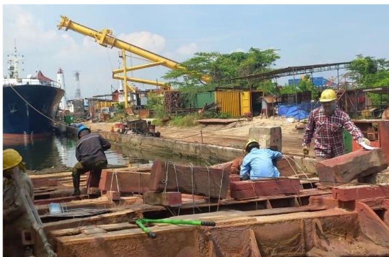
Gambar 2.64 Proses penyusunan keel block Slipway A Sumber : Dokumentasi penulis
