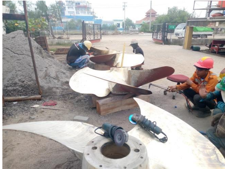
Gambar 2.97 Proses Repair Propeller kapal Transko Murai Sumber : Dokumentasi penulis
