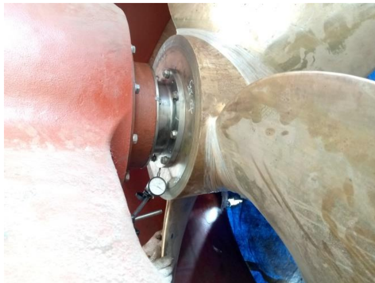
Gambar 2.103 Proses Sentring Leaner kapal Transko Murai Sumber : Dokumentasi penulis
