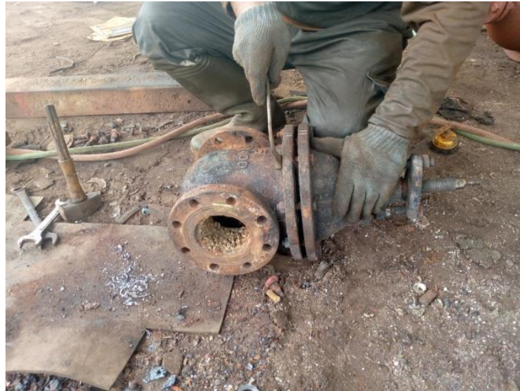
Gambar 2.113 Proses perbaikan Valve
