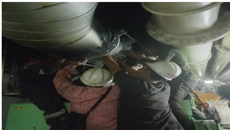
Gambar 2.119 Proses pemasangan Spiral cerobong asap kapal Transko Andalas Sumber : Dokumentasi penulis
