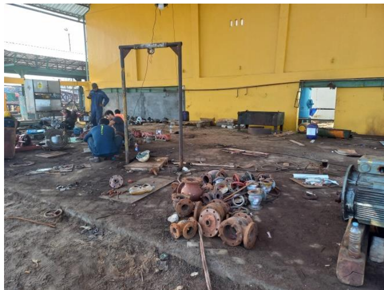
Gambar 2.106 Proses perbaikan Pipa dan Valve Sumber : Dokumentasi penulis
