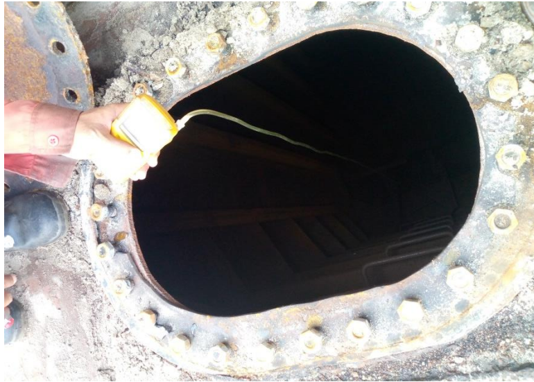
Gambar 2.100 Proses Free Gas Test kapal BKT 301 Sumber : Dokumentasi penulis
