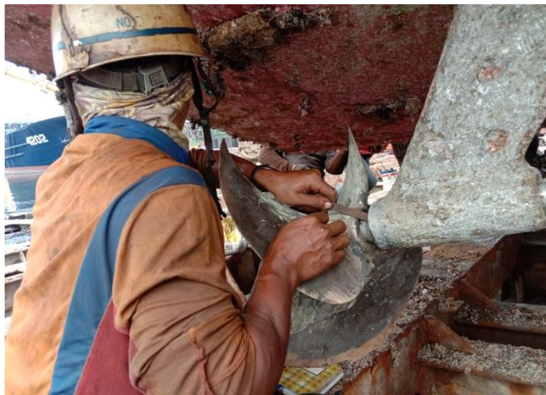
Gambar 2.51 Proses pengukuran clearance bearing shaft propeller Jaya Patriot 12 Sumber : Dokumentasi penulis
