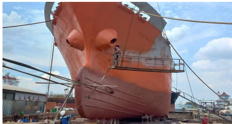
Gambar 2.59 Proses pengecatan finishing bagian top side kapal Gas Mentaya
