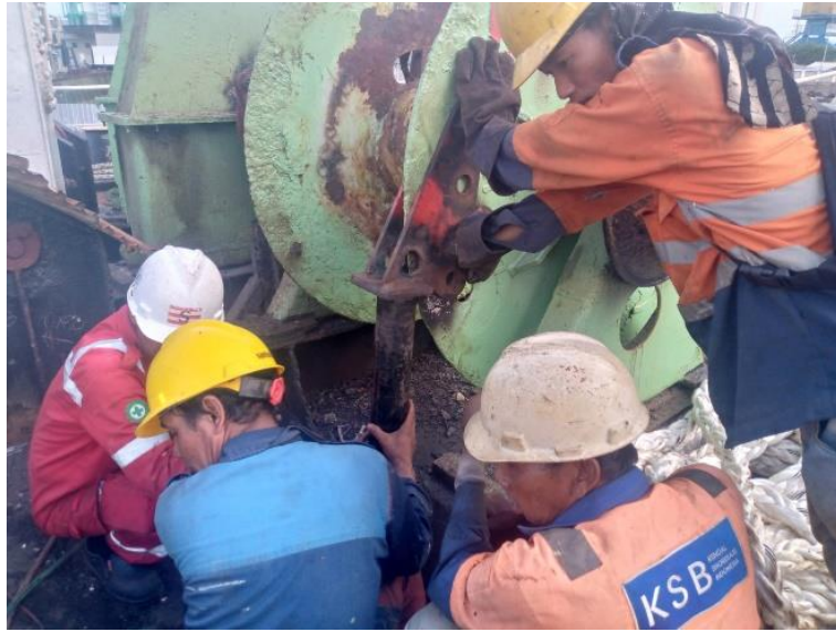
Gambar 2.83 Proses Break Holding Test kapal Sinar Maluku Sumber : Dokumentasi penulis
