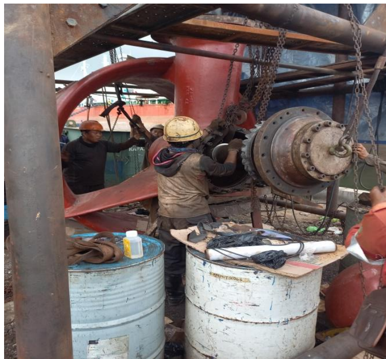
Gambar 2.39 Proses pemasangan shaft propeller kapal TB. Balongan 1 Sumber : Dokumentasi penulis
