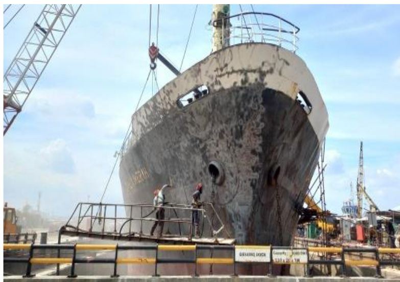
Gambar 2.123 Proses Sandblasting kapal MV. Dahlia Merah Sumber : Dokumentasi penulis
