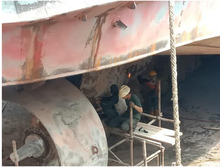
Gambar 2.19 Proses pelepasan Zinc Anode kapal Peteka 5402 Sumber : Dokumentasi penulis
