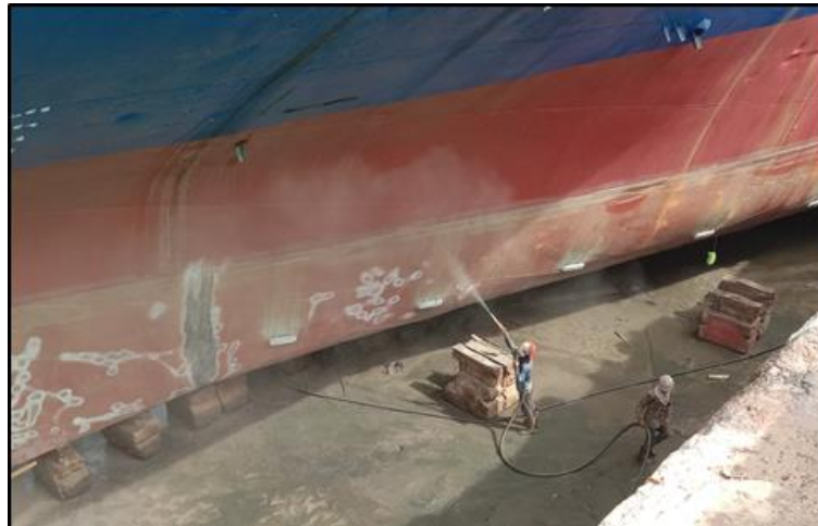
Gambar 2.44 Proses Sand Blasting parsial kapal MV. Lintas Mahakam Sumber : Dokumentasi penulis
