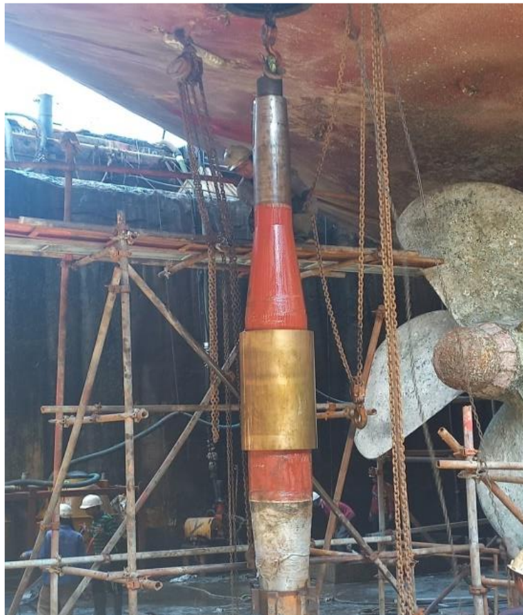
Gambar 2.65 Proses pemasangan poros kemudi kapal MT. Ketaling Sumber : Dokumentasi penulis
