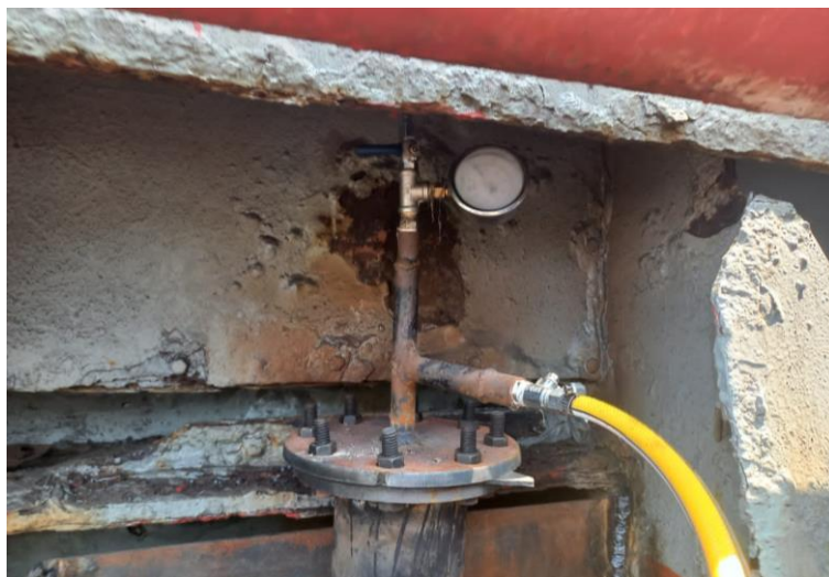
Gambar 2.89 Proses Press Test tangki BBM kapal Sinar Praya
