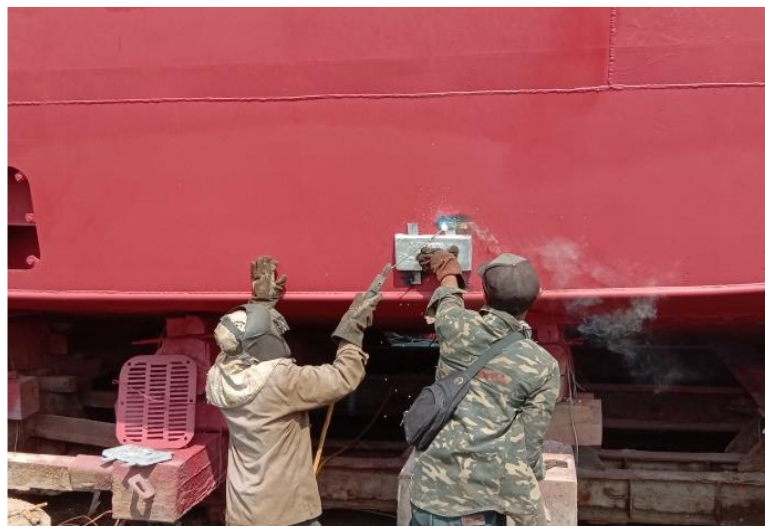
Gambar 2.57 Proses pemasangan Zinc Anode kapal tug boat Sumber Marine 2 Sumber : Dokumentasi penulis
