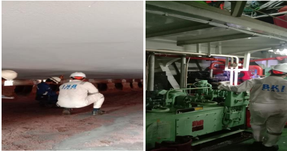
Gambar 2.27 Pemeriksaan Pada Lambung dan Kamar Mesin KM FERRINDO 5
