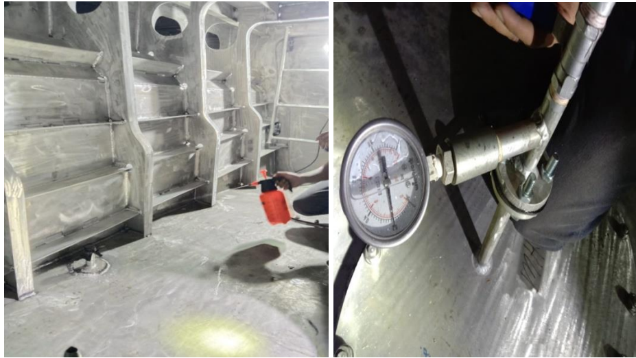
Gambar 2.38 Welding test dan pressure test pada Roro Air Bus
