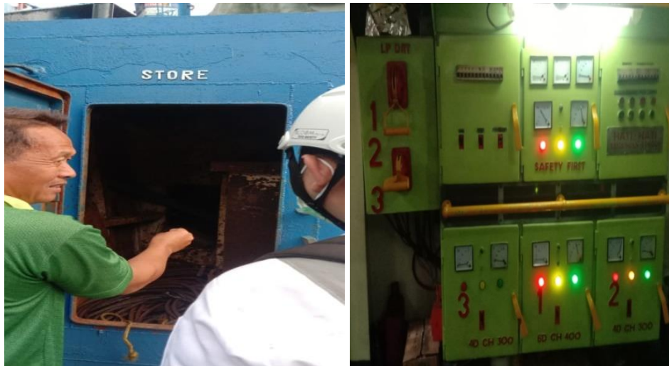
Gambar 2.30 Pemeriksaan pada Lambung dan Kamar Mesin LCT TRANSINDO III
