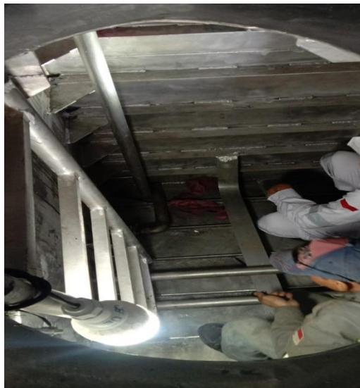
Gambar 2.14 Pemeriksaan kebocoran Void Tank
