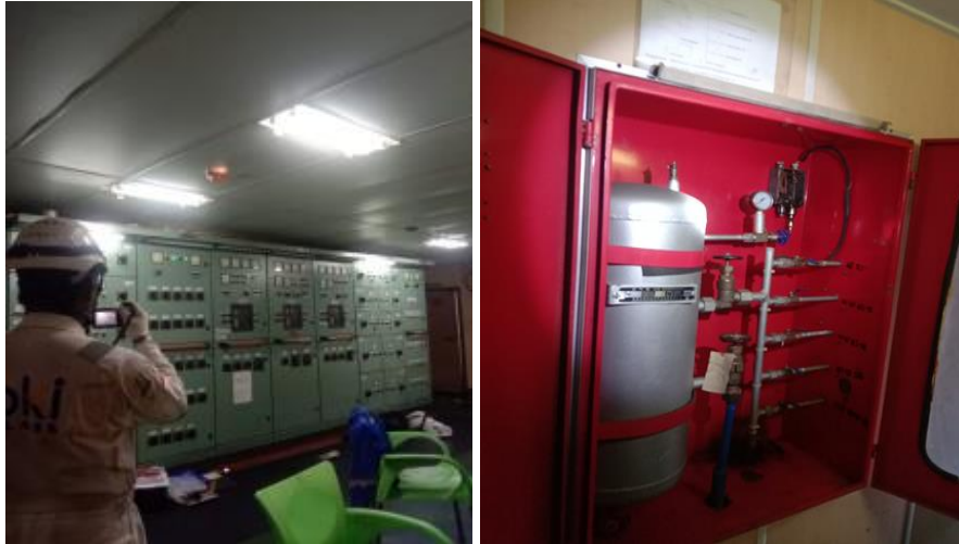
Gambar 2.29 Pemeriksaan pada Lambung dan Kamar Mesin MV. KANAL MAS
