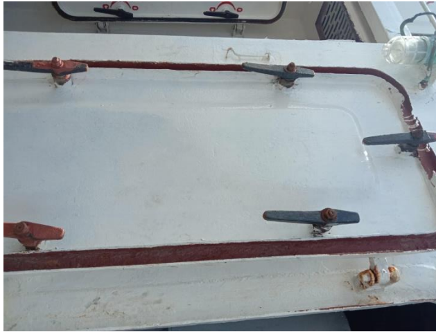
Gambar 3.9 Pintu Kedap Bangunan Atas Kapal Tunda Tinju
