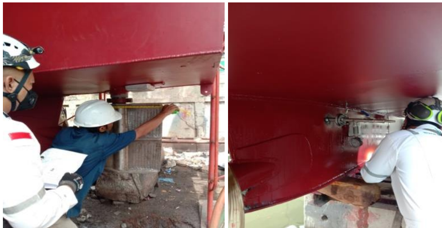
Gambar 2.48 Proses Scantling Check Dan Pressure Test KMP. Pulau Mansinam
