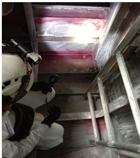
Gambar 2.40 Pemeriksaan Internal Tangki Roro Air Bus
