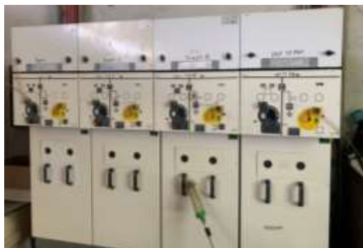
Gambar 2.16 Busbar Fluokit M24+
