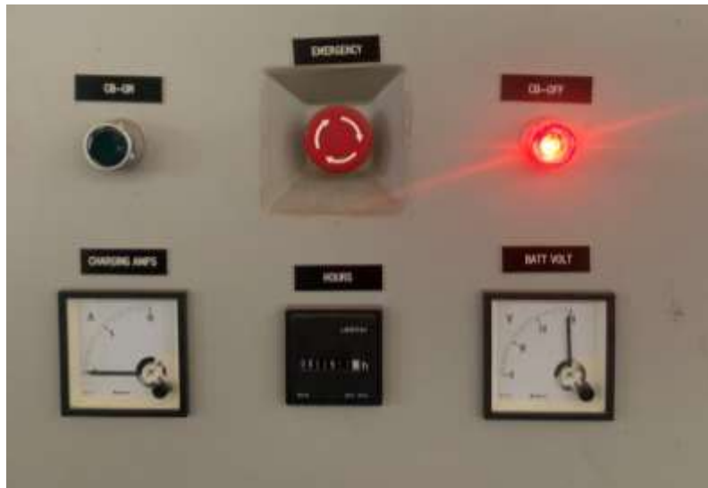
Gambar 3.17 Tanda Sudah Siap Untuk Sinkronisasi
