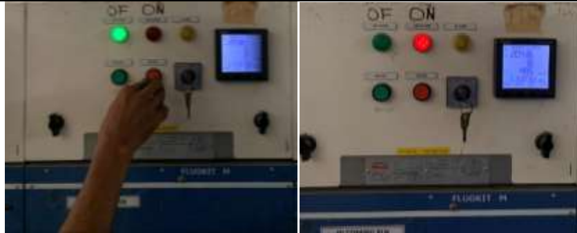
Gambar 2.9 Proses Memindahkan Sumber Listrik Dari Generator ke PLN
