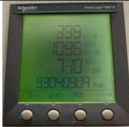
Gambar 2.14 Besar Daya Yang Dihasilkan Oleh Mesin Generator
