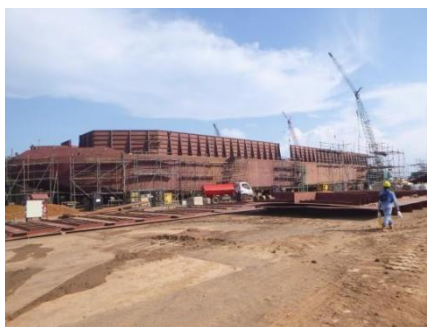
Gambar 1.13 tempat untuk bangunan barge
