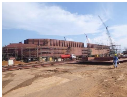
Gambar 1.13 tempat untuk bangunan barge
