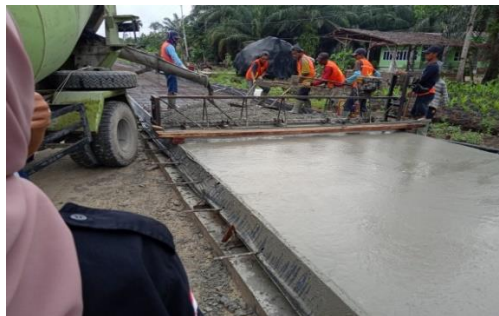
Gambar 1. 13 pengecoran Rigid
