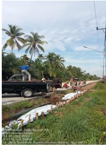
Gambar 1. 5 Penghamparan dan pemadatan tanah timbunan
