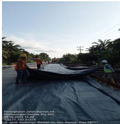
Gambar 1. 4 Pemasangan Geotek/woven kelas 2 Sumber : dokumentasi lapangan2022
