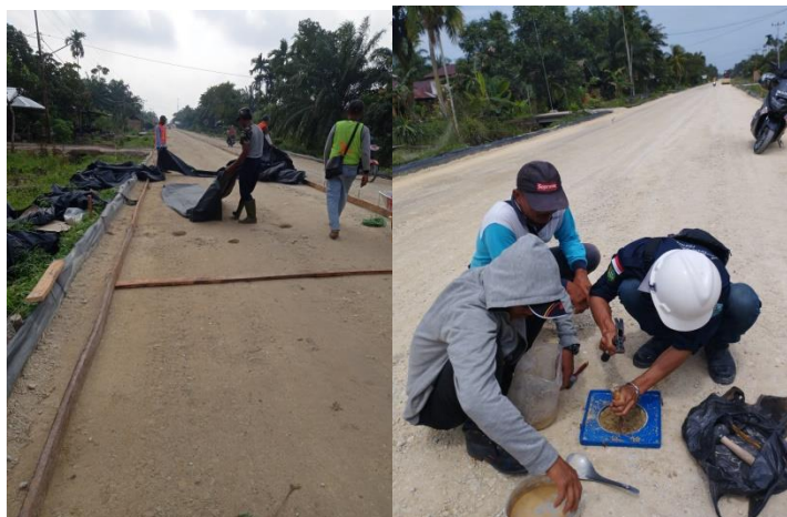
Gambar 1. 11 pemasangan mal lc dan uji sandcone
