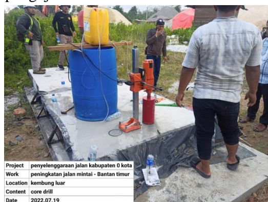
Gambar 1. 9 Pengambilan sampel beton pada badan jalan (rigid)
