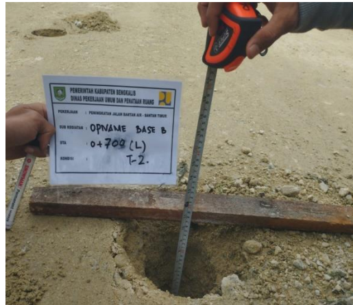
Gambar 1. 10 core base dan pengukuran base B
