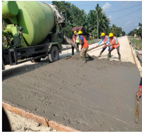
Gambar 1. 12 pengecoran lc
