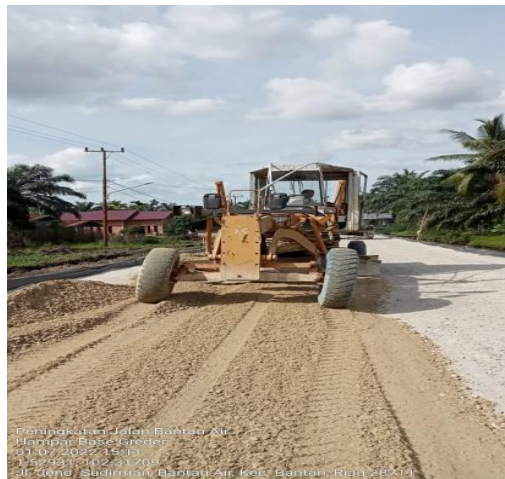
Gambar 1. 7 Penghamparan Base Kelas B Menggunakan Motor Grader Sumber : dokumentasi lapangan2022
