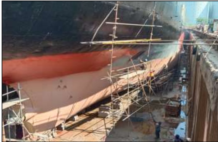
Gambar 2.153 Proses pengecatan tahap anti fouling
