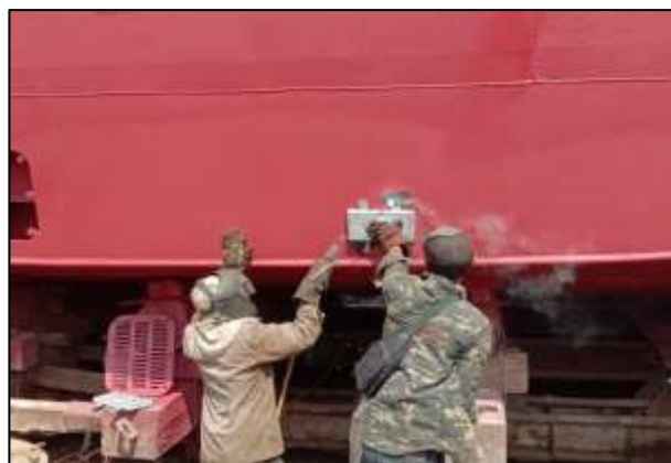
Gambar 2.56 Proses pemasangan Zinc Anode
