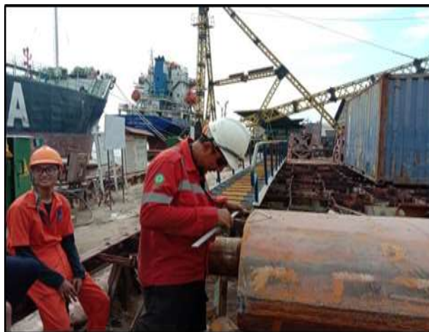
Gambar 2.12 Proses pengukuran diameter pintal kemudi
