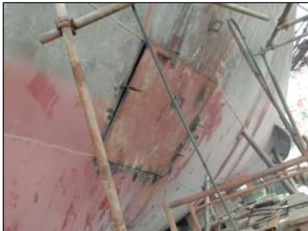
Gambar 2.32 Proses replating pada kapal TB. Balongan 1 Sumber : Dokumentasi penulis
