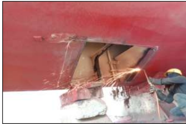
Gambar 2.106 Proses pemotongan plat yang akan di replating
