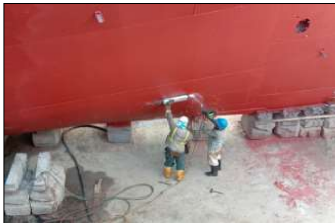
Gambar 2.155 Proses pemasangan zinc anode
