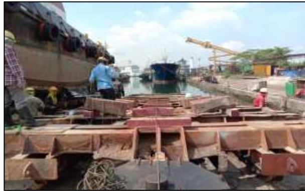
Gambar 2.64 Proses penyusunan keel block pada slipway A
