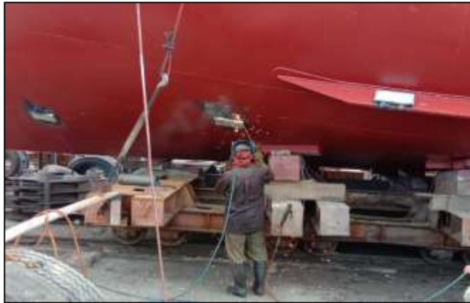
Gambar 2.137 Proses pemasangan zinc anode
