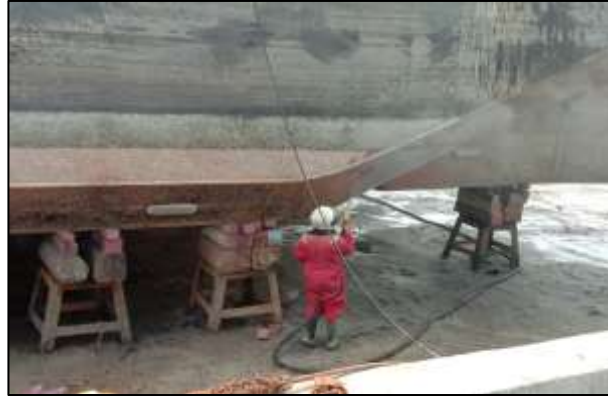
Gambar 2.79 Proses sand blasting kapal tongkang Kapuas 266
