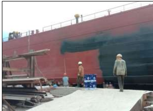
Gambar 2.95 Proses pengecatan tahap kedua ( intermediate coat )
