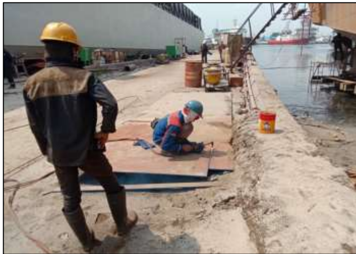
Gambar 3.7 Proses pemotongan plat baru
