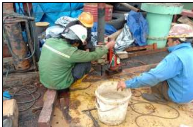
Gambar 2.150 Proses pengeboran lubang baut untuk penutup Duct Peller
