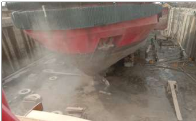
Gambar 2.103 Proses sand blasting pada kapal Transko Walet
