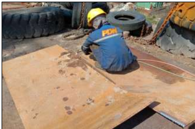
Gambar 2.154 Proses bevel plat baru untuk replating
