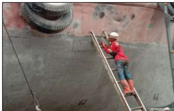
Gambar 2.121 Proses pengecekan ketebalan plat
