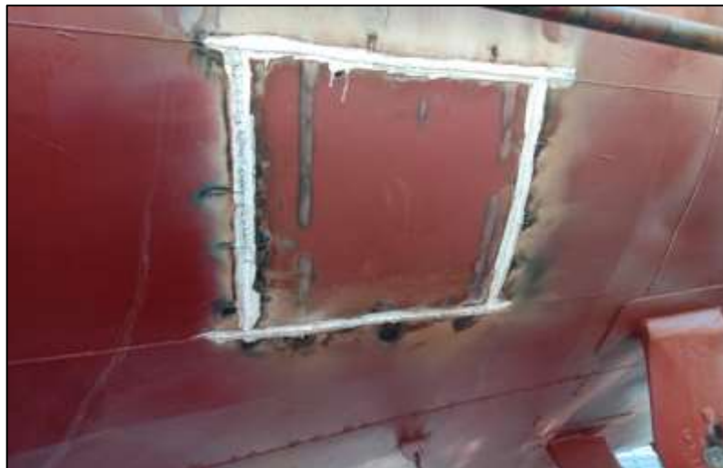
Gambar 3.10 Proses pengujian pengelasan dengan metode kapur solar Sumber: Dokumentasi penulis
