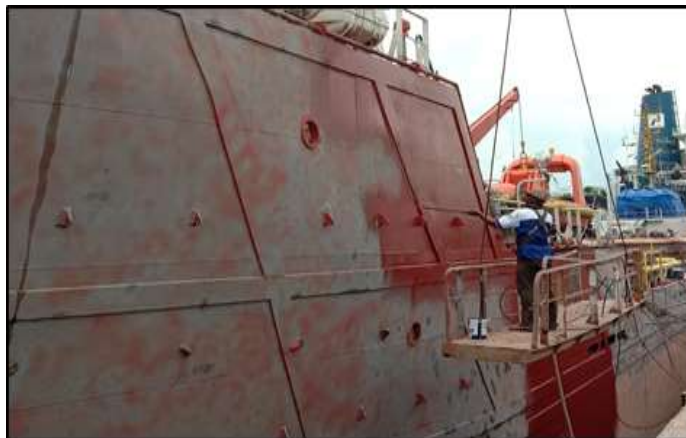
Gambar 2.18 Proses pengecatan AC pada lambung kapal Peteka 5402
