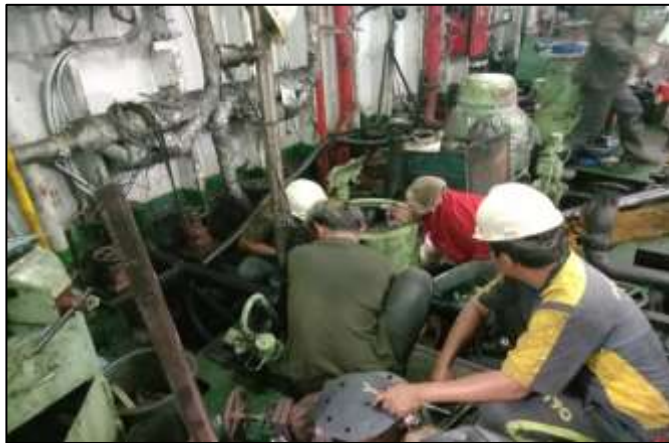
Gambar 2.101 Proses perbaikan pompa air ballast
