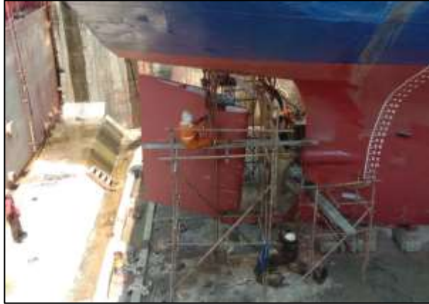
Gambar 2.43 Proses pemasangan daun kemudi
