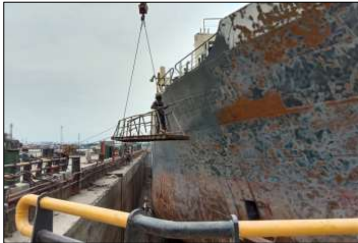
Gambar 2.151 Proses pengecatan tahap anti corrosive
