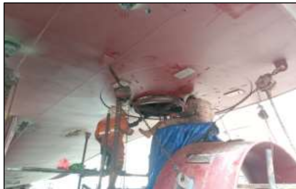
Gambar 2.117 Proses pemasangan seal swivel kapal Transko Walet
