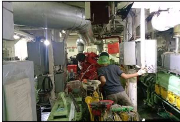
Gambar 2.19 Kondisi Engine Room Kapal
