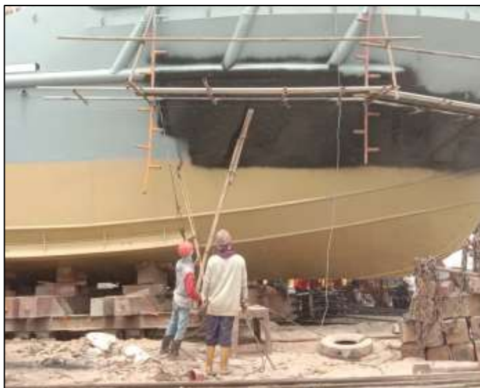
Gambar 2.92 Proses pengecatan tahap finishing
