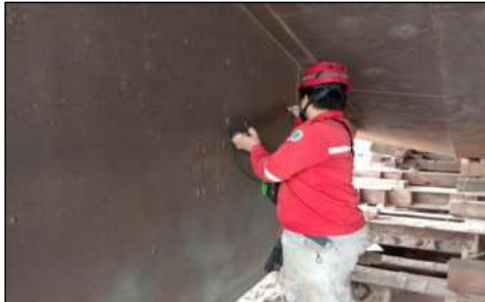
Gambar 2.118 Proses pengecekan ketebalan plat
