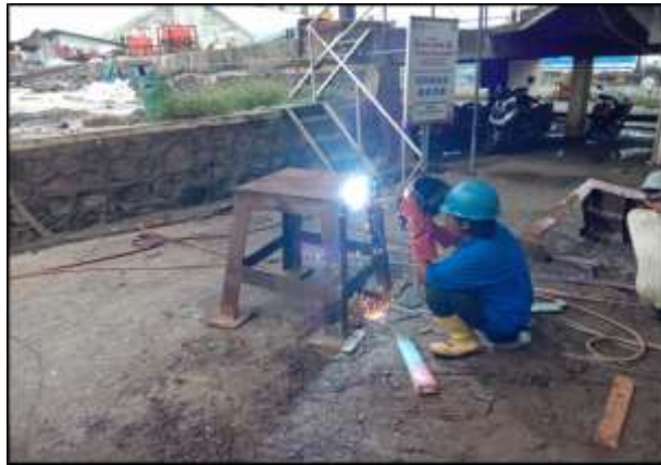
Gambar 2.143 Proses perbaikan stop block
