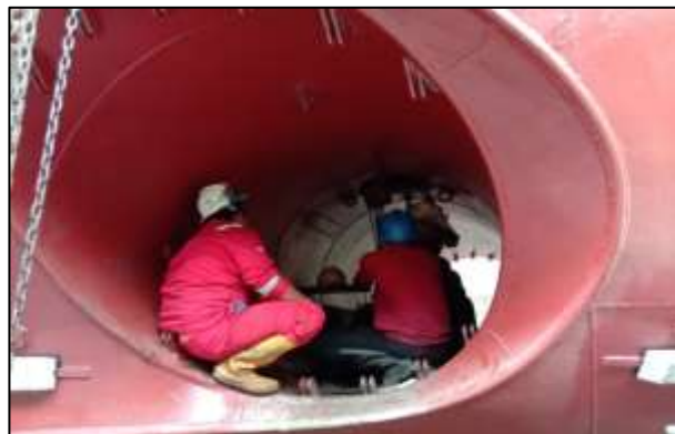
Gambar 2.136 Proses pemasangan bow thruster
