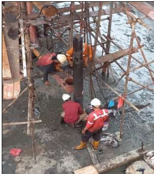
Gambar 2.40 Proses persiapan pemasangan rudder stock
