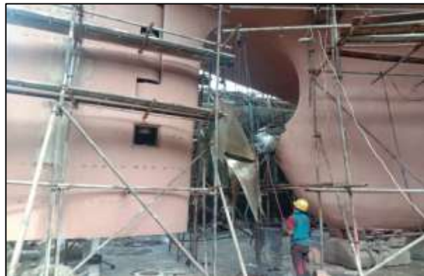
Gambar 2.76 Proses pemasangan propeller kapal MT. Kurau
