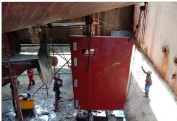
Gambar 2.66 Proses pemasangan daun kemudi ( rudder )
