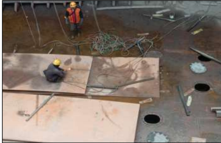
Gambar 2.147 Proses cutting plat baru untuk replating
