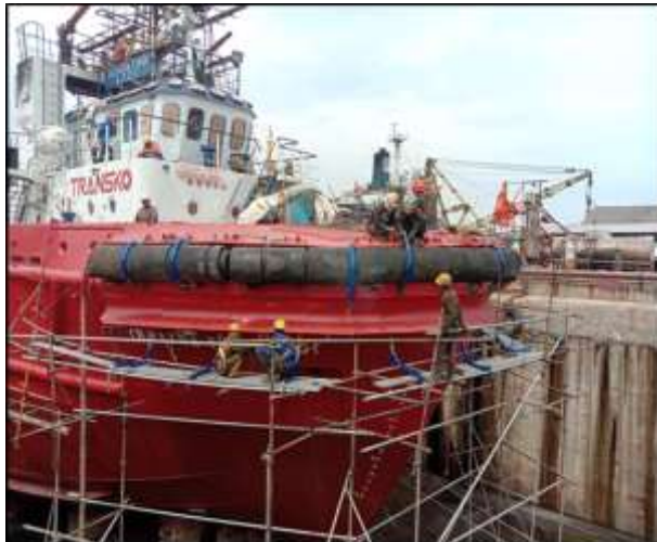
Gambar 2.34 Proses pemasangan rantai untuk Rubber Feeder
