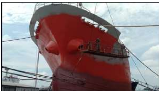
Gambar 2.58 Proses pengecatan finishing pada bagian top side
