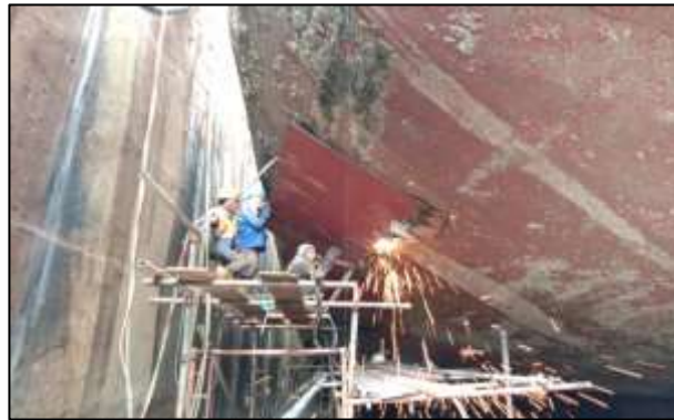
Gambar 2.62 Proses pekerjaan replating pada lambung kapal
