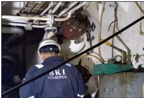
Gambar 2.44 Proses pengujian Press Test botol angin
