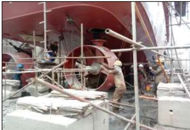
Gambar 2.108 Proses penurunan Z-Peller
