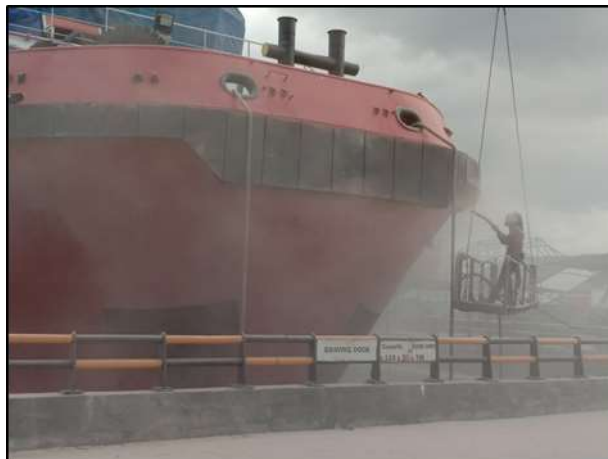
Gambar 2.16 Proses Sand Blasting pada lambung kapal Peteka 5402
