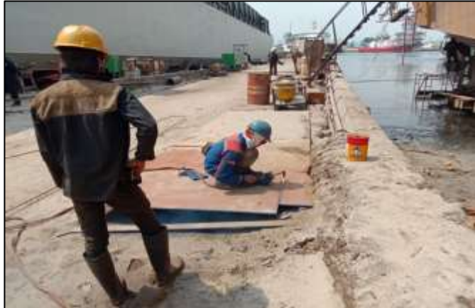
Gambar 2.115 Proses pemotongan ( cutting ) plat untuk replating
