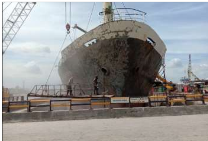
Gambar 2.148 Proses sand blasting kapal MV. Dahlia Merah
