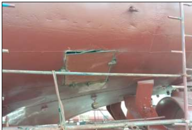
Gambar 3.8 Proses pemasangan plat baru
