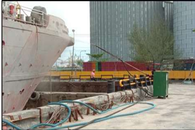
Gambar 2.17 Proses Sand Blasting pada lambung kapal Peteka 5402
