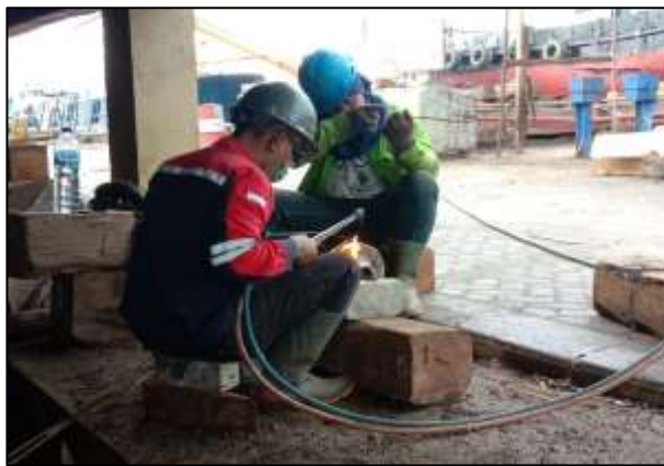
Gambar 2.141 Proses perbaikan impeller pompa
