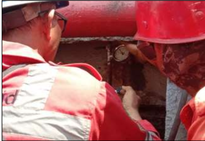
Gambar 2.98 Proses uji Press Test tangki BBM kapal MV. Sinar Praya
