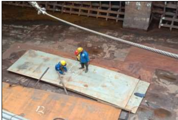
Gambar 2.146 Proses marking plat baru untuk replating
