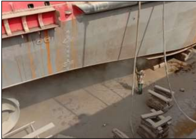
Gambar 2.102 Proses sand blasting pada kapal Transko Murai
