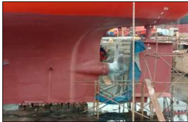
Gambar 2.59 Proses pengecatan tahap finishing silicon pada propeller
