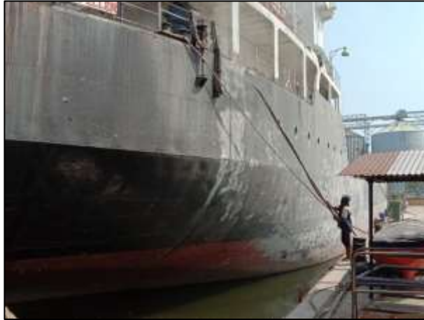
Gambar 2.48 Proses Sand Blasting pada lambung kapal Sumber : Dokumentasi penulis
