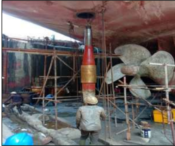
Gambar 2.65 Proses pemasangan poros kemudi ( rudder stock )
