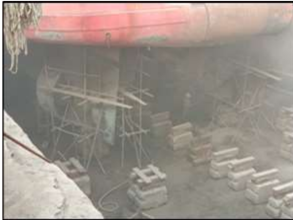
Gambar 2.11 Proses Sand Blasting pada lambung kapal Peteka 5402
