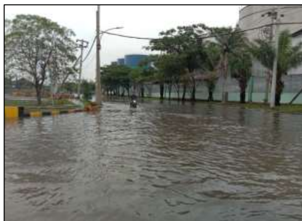
Gambar 2.140 Kondisi jalan yang terendam banjir rob
