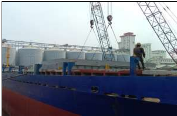
Gambar 2.45 Proses pemasangan tutup palka (Ponton)
