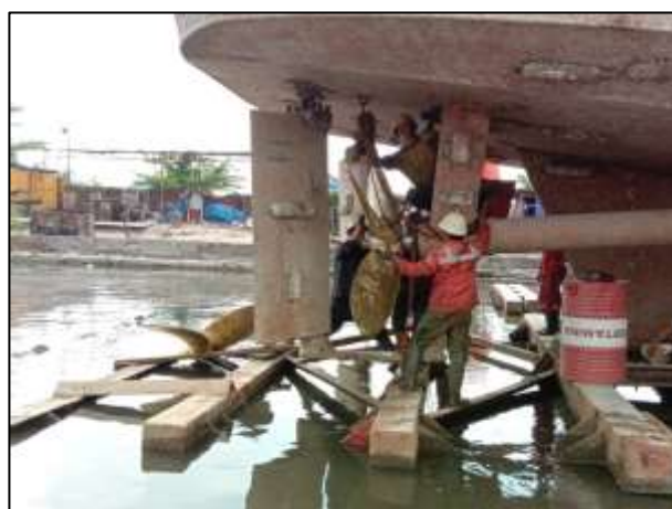
Gambar 2.68 Proses pemasangan propeller
