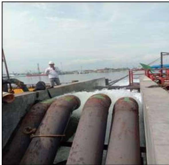
Gambar 2.8 Proses pembuangan /pengeringan air dari Graving Dock
