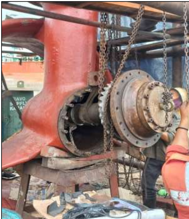
Gambar 2.36 Proses pemasangan shaft propeller
