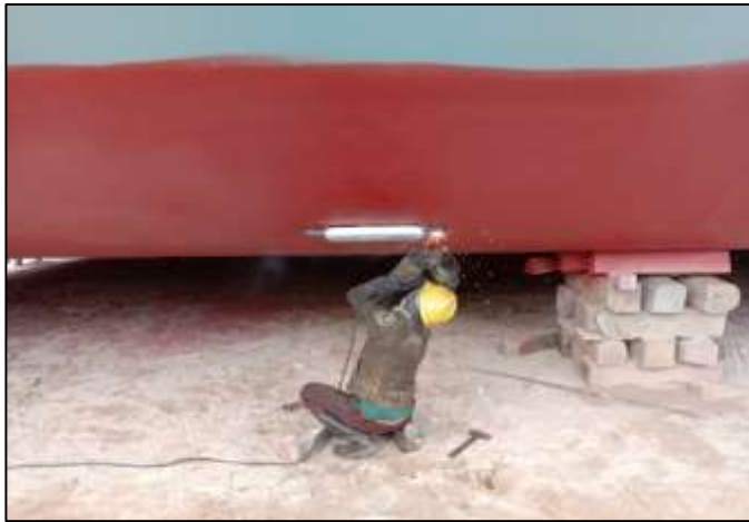
Gambar 2.90 Proses pemasangan zinc anode pada kapal tongkang Taisir
