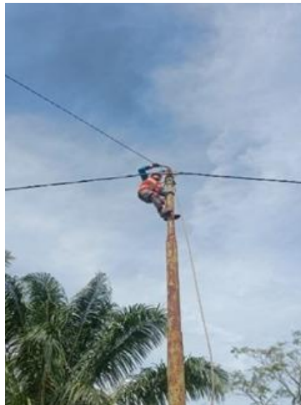
Gambar 2.9. Menaiki Kabel SKU Dan Kabel SR (Sumber: PT. Haleyora Power, 2022)
