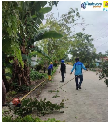
Gambar 2.27. Pemangkasan Jaringan Tegangan Menengah (Sumber: PT. Haleyora Power, 2022)
