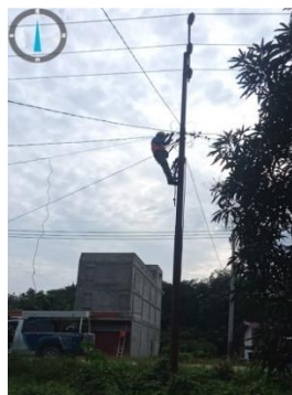
Gambar 2.24. Pemasangan kabel Saluran Rumah(SR) (Sumber: PT. Haleyora Power, 2022)
