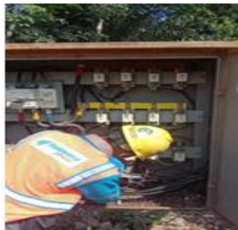
Gambar 2.38. Penyeimbangam Trafo (Sumber: PT. Haleyora Power, 2022)
