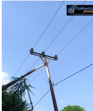
Gambar 2.20. Memasang Kawat Urai (Sumber: PT. Haleyora Power, 2022)
