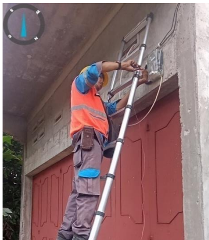
Gambar 2.19. Memasang kwh Meter Baru (Sumber: PT. Haleyora Power, 2022)
