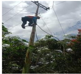
Gambar 2.44. Menyambung kabel SR Putus (Sumber: PT. Haleyora Power, 2022)
