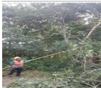
Gambar 2.39. Pemangkasandahan Pohon (Sumber: PT. Haleyora Power, 2022)
