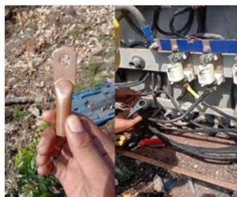
Gambar 2.43. Mengantikan Pin Copper (Sumber: PT. Haleyora Power, 2022)
