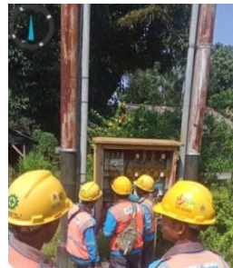
Gambar 2.23. Infeksi Trafo (Sumber: PT. Haleyora Power, 2022)
