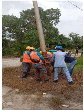
Gambar 2.22. Memindahkan Tiang Yang keropos (Sumber: PT. Haleyora Power, 2022)
