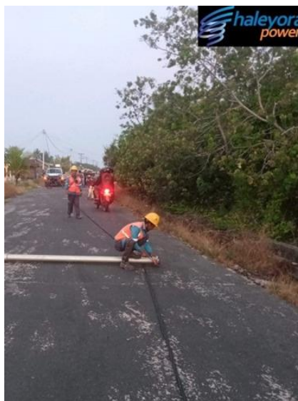
Gambar 2.17. Memperbaiki Tiang Tumbang (Sumber: PT. Haleyora Power, 2022)
