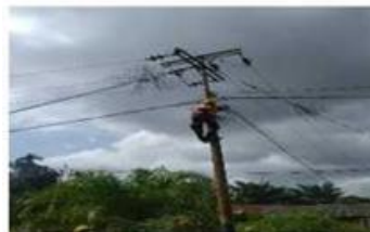
Gambar 2.32. Memasang Kawat Urai (Sumber: PT. Haleyora Power, 2022)
