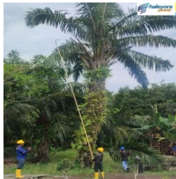
Gambar 2.5. Pemeliharaan JTM (Sumber: PT. Haleyora Power, 2022)
