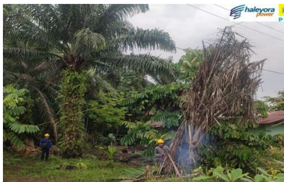
Gambar 2.7. Pemeliharaan JTM (Sumber: PT. Haleyora Power, 2022)
