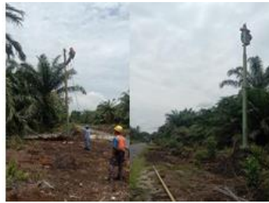
Gambar 2.41. Menaikan Kabel SKU (Sumber: PT. Haleyora Power, 2022)
