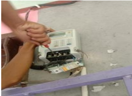
Gambar 2.10. Pergantian Kwh Meter ke Meter Sementara (Sumber: PT. Haleyora Power, 2022)
