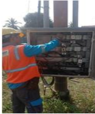
Gambar 2.36. Penyeimbangam Trafo (Sumber: PT. Haleyora Power, 2022)
