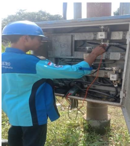
Gambar 2.4. Penyeimbangan Trafo Distribusi (Sumber: PT. Haleyora Power, 2022)
