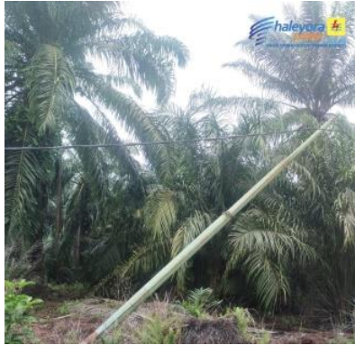
Gambar 2.18. Memperbaiki Tiang Condong (Sumber: PT. Haleyora Power, 2022)
