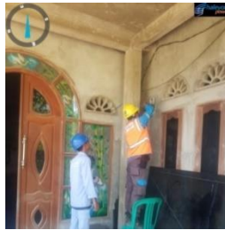
Gambar 2.25. Mengatasi Gangguan Pada kwh (Sumber: PT. Haleyora Power, 2022)
