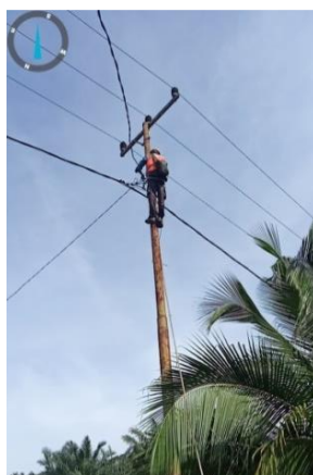
Gambar 2.14. Menyambungkan Kabel Saluran Rumah(SR) (Sumber: PT. Haleyora Power, 2022)
