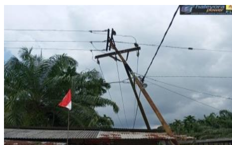
Gambar 2.11. Memperbaiki Tiang Yang Condong (Sumber: PT. Haleyora Power, 2022)
