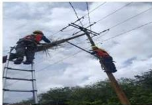
Gambar 2.35. Pemasangan Alkaduri (Sumber: PT. Haleyora Power, 2022)
