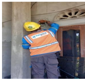
Gambar 2.33. Gangguan Pada kWh (Sumber: PT. Haleyora Power, 2022)
