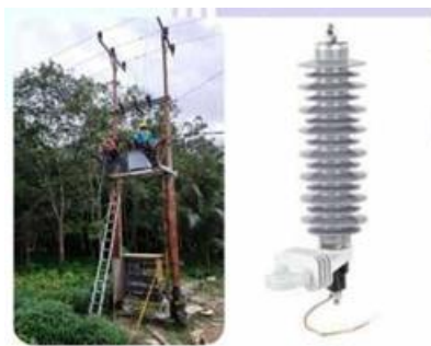
Gambar 2.28. Pemasangan Lightning Arrester(LA) (Sumber: PT. Haleyora Power, 2022)
