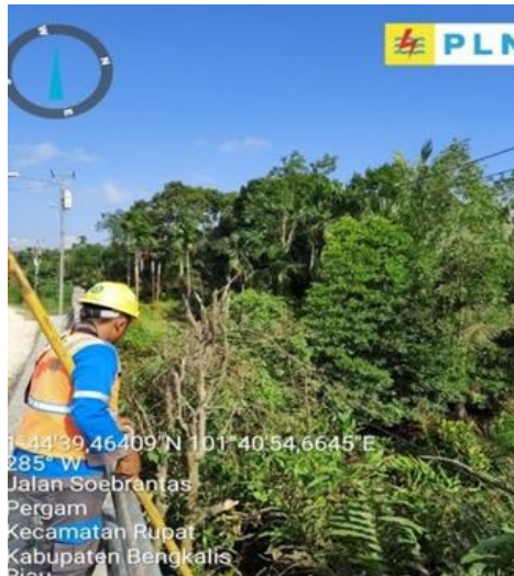
Gambar 2.6. Pemeliharaan JTM (Sumber: PT. Haleyora Power, 2022)
