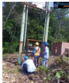
Gambar 2.30. Pemasangan Grounding (Sumber: PT. Haleyora Power, 2022)
