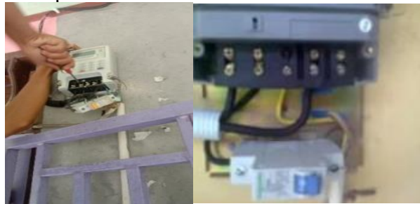
Gambar 3.9. Perbaikan pada kWh Meteran Prabayar (Sumber: PT. Haleyora Power, 2022)
