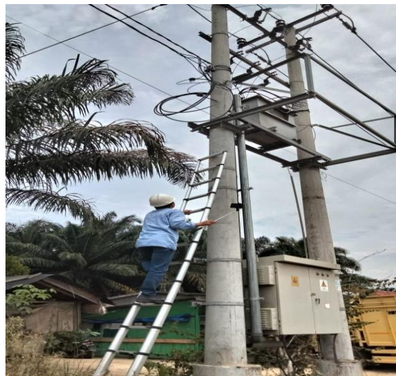
Lampiran 4. Perbaikan instalasi
