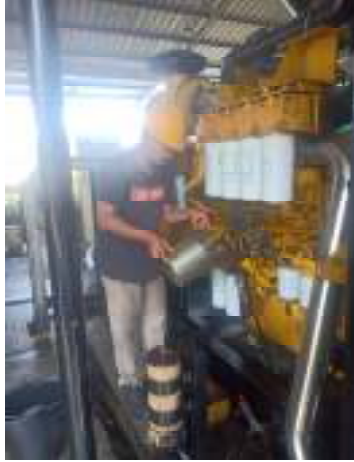
Gambar 2.30 Penambahan oli (Sumber: PT. Megapower Makmur Tbk. 2022)
