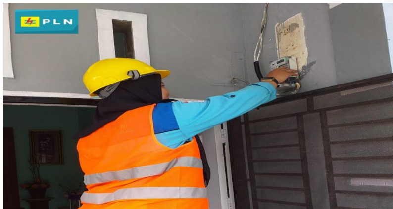
Gambar 2.39 Memasukan kode CT ( Clear Tamper )
