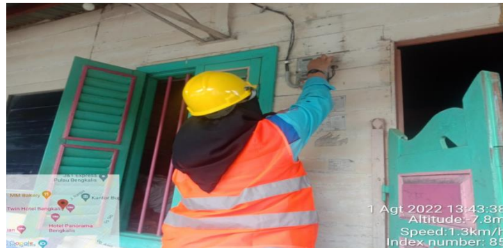
Gambar 2.16 memasukkan kode kct ke rumah pelanggan
