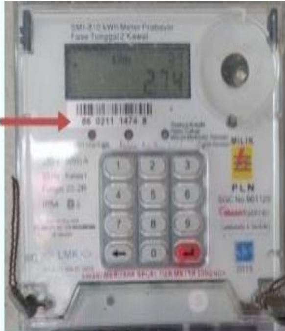
Gambar 3.8 Nomor Kwh Meter
