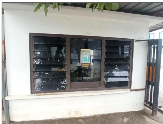
Gambar 1.12 Gambar pos security Sumber : Dokumentasi penulis.
