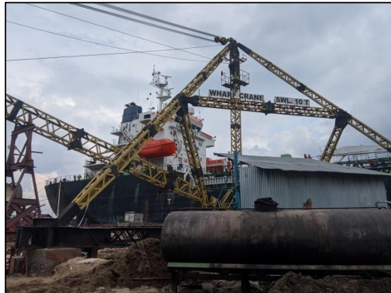
Gambar 1.17 Crane Sumber : Dokumentasi penulis
