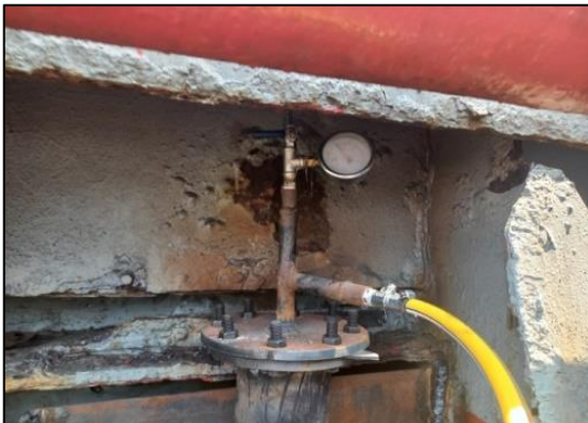
Gambar 2.86 Proses press test tangki kapal BBM Sinar Praya Sumber : Dokumentasi penulis.
