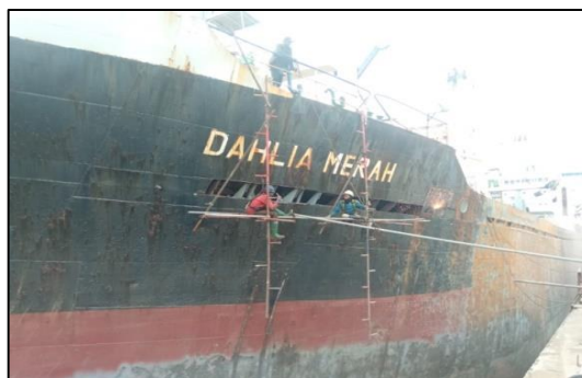
Gambar 2.114 Replating di Bagian Forecastle Deck. Sumber : Dokumentasi penulis.
