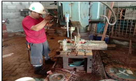
Gambar.2.82 Pengeboran untuk pembesaran lubang baut valve butterfly . Sumber : Dokumentasi penulis.
