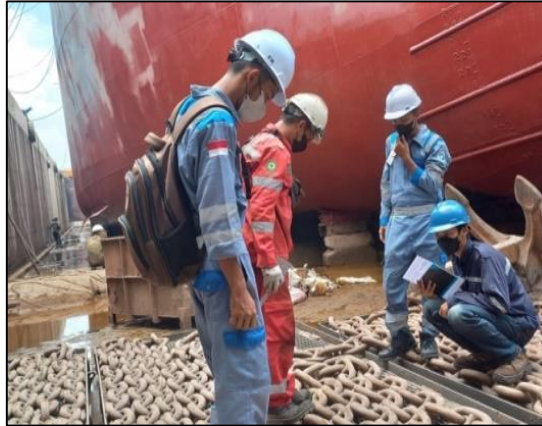
Gambar.2.1 Pengecekan chain locker . Sumber : Dokumentasi penulis.
