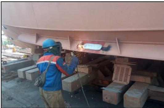
Gambar 2.98 Proses pengelasan zinc anode pada kapal TB. Permata Dolphin. Sumber : Dokumentasi penulis.
