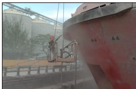
Gambar.2.19 Proses Sandblasting pada bagian haluan kapal Peteka 5402. Sumber : Dokumentasi penulis.
