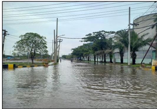
Gambar 2.110 Akses ke galangan/PT kebanjiran. Sumber : Dokumentasi penulis.
