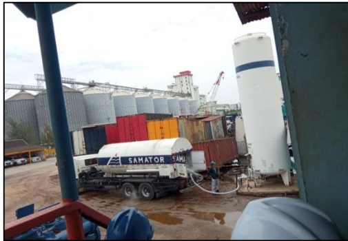
Gambar 1.11 Kompresor PT. Yasa Wahana Tirta Samudera. Sumber : Dokumentasi penulis.
