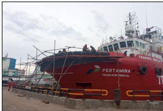
Gambar 2.108 Pemasangan rubber fender kapal transko andalas Sumber : Dokumentasi penulis.
