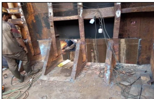
Gambar 2.117 Pemotongan plat Sumber : Dokumentasi penulis.
