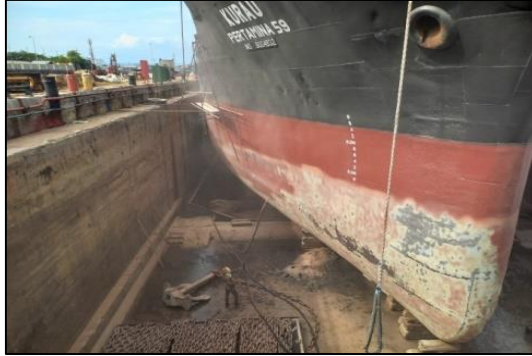
Gambar.2.70 Melihat proses SandBlasting pada kapal MT. Kurau Sumber : Dokumentasi penulis.
