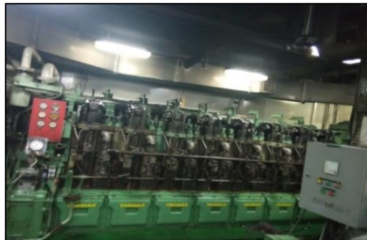
Gambar.2.27 Survei ke Engine Room kapal Peteka 5402. Sumber : Dokumentasi penulis.
