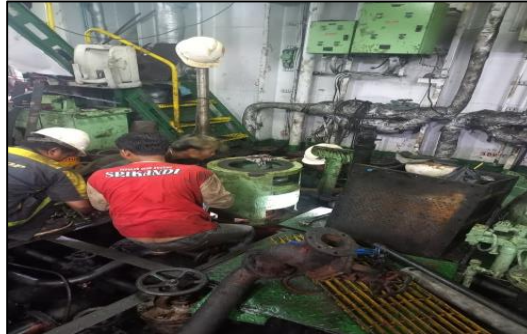
Gambar 2.88 Perbaikan pompa air Ballast di kapal sinar Praya. Sumber : Dokumentasi penulis.
