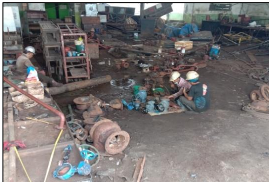
Gambar.2.43 Proses perbaikan (repair) Valve pada bengkel Valve. Sumber : Dokumentasi penulis.
