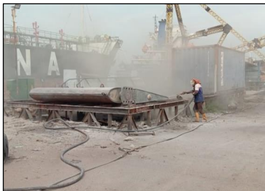
Gambar.2.40 Sandblasting pada daun kemudi kapal MV. Lintas Mahakam. Sumber : Dokumentasi penulis.
