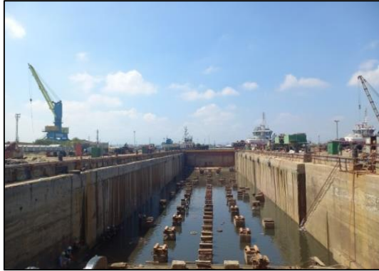
Gambar 2.100 Penyusunan keel blok di graving dock . Sumber : Dokumentasi penulis.
