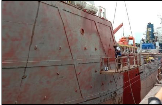
Gambar.2.26 Pengecatan AC tahap pertama kapal Peteka 5402. Sumber : Dokumentasi penulis.
