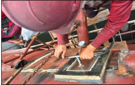
Gambar 2.106 Proses Vakum Test pada kapal Sandia IV. Sumber : Dokumentasi penulis.
