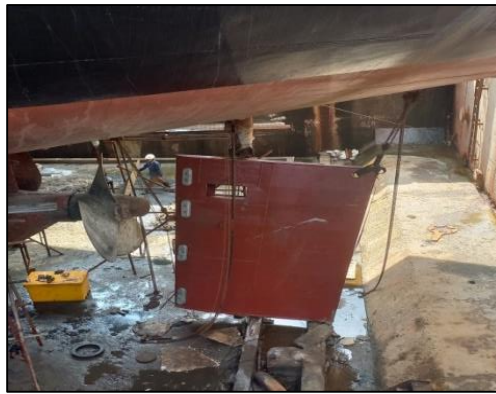
Gambar.2.68 Proses pemasangan daun kemudi pada kapal MT. Ketaling. Sumber : Dokumentasi penulis.
