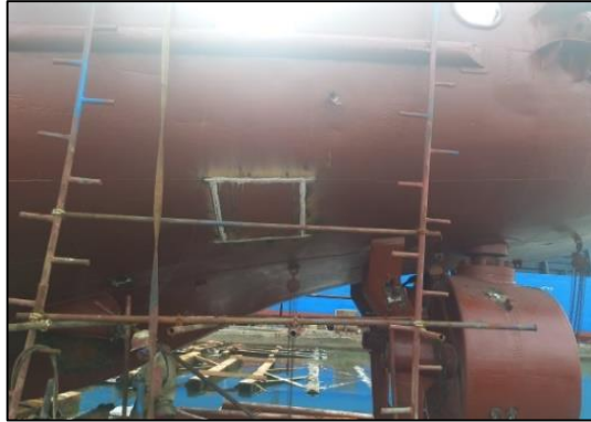
Gambar 2.103 Pengujian pengelasan dengan metode kapur solar pada kapal TB. Sandia IV. Sumber : Dokumentasi penulis.
