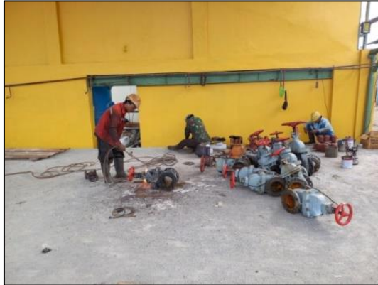
Gambar.2.79 Proses perbaikan (repair) valve di bengkel pipa. Sumber : Dokumentasi penulis.
