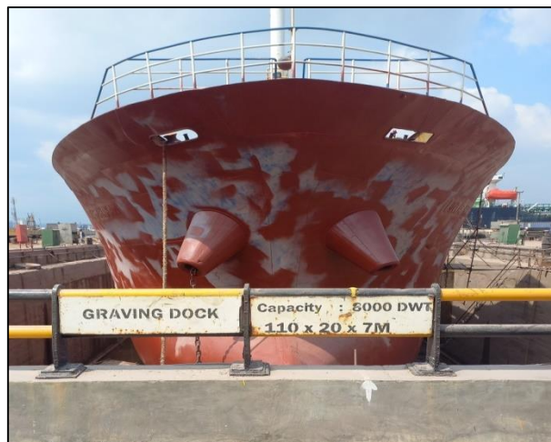
Gambar 1.8 Graving Dock PT. Yasa Wahana Tirta Samudera. Sumber : Dokumentasi penulis.
