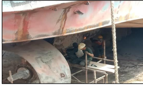
Gambar.2.23 Pelepasan Zinc Anode dari lambung kapal Peteka 5402 Sumber : Dokumentasi penulis.
