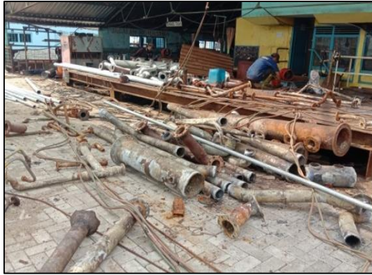
Gambar.2.38 Proses perbaikan pipa. Sumber : Dokumentasi penulis.
