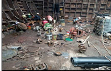
Gambar 2.118 Pengerjaan valve Sumber : Dokumentasi penulis.
