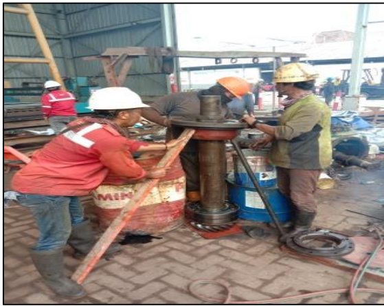
Gambar.2.45 Proses pemasangan bearing upgear . Sumber : Dokumentasi penulis.
