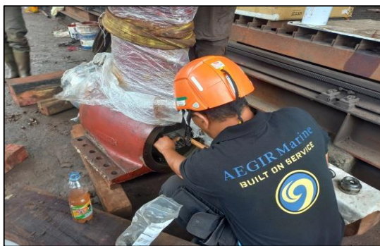
Gambar 2.107 Pemasangan oil distributor untuk kapal Transko Andalas. Sumber : Dokumentasi penulis.
