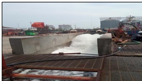
Gambar.2.16 Proses pembuangan/pengeringan air dari Graving Dock. Sumber : Dokumentasi penulis.
