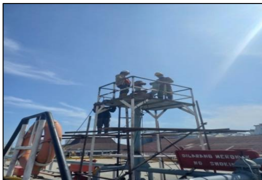
Gambar 2.84 Proses pemasangan tutup valve perangan pada kapal tongkang Taisir. Sumber : Dokumentasi penulis.
