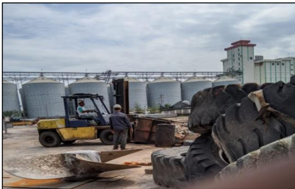
Gambar.2.37 Pembuangan limbah hasil dari sandblasting di gravim dock. Sumber : Dokumentasi penulis.
