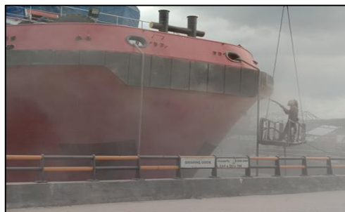
Gambar.2.25 Sandblasting pada lambung kapal Peteka 5402. Sumber : Dokumentasi penulis.
