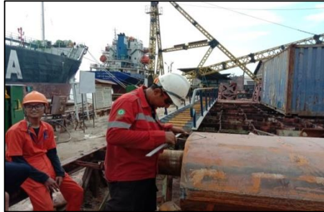
Gambar.2.20 Proses pengukuran diameter pinal kemudi kapal MV. Lintas Mahakam. Sumber : Dokumentasi penulis.
