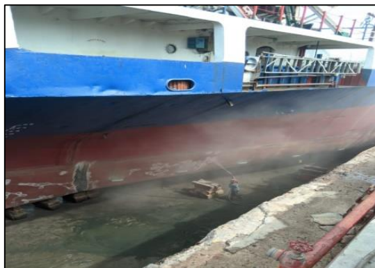
Gambar.2.57 Sand Blasting ke dua pada lambung kapal MV. Lintas Mahakam, Sumber : Dokumentasi penulis.
