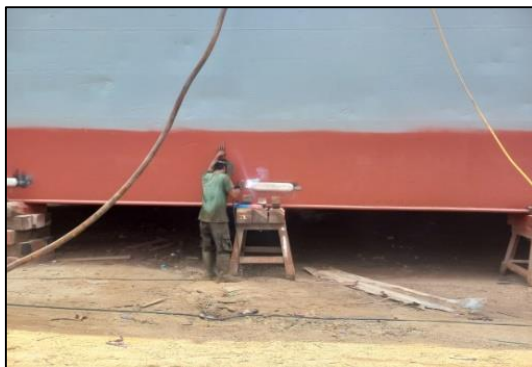
Gambar.2.81 Proses pemasangan zinc anode pada kapal tongkang Taisir. Sumber : Dokumentasi penulis.
