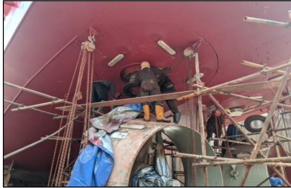
Gambar.2.50 Pemasangan shaft bearing propeller kapal tug boat patra tunda 4201. Sumber : Dokumentasi penulis.
