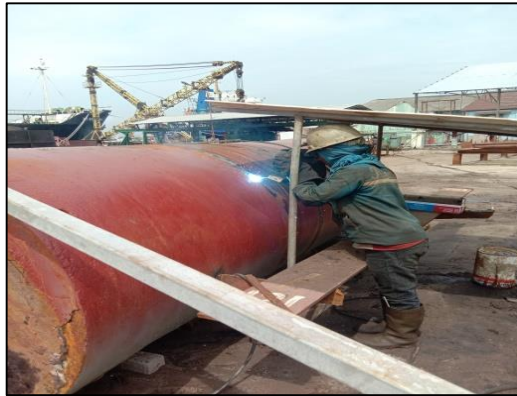
Gambar.2.42 Proses repair Stern Roller kapal Peteka 5402. Sumber : Dokumentasi penulis.
