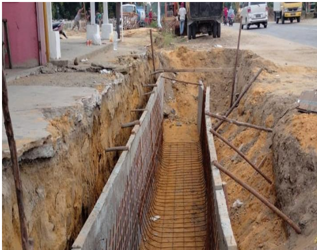
Gambar 3. 20 Pemasangan Mal dan Wiremesh Sumber: Dokumentasi lapangan, 2022
