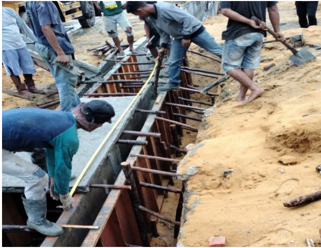
Gambar 3. 22 pekerjaan Pengecoran Dinding Drainase Sumber: Dokumentasi lapangan, 2022
