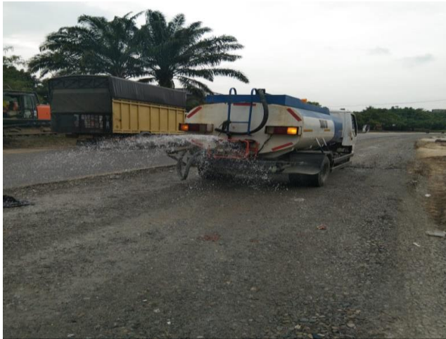
Gambar 3. 18 Pekerjaan Penyiraman Agregat Kelas A Sumber: Dokumentasi lapangan, 2022
