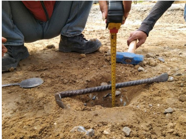
Gambar 3. 14 Test Pit Pada Agregat kelas B Sumber: Dokumentasi lapangan, 2022
