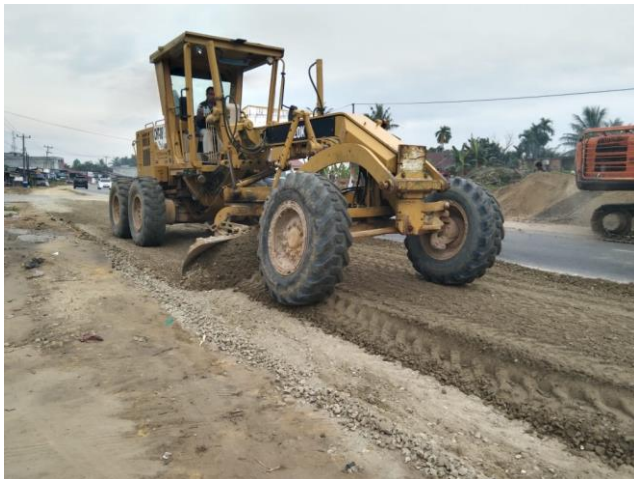
Gambar 3. 12 Pekerjaan Penghambaran Agregat Kelas B Sumber: Dokumentasi lapangan, 2022
