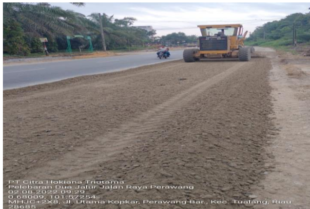
Gambar 3. 15 penghamparan Agregat kelas A Sumber: Dokumentasi lapangan, 2022
