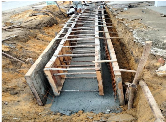
Gambar 3. 21 Pekerjaan Pengecoran Lantai Drainase Sumber: Dokumentasi lapangan, 2022
