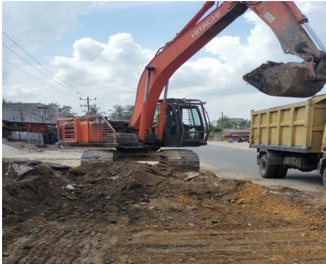
Gambar 3. 10 Pekerjaan Galian dan Pengupasan Badan Jalan Sumber: Dokumentasi lapangan, 2022
