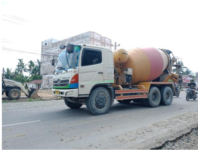
Gambar 3. 9 Concrete Mixer Truck Sumber: Dokumentasi lapangan, 2022
