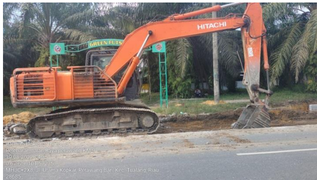
Gambar 3. 3 Excavator Sumber: Dokumentasi lapangan, 2022
