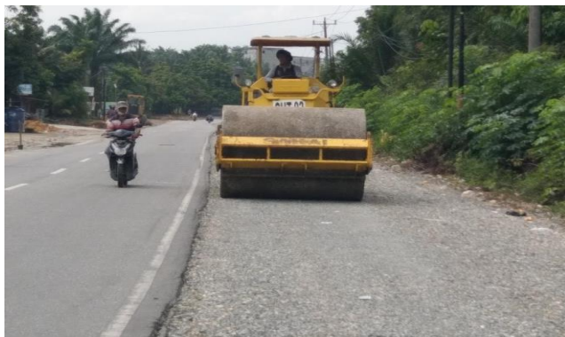
Gambar 3. 16 Pekerjaan Pematatan Lapis Agregat Kelas a Sumber: Dokumentasi lapangan, 2022
