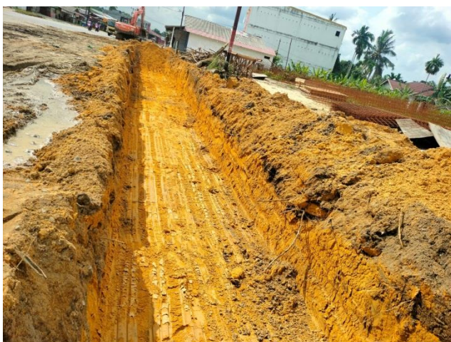
Gambar 3. 19 Pekerjaan Galian Drainase Sumber: Dokumentasi lapangan, 2022
