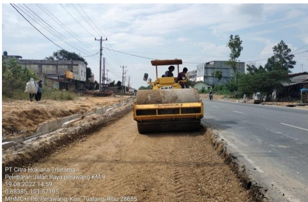
Gambar 3. 13 Pekerjaan Pematatan Lapis Pondasi Agregat Kelas B Sumber: Dokumentasi lapangan, 2022
