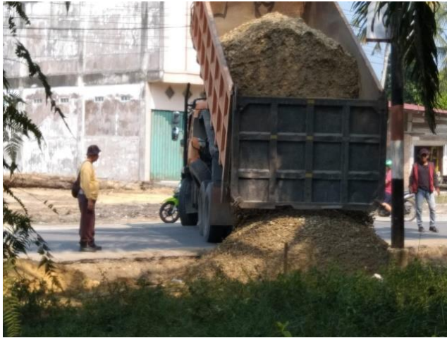
Gambar 3. 11 Base B diturunkan dari Dump Truck Sumber: Dokumentasi lapangan, 2022
