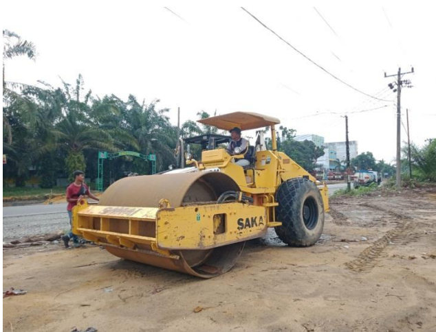
Gambar 3. 6 Vibration Roller Sumber: Dokumentasi lapangan, 2022
