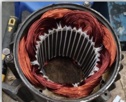
Gambar 3.23 Hasil pemasangan prespan plastik penutup
