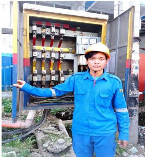
Gambar 2.44. Pemasangan LPC Baru (Sumber : PT. PLN PERSERO ULP Medan Kota)
