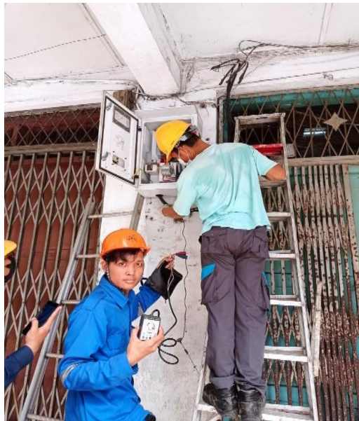
Gambar 2.29. Pemindahan KWH Meter (Sumber : PT. PLN PERSERO ULP Medan Kota)
