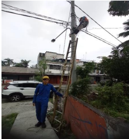
Gambar 2.10. Perbaikan Kabel Jatuh (Sumber : PT. PLN PERSERO ULP Medan Kota)
