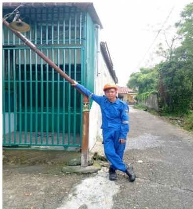
Gambar 2.13. Perbaikan Tiang Patah (Sumber : PT. PLN PERSERO ULP Medan Kota)
