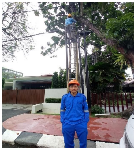
Gambar 2.16. Perbaikan Lampu Jalan (Sumber : PT. PLN PERSERO ULP Medan Kota)
