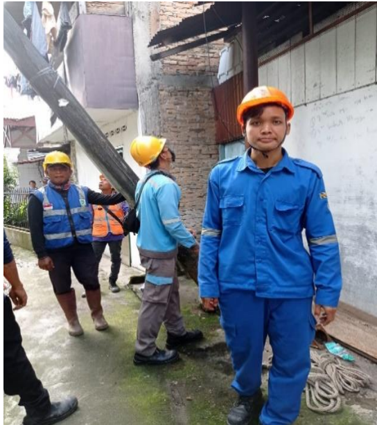
Gambar 2.56. Mengganti Tiang (Sumber : PT. PLN PERSERO ULP Medan Kota)
