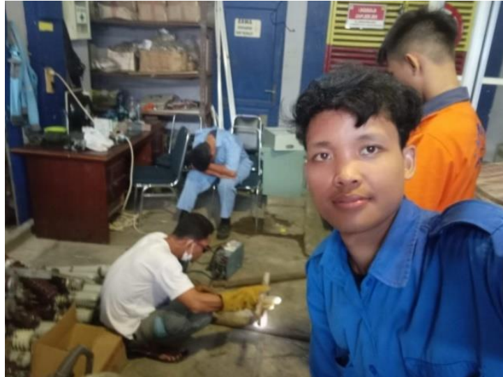
Gambar 2.61. Memasang Breaker 250A (Sumber : PT. PLN PERSERO ULP Medan Kota)
