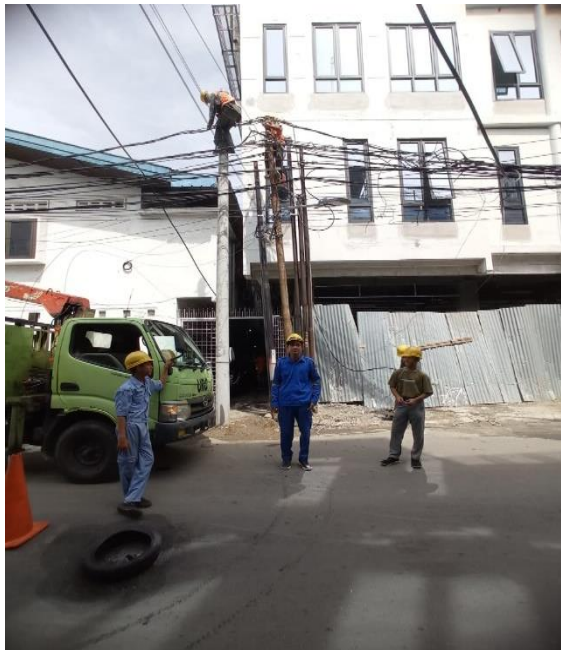
Gambar 2.35. Pemindahan Kabel Ketiang Beton (Sumber : PT. PLN PERSERO ULP Medan Kota)
