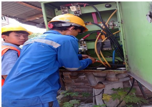
Gambar 2.46. Perbaikan Trafo (Sumber : PT. PLN PERSERO ULP Medan Kota)
