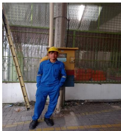
Gambar 2.18. Perbaikan LPC (Sumber : PT. PLN PERSERO ULP Medan Kota)
