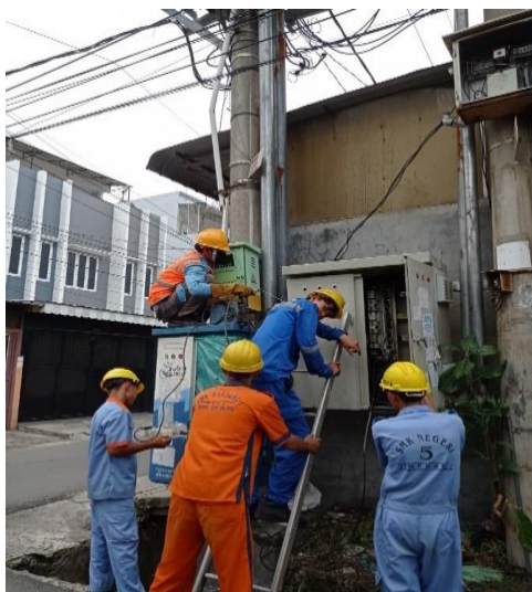
Gambar 2.33. Pemasangan Pintu LPC (Sumber : PT. PLN PERSERO ULP Medan Kota)
