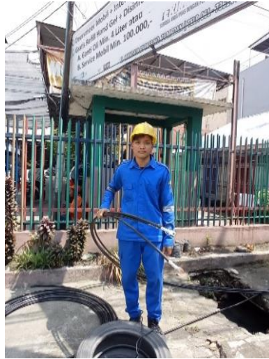
Gambar 2.6. Pemasangan Kabel baru LPC (Sumber : PT. PLN PERSERO ULP Medan Kota)
