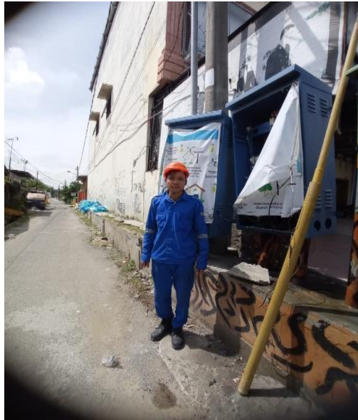
Gambar 2.7. Perbaikan Trafo (Sumber : PT. PLN PERSERO ULP Medan Kota)
