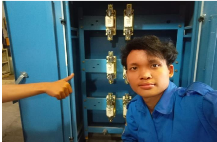
Gambar 2.42. Memasang NT Fuse Dan NT Holder LPC (Sumber : PT. PLN PERSERO ULP Medan Kota)
