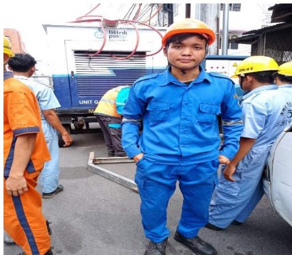
Gambar 2.25. Pemutusan Genset (Sumber : PT. PLN PERSERO ULP Medan Kota)
