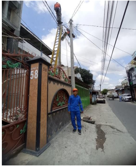
Gambar 2.59. Pemindahan Tiang (Sumber : PT. PLN PERSERO ULP Medan Kota)
