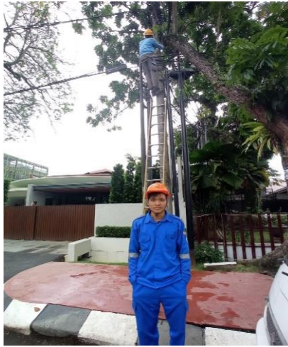
Gambar 2.15. Perbaikan Lampu Jalan (Sumber : PT. PLN PERSERO ULP Medan Kota)
