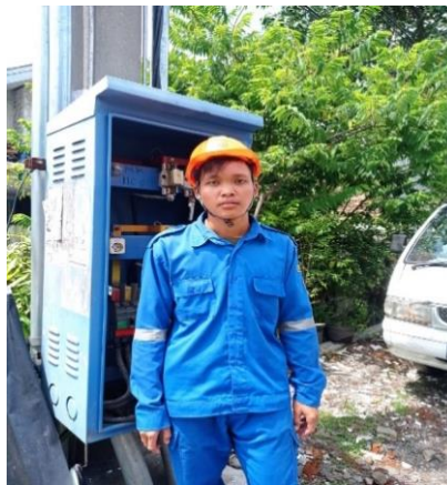
Gambar 2.14. Perbaikan Kabel Grounding (Sumber : PT. PLN PERSERO ULP Medan Kota)
