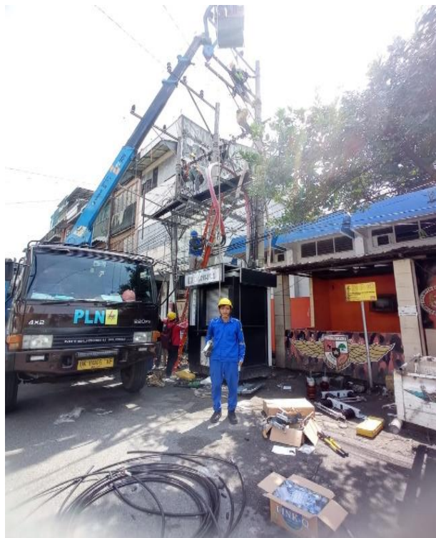
Gambar 2.34. Pemeliharaan Dan Pemangkasan JTM (Sumber : PT. PLN PERSERO ULP Medan Kota)
