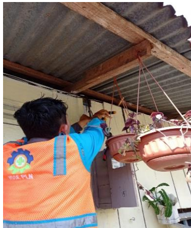
Gambar 2.21. Perbaikan KWH meter (Sumber : PT. PLN PERSERO ULP Medan Kota)
