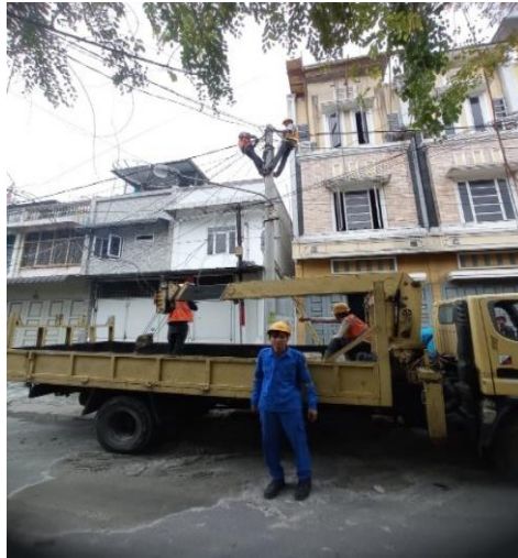
Gambar 2.30. Pemindahan Tiang (Sumber : PT. PLN PERSERO ULP Medan Kota)
