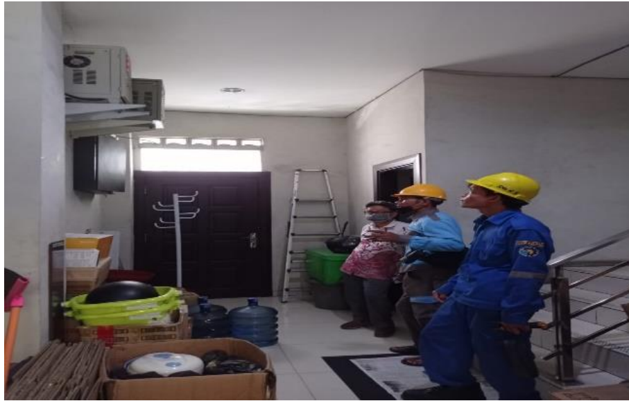
Gambar 2.47. Perbaikan KWH Meter (Sumber : PT. PLN PERSERO ULP Medan Kota)
