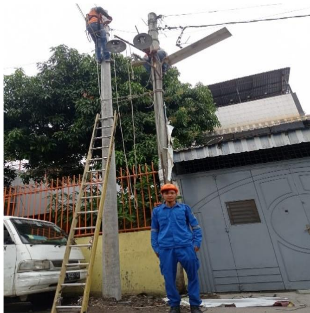
Gambar 2.62. Mengganti Tiang (Sumber : PT. PLN PERSERO ULP Medan Kota)
