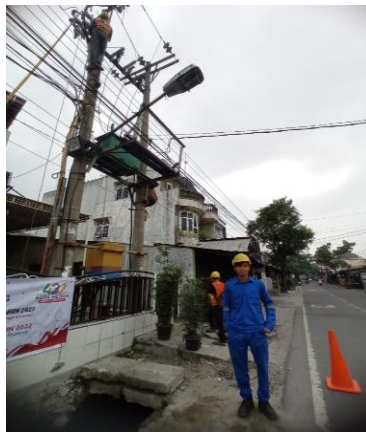
Gambar 2.17. Pemeliharaan Dan Pemangkasan JTM (Sumber : PT. PLN PERSERO ULP Medan Kota)
