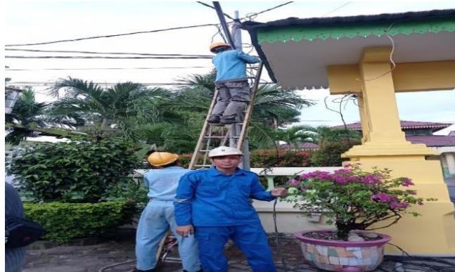
Gambar 2.1. Pemindahan Tiang (Sumber: PT. PLN PERSERO ULP Medan kota)
