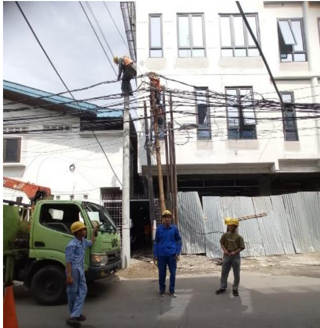
Gambar 2.36. Pemindahan Kabel Ketiang Beton (Sumber : PT. PLN PERSERO ULP Medan Kota)
